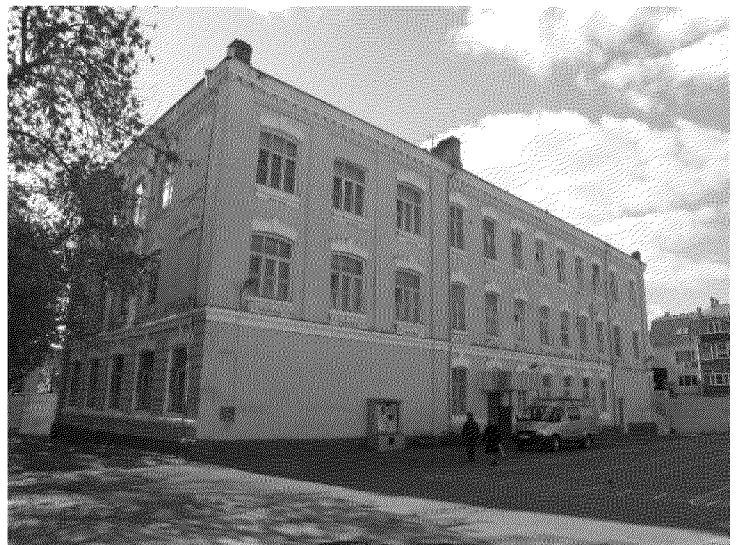
западный и северный фасады
