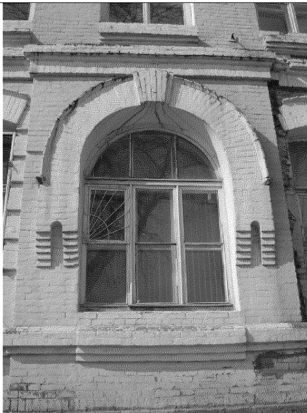
полуциркульный оконный проем западной раскреповки южного фасада;
