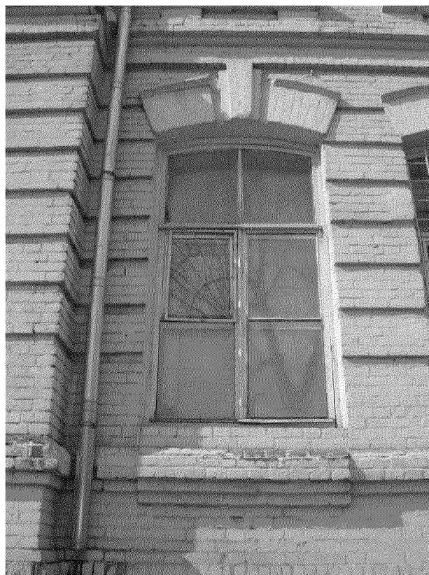
фрагмент главного южного фасада (оконный проем в уровне 1-го этажа);
