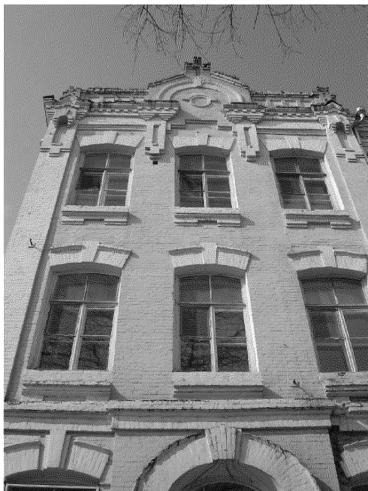
западная раскреповка южного фасада;
