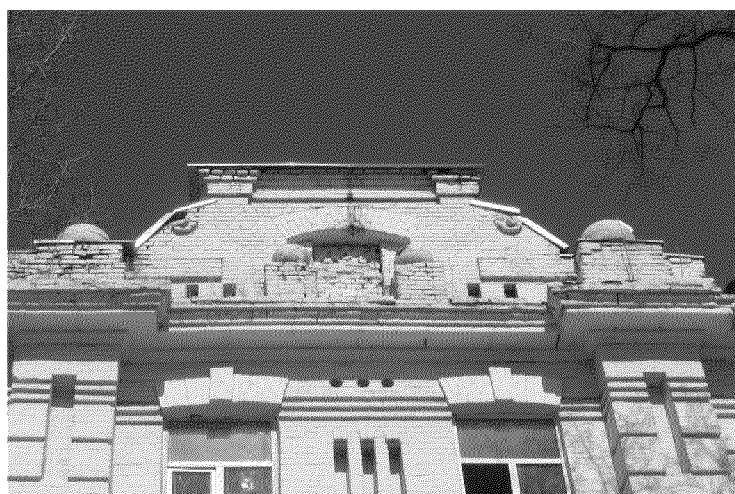
фрагмент западной раскреповки южного фасада;
