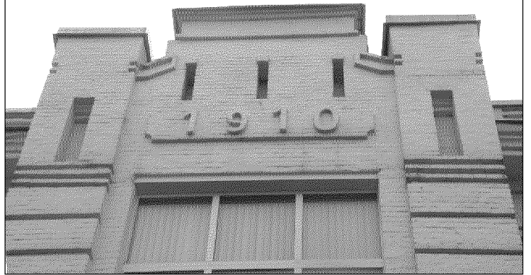
фрагмент раскреповки северного фасада объекта культурного наследия;
