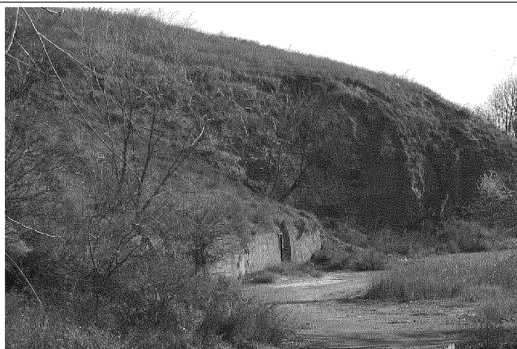
подпорная стенка склона балки в юго-восточной части объекта культурного наследия; вид с запада-северо-запада
