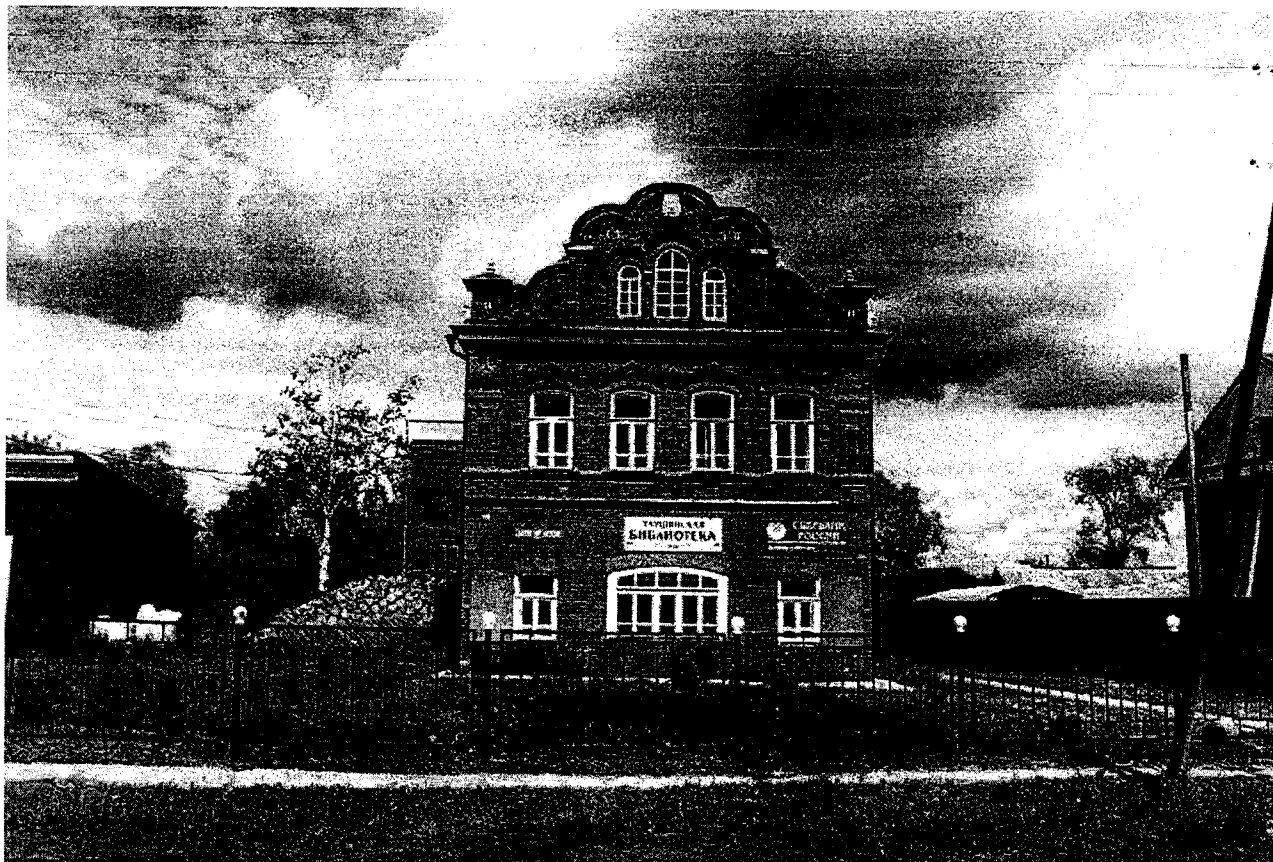
Южный фасад. Фото 15.06.2017 г.
