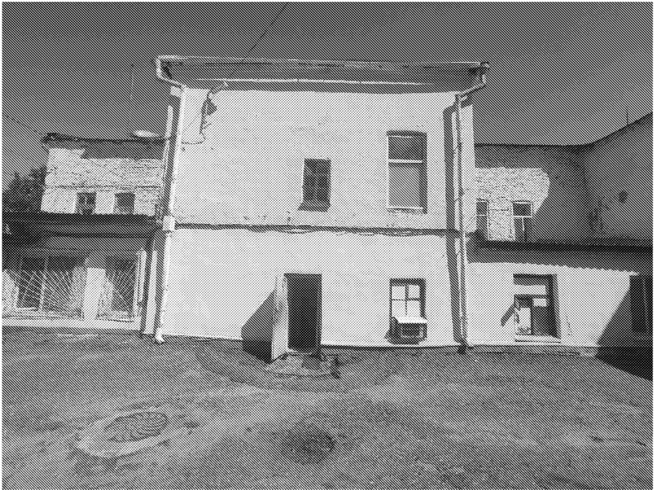
Фрагмент дворового фасада объекта культурного наследия
