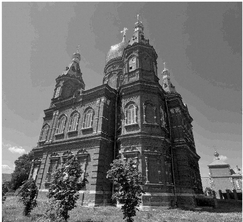
Северо-восточный фасад объекта культурного наследия
