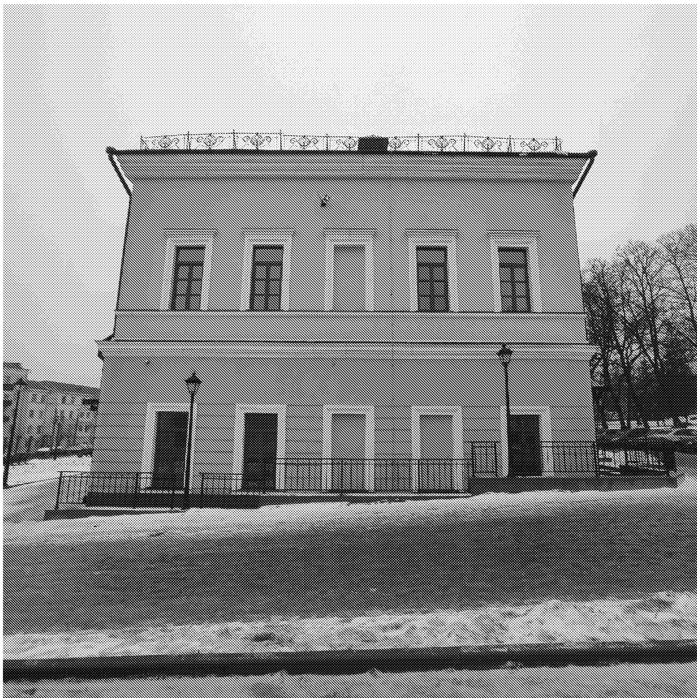
Вид на объект культурного наследия с северной стороны. Боковой фасад (23.12.2022)
