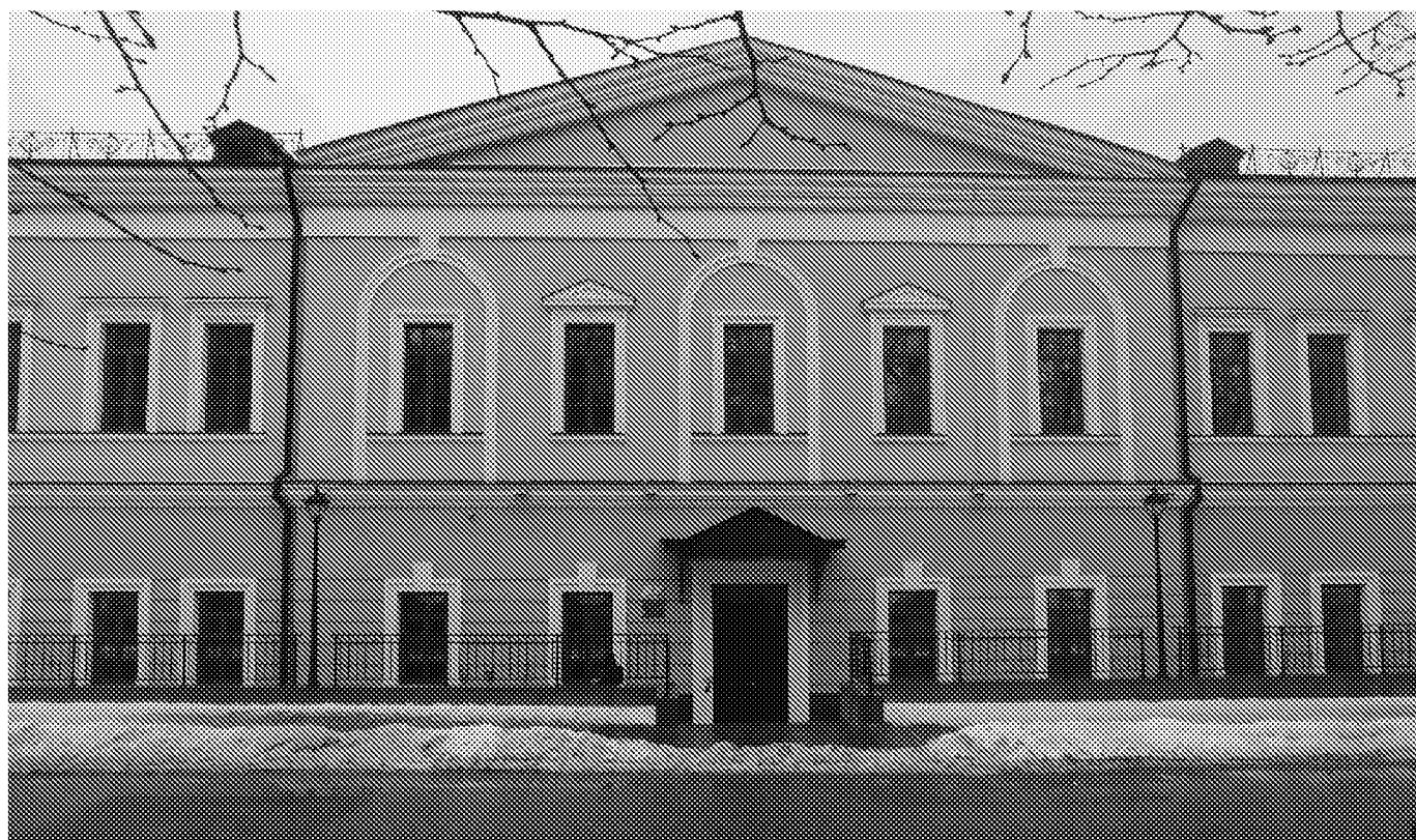
Фрагмент главного фасада объекта культурного наследия (со стороны улицы Белинского) (23.12.2022)
