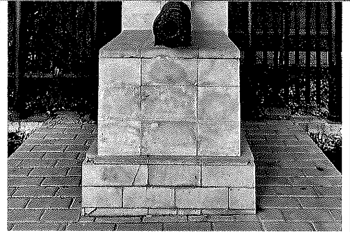
Общий вид объекта в северо-восточном направлении
