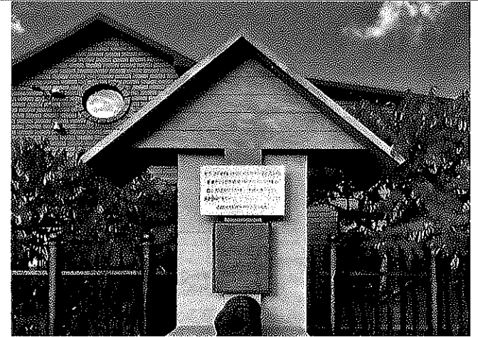
Общий вид объекта в северо-восточном направлении
