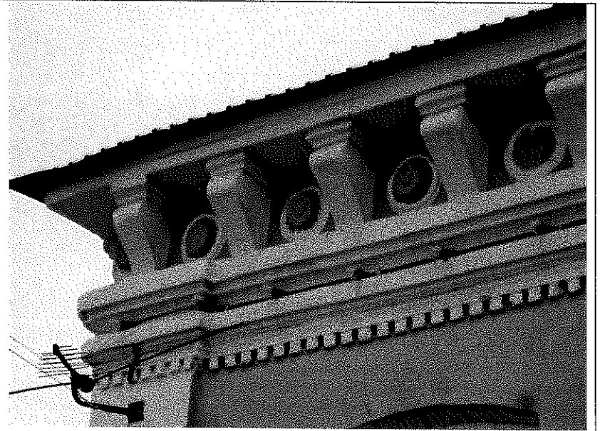
Вид с востока с ул. Рыбаковской. Детали фасада. Венчающий карниз
