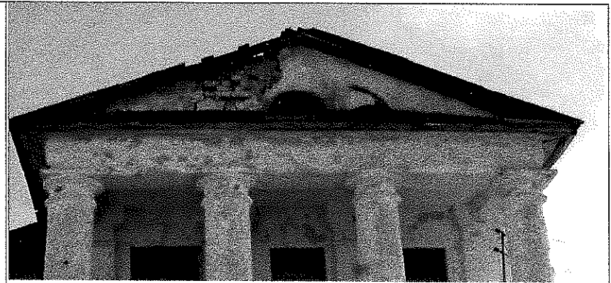
Вид с запада. Фрагмент верхней части портика главного входа
