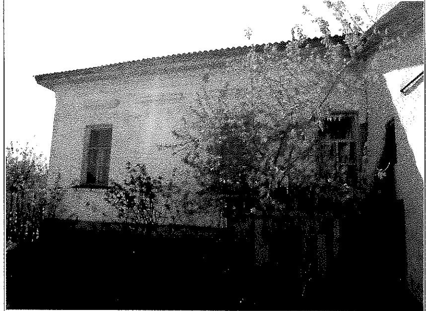
Вид с запада. Фрагмент стены главного фасада
