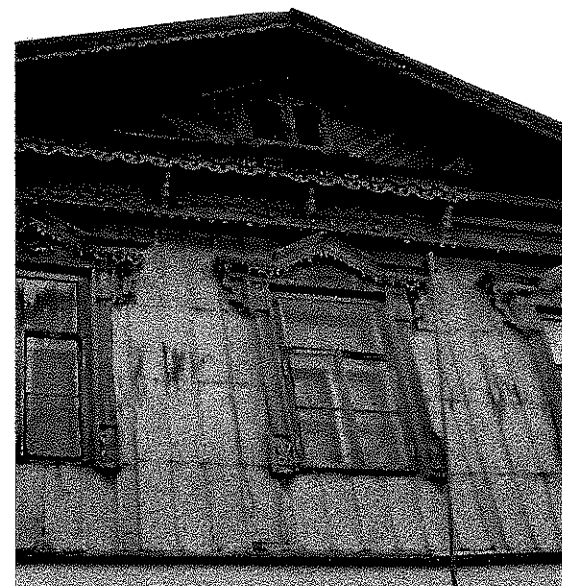
Вид с запада. Фрагмент фасада в уровне второго этажа
