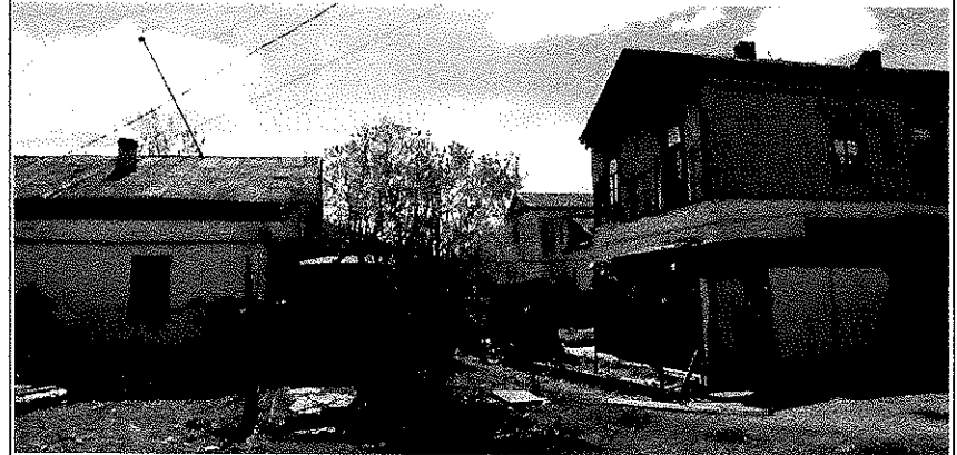
Вид с севера на жилую территорию усадебного ансамбля
