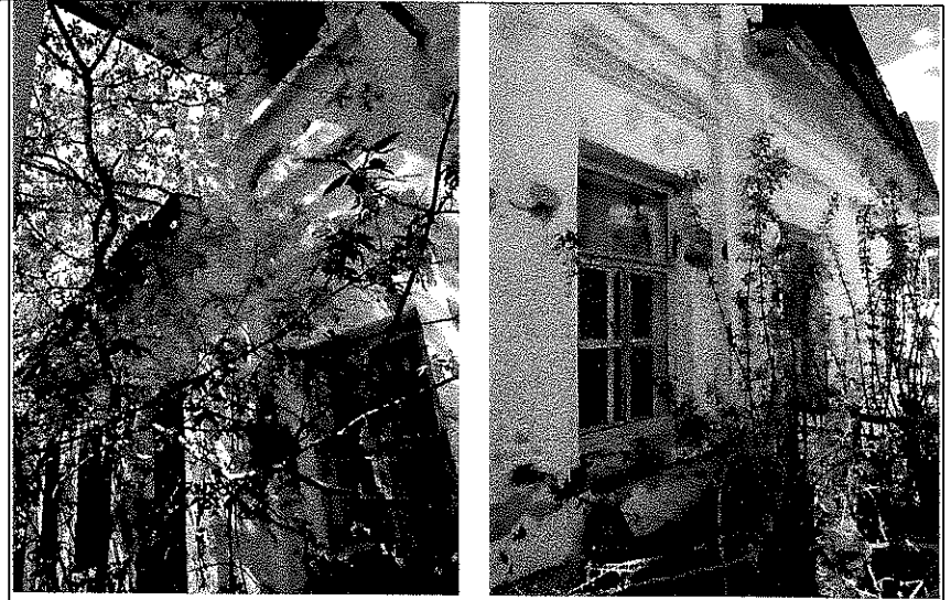
Вид с востока. Детали фасада
