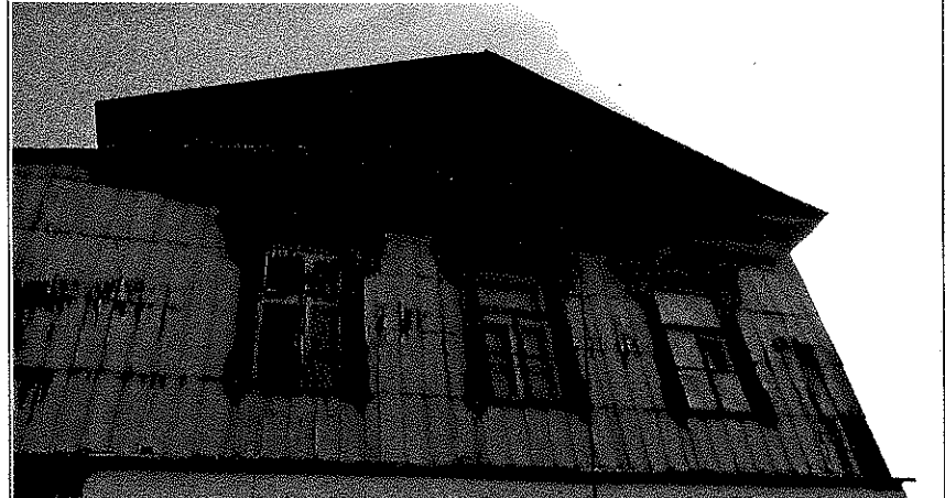
Вид с запада. Фрагмент фасада в уровне второго этажа
