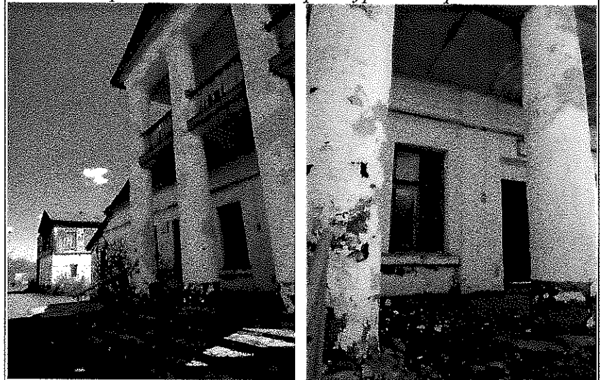
Вид с юго-запада. Портик главного входа
