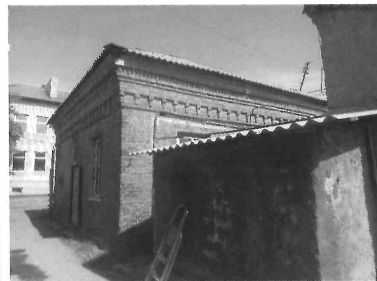
Венчающий карниз дворового фасада
