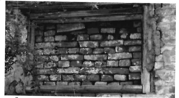
Заложенный проем, габариты, расположение
