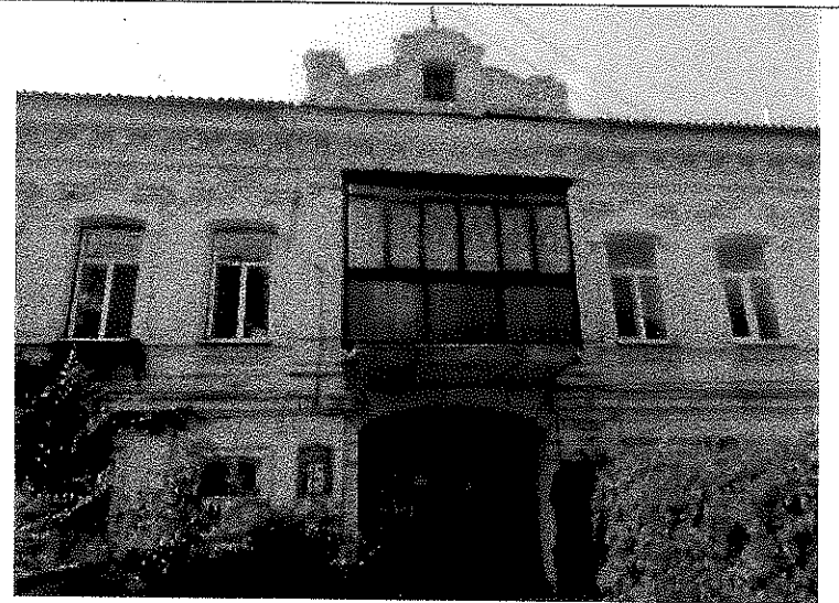
Венчающий карниз, кессонированная балконная плита
