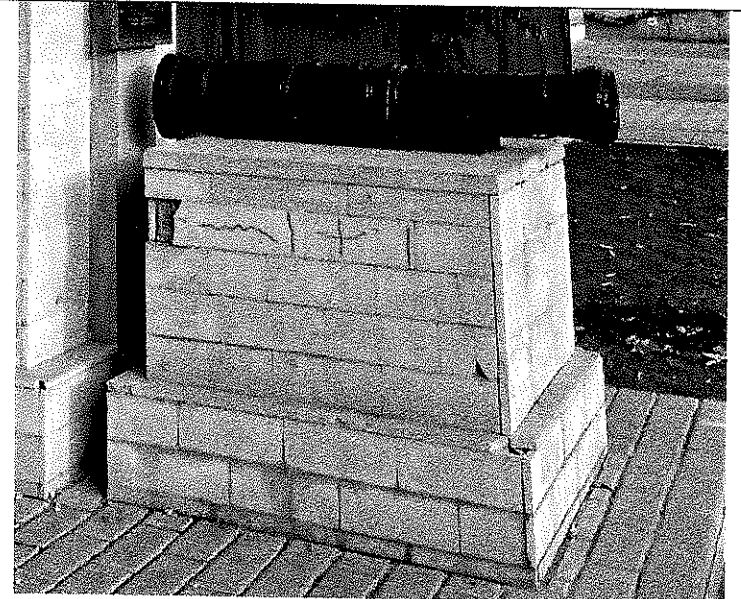
Общий вид объекта в юго-восточном направлении
