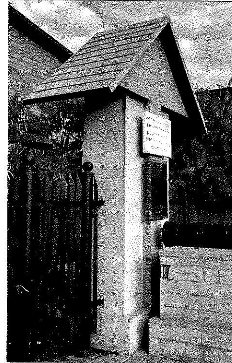
Общий вид объекта в юго-восточном направлении
