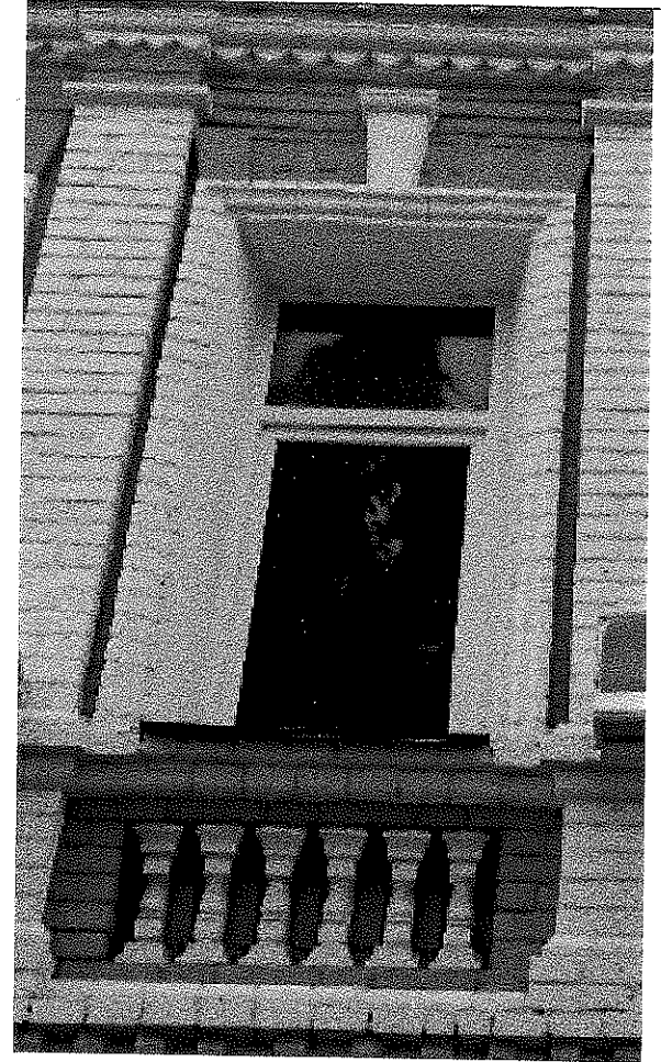
Оконный проем второго этажа. Северный фасад.
