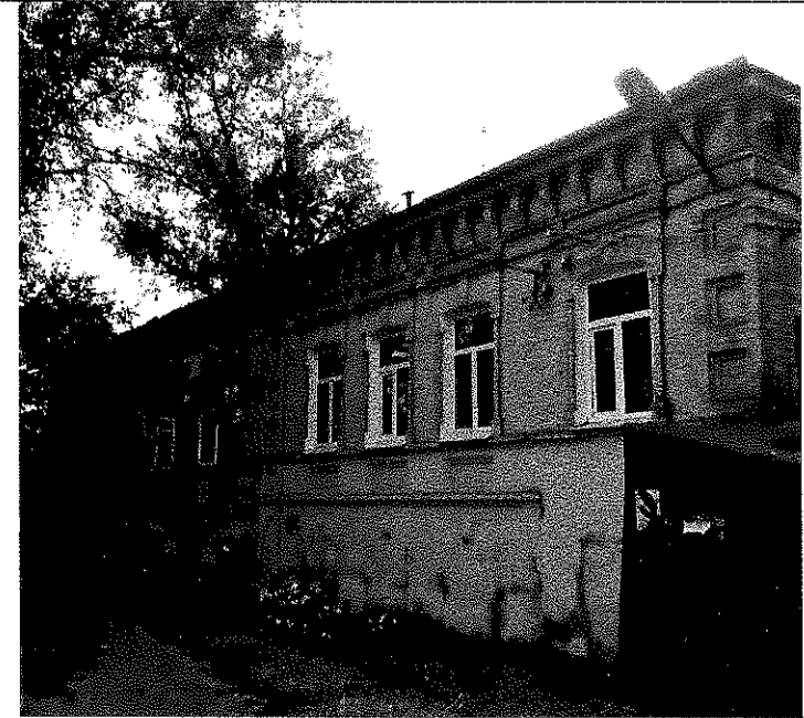
Вид на фасад с северо-востока
