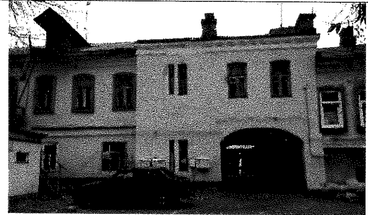
Часть западного фасада (Литера А3, А4)
