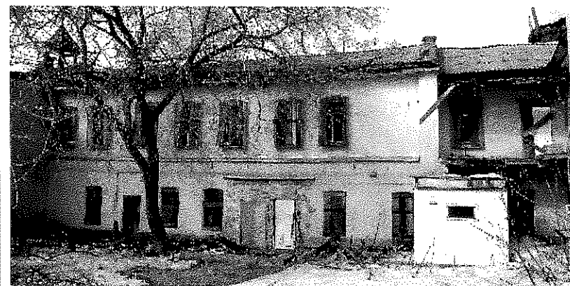
Часть фасада (Литера А4).
