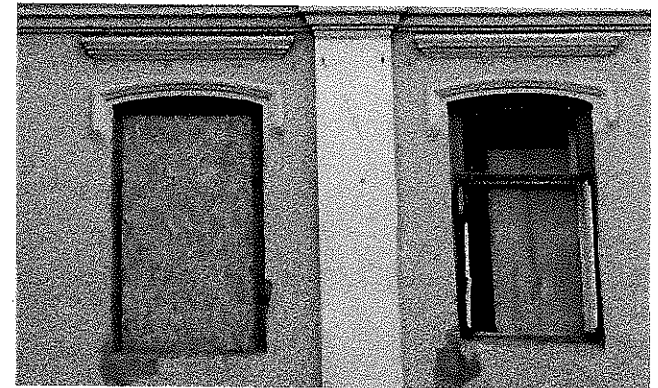
Оконные проемы первого этажа. Северный фасад (Литера А5).
