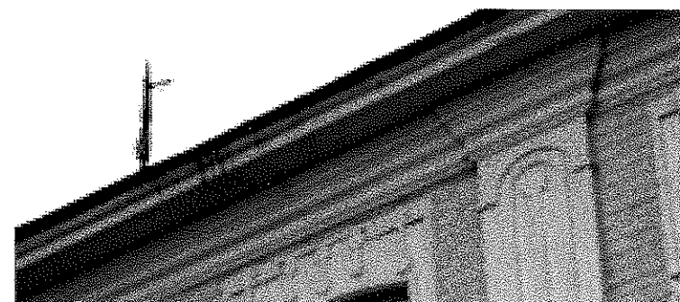
Венчающий карниз. Северный фасад (Литера А5).
