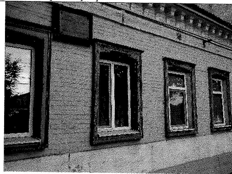
Вид на Объект с северо-запада.
