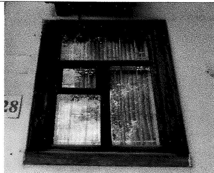
Западный фасад, фрагмент.
