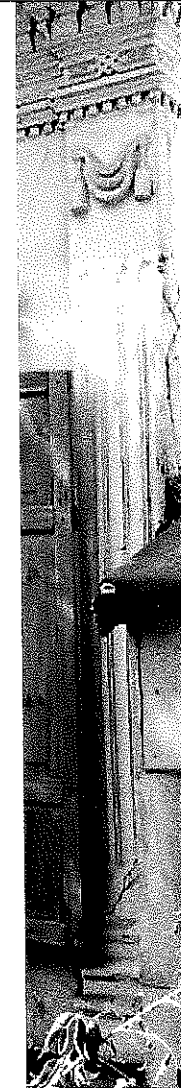
Пилястра. Южный фасад
