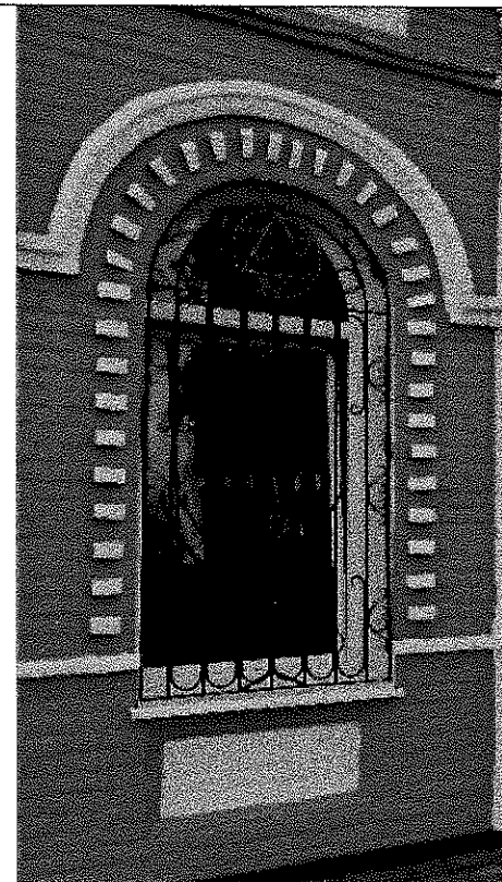
Обрамление оконного проема.
