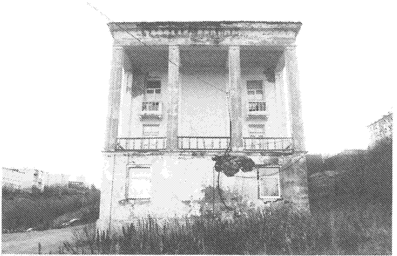
Фото 6. Северо-восточный торцевой фасад. Дата: 14.10.2021
