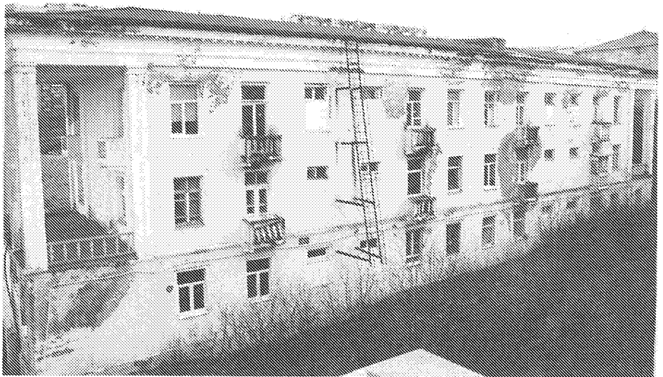
Фото 5. Северо-западный фасад. Дата: 14.10.2021
