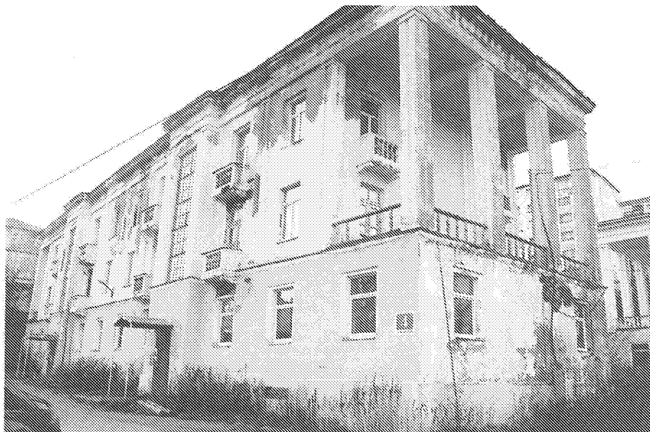
Фото 1. Северо-восточный торцевой и юго-восточный фасад. Дата: 14.10.2021
