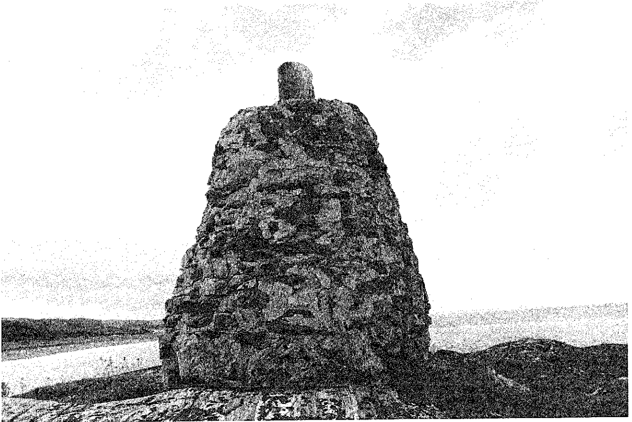
Фото 5. Общий вид. Восточная сторона. Дата: 2020 год.
