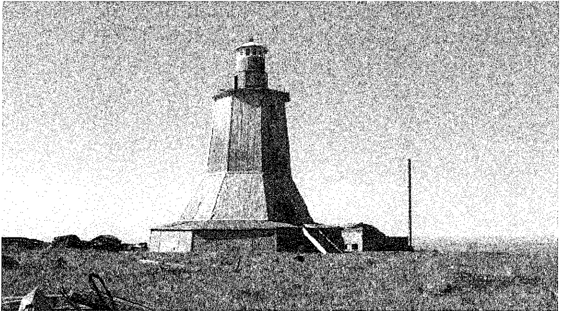
Фото 2. Общий вид здания маяка с юго-запада. Дата: 2018 г.
