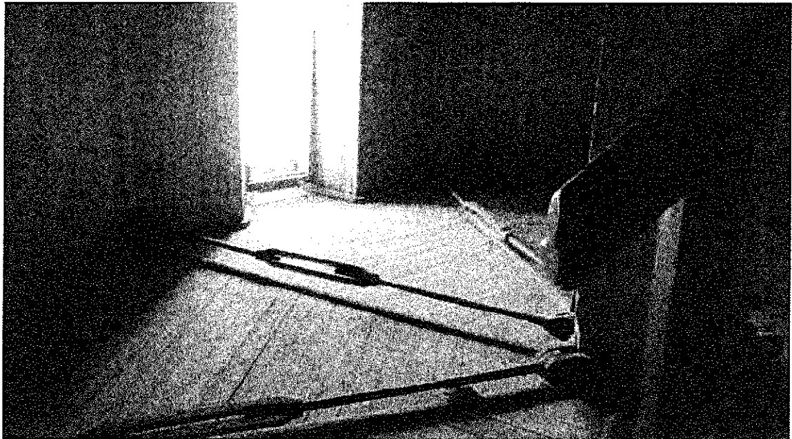
Фото 14. Интерьер здания маяка. Внутренние конструкции и оконный проем. Дата: 2018 г.
