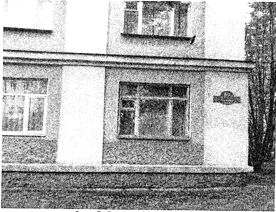
Фото 7. Отделка фасадов здания
