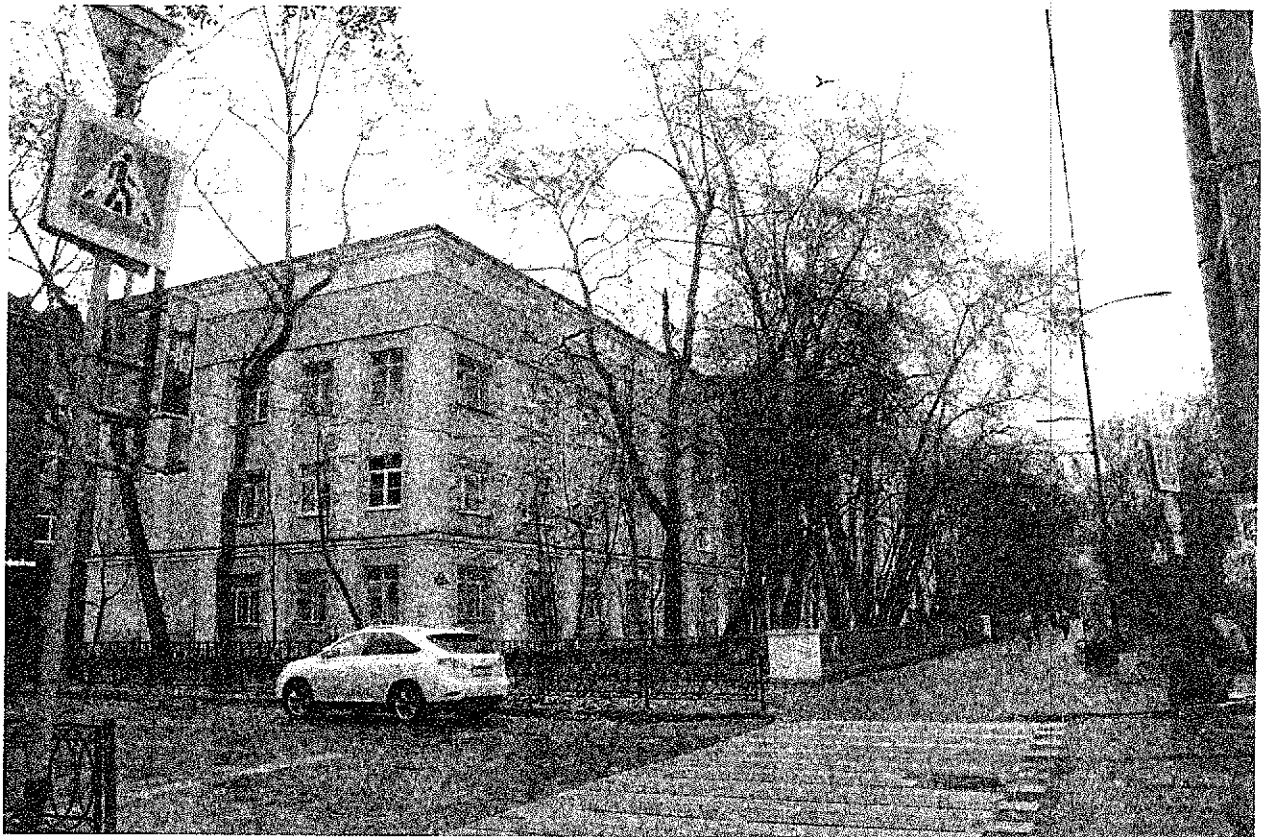
Фото 2. Северная часть западного фасада и северный фасад здания. Дата: 12.10.2021
