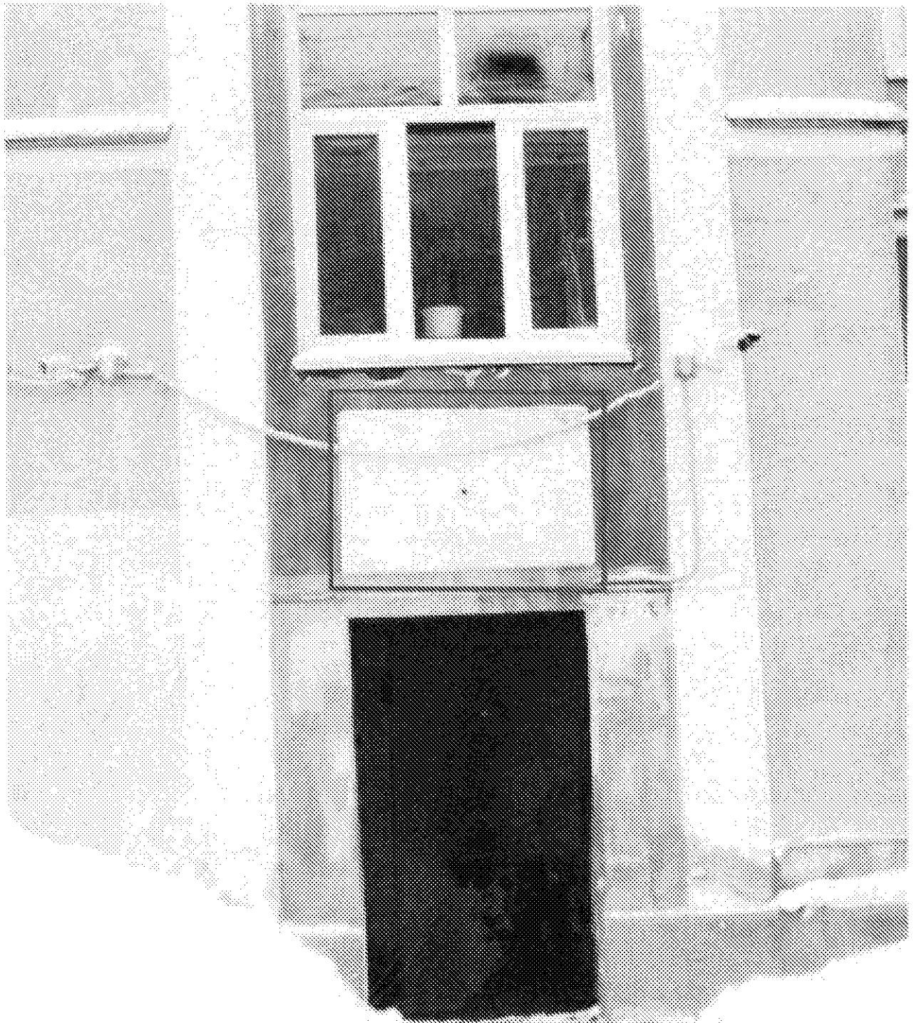
Фото 44. Фасад в южной части восточного фасада. Рязань. Дата: 17.02.2021
