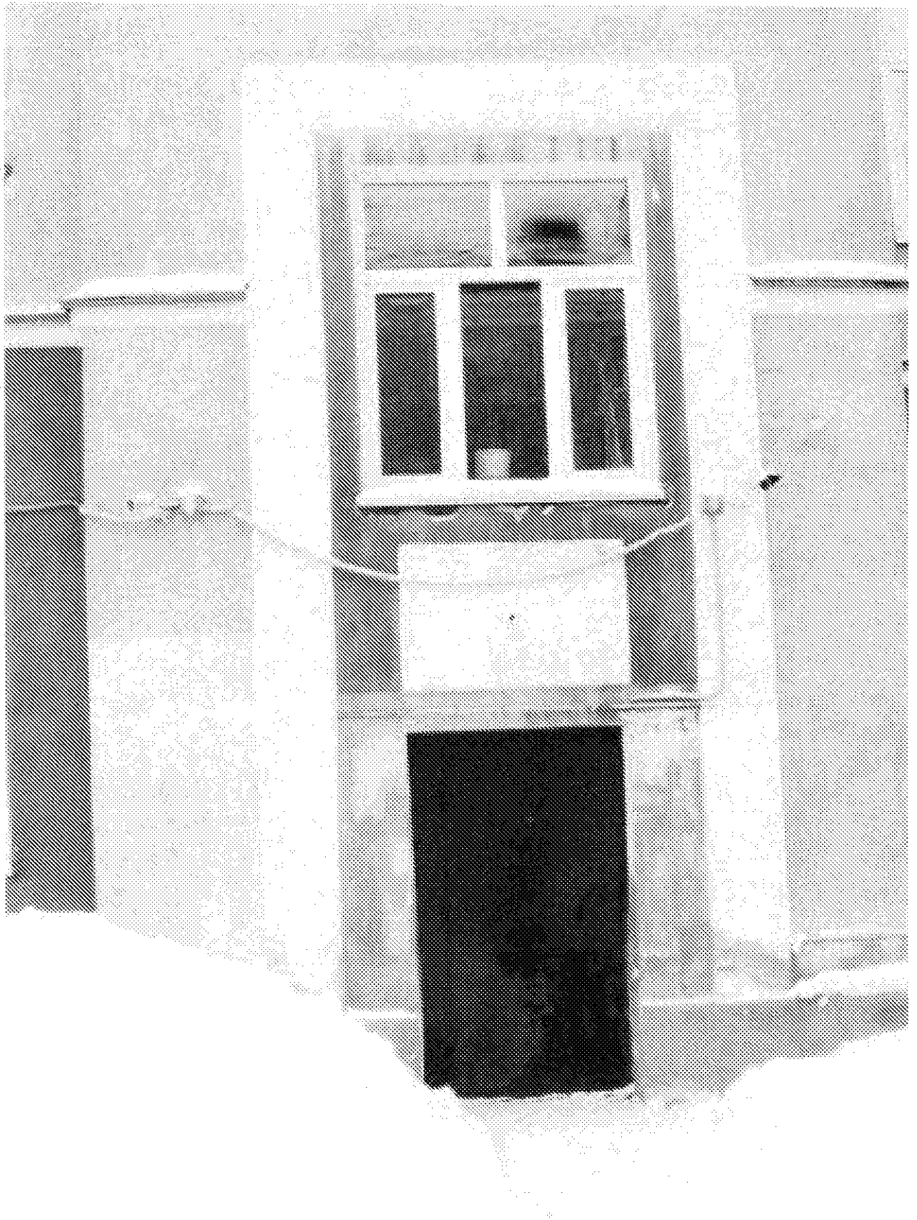
Фото 42. Профилированный наливчик в нижней части восточного фасада. Ремонт. Дата: 17.02.2021
