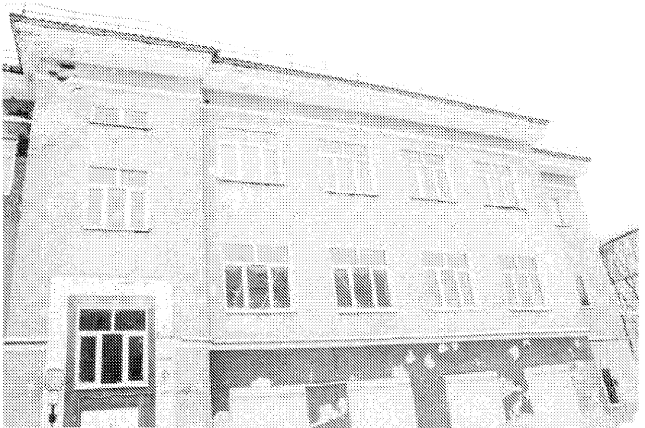
Фото 13. Северный ризалит восточного фасада здания. Оконные проемы. Дата: 17.02.2021
