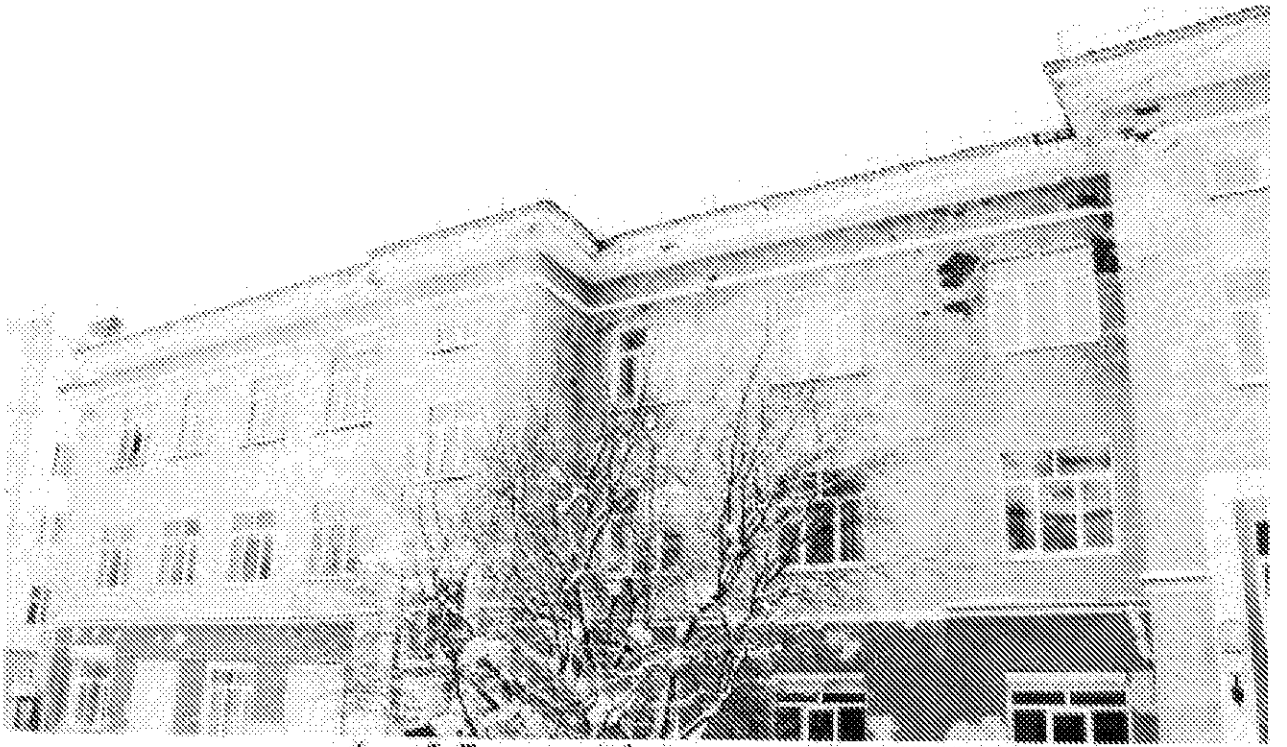
Фото 3. Восточный фасад здания. Дата: 17.02.2021
