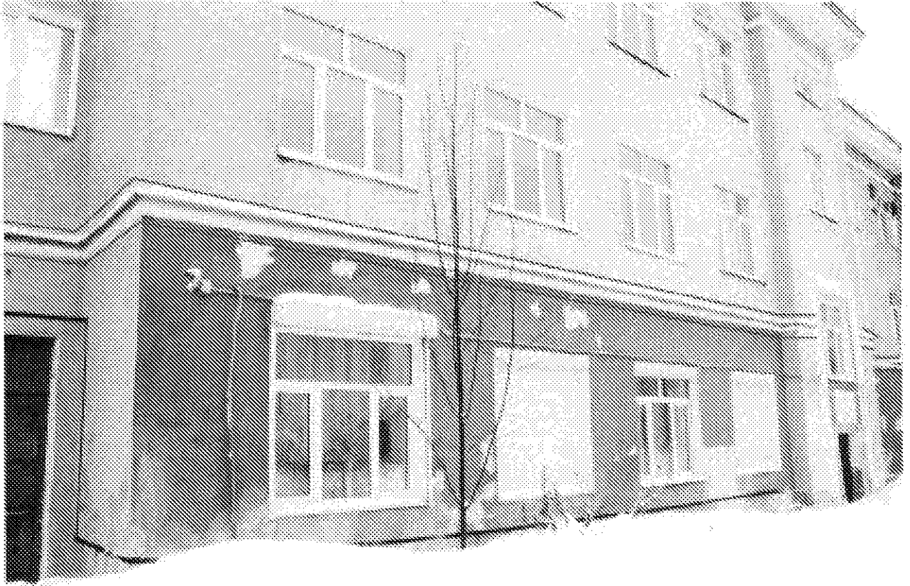
Фото 19. Профилированная межэтажная галка. Вид на южный фасадит. Восточный фасад. Дата: 17.02.2021
