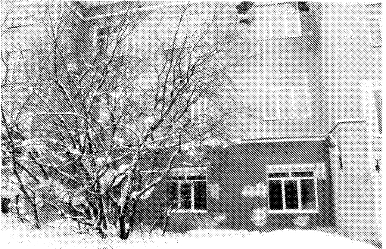
Фото 12. Оконные проемы. Центральная часть восточного фасада здания. Дата: 17.02.2021
