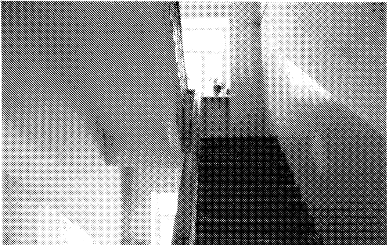
Фото 46. Лестничная клетка. Дата: 17.02.2021
