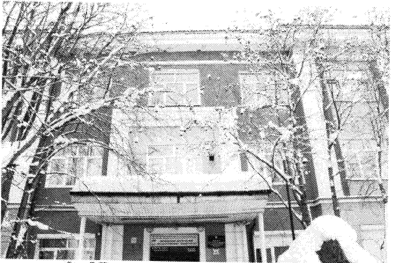
Фото 7. Центральная часть западного фасада здания. Дата: 17.02.2021
