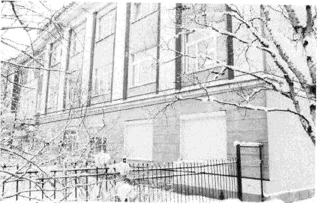
Фото 23. Профилированная межэтажная тяга. Западная и часть южного фасада здания. Дата: 17.02.2021
