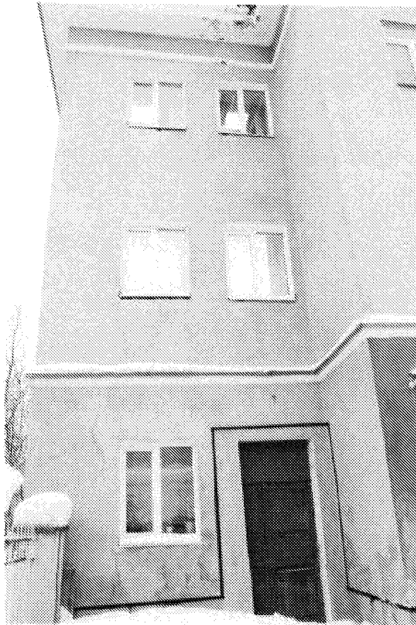
Фото 9. Южная часть восточного фасада здания. Оконные проемы. Дата: 17.02.2021
