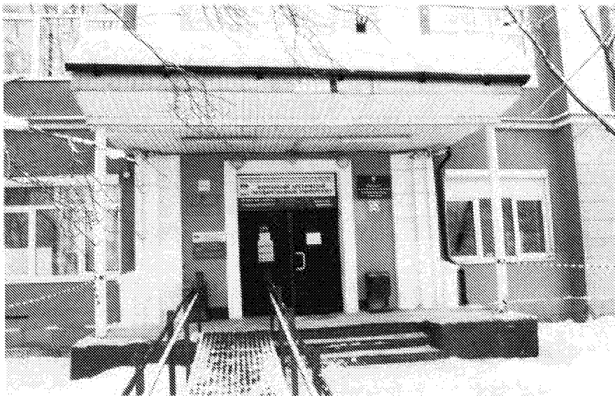
Фото 48. Вид на крыльцо. Центральная часть западного фасада. Дата: 17.02.2021
