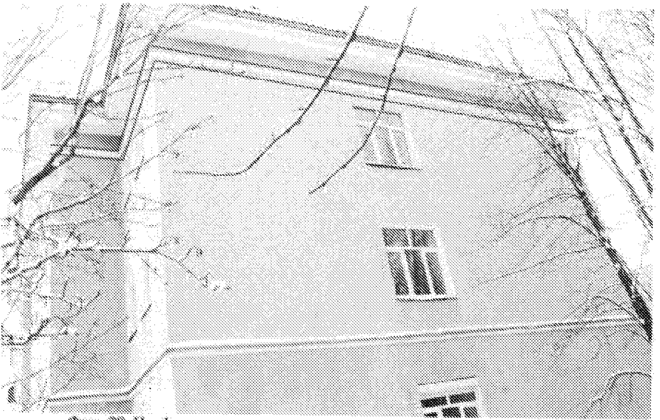
Фото 29. Профилированная межэтажная тяга над окномными проемами 3-го этажа. Северный торцевой фасад и часть восточного фасада. Дата: 17.02.2021
