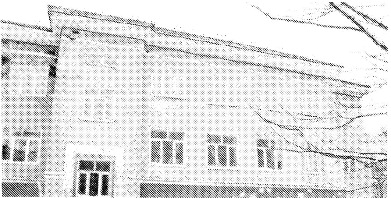
Фото 35. Профилированный венчающий карниз. Восточный фасад. Дата: 17.02.2021
