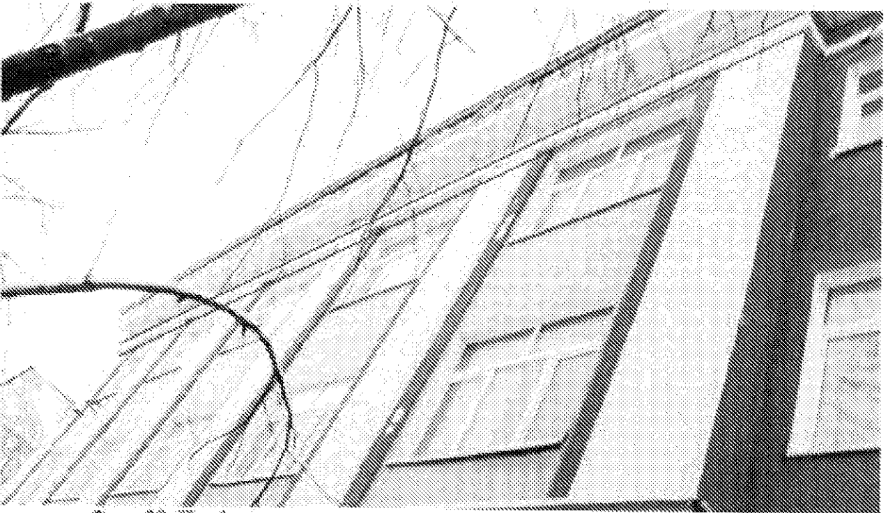
Фото 30. Профилированная межэтажная тяга над окномными проемами 3-го этажа. Северная часть западного фасада. Дата: 17.02.2021
