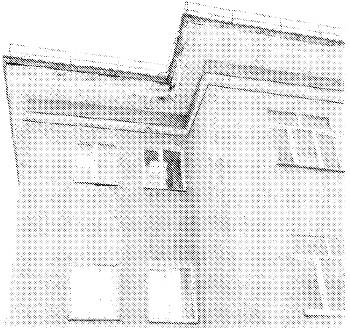
Фото 25. Профилированная межэтажная тяга над оконными проемами 3-го этажа. Южная сторона восточного фасада. Дата: 17.02.2021
