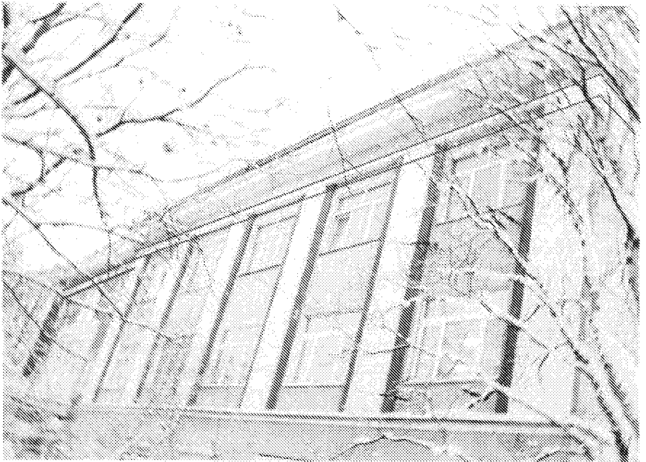
Фото 32. Профилированная межэтажная титя над оконными проемами 3-го этажа. Южная часть западного фасада. Дата: 17.02.2021
