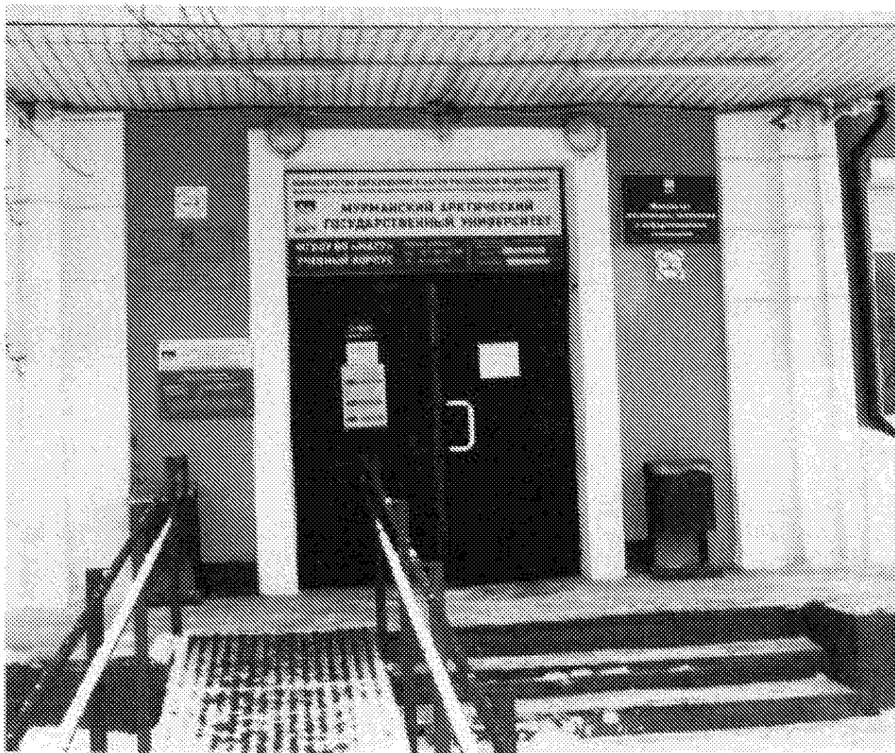
Фото 14. Дверной проем в центральной части западного фасада и уровне 1-го этажа. Дата: 17.02.2021
