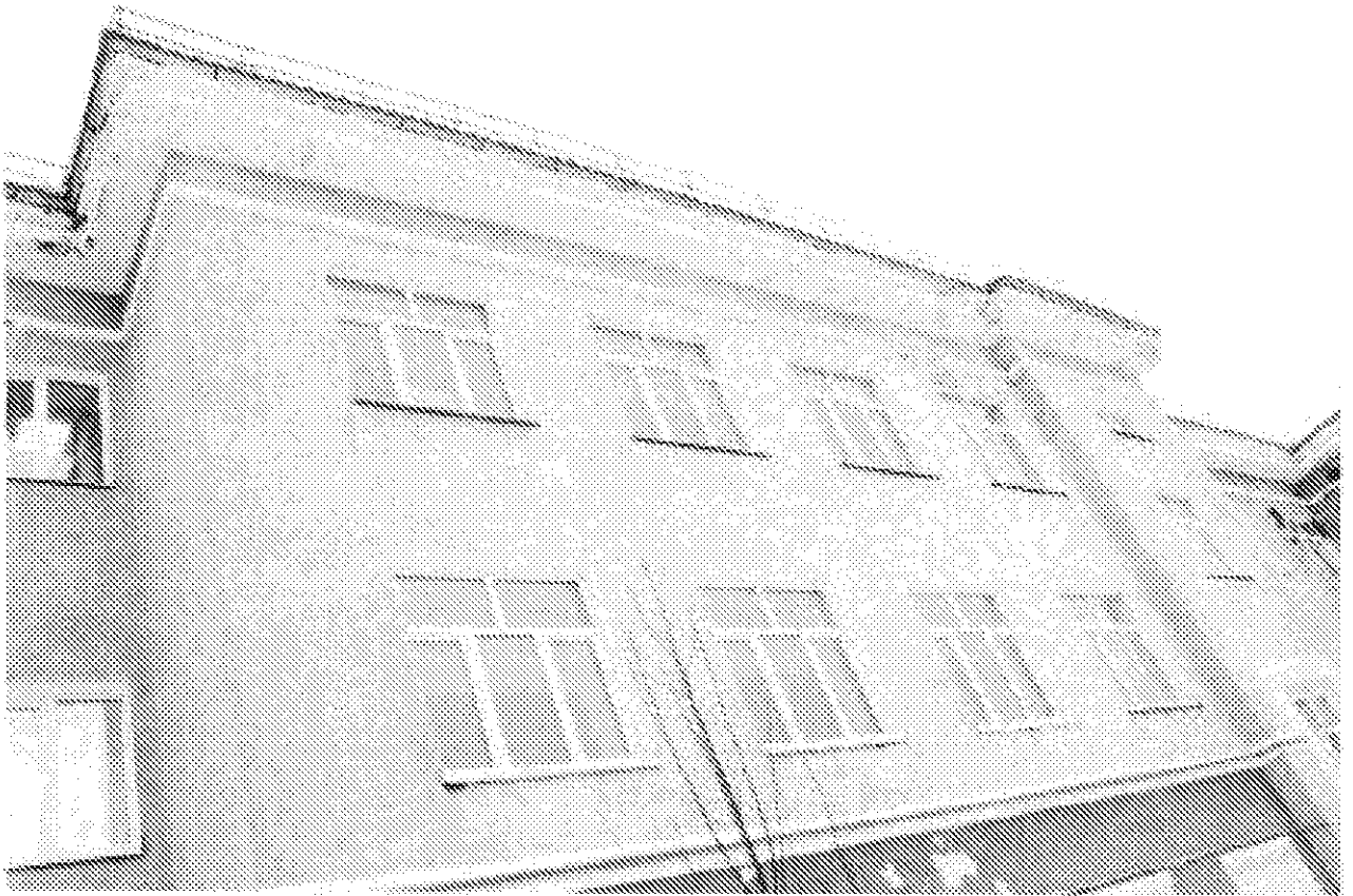
Фото 10. Южный ризалит восточного фасада здания. Оконные проемы. Дата: 17.02.2021
