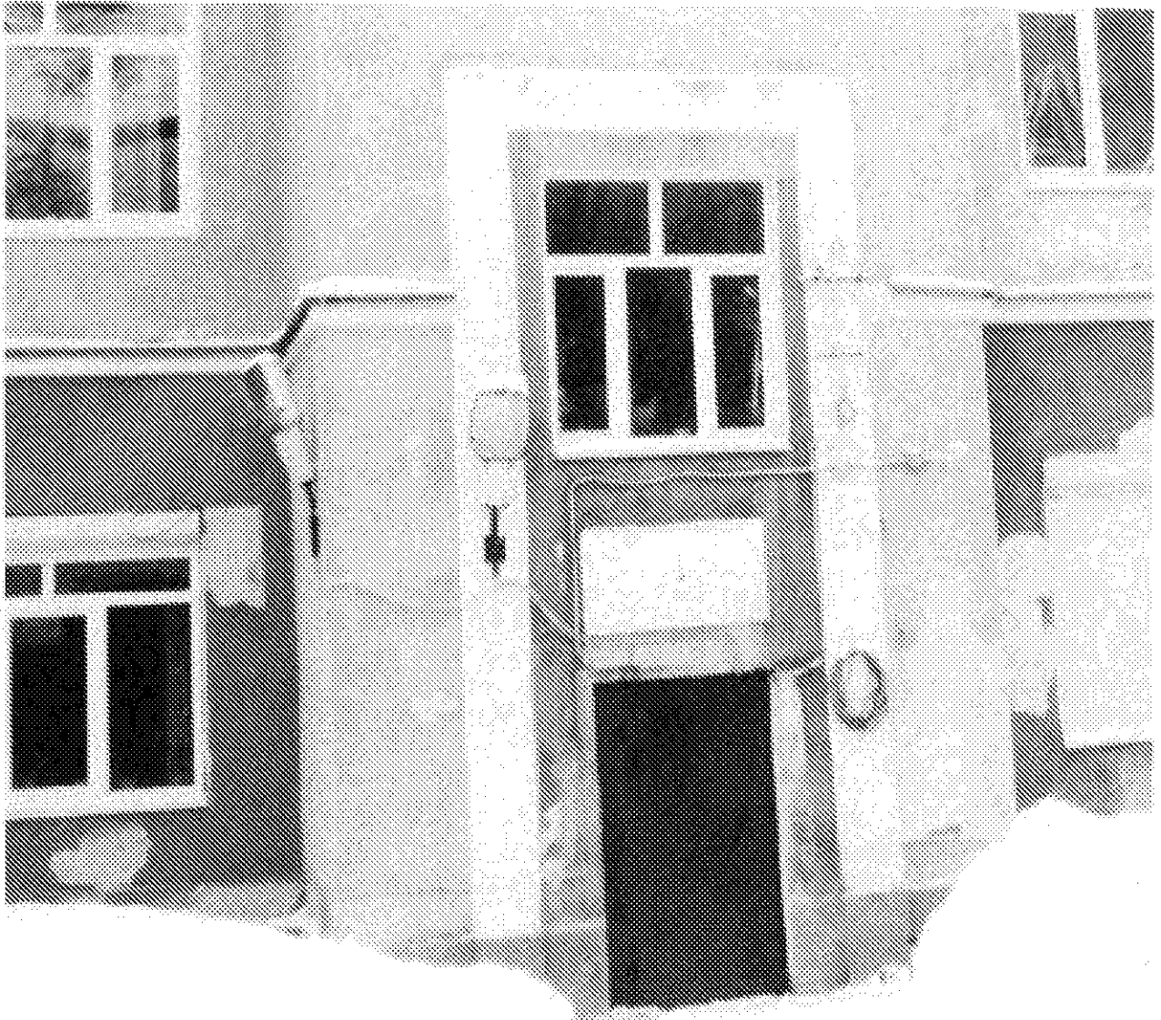
Фото 43. Профилированный напечник в северной части восточного фасада. Рязань. Дата: 17.02.2021
