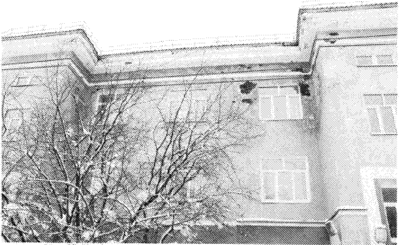
Фото 27. Профилированная межэтажная тяга над окномными проемами 3-го этажа. Центральная сторона восточного фасада. Дата: 17.02.2021
