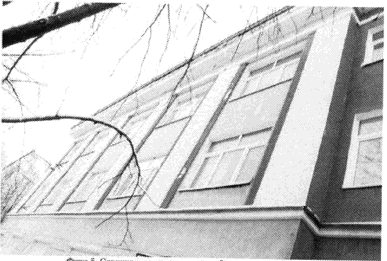
Фото 5. Северная сторона заднего фасада здания. Дата: 17.02.2021
