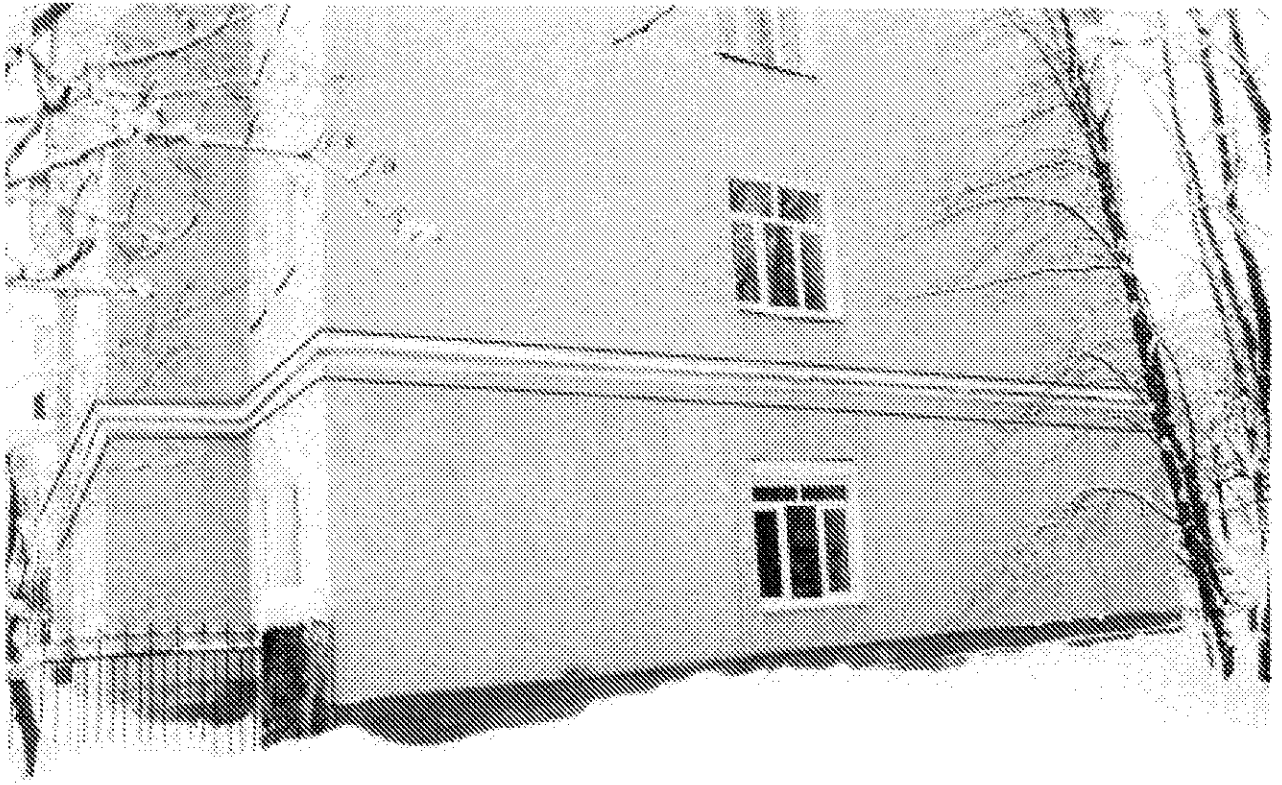
Фото 21. Профилированная металлическая теля. Северная торцевой и части восточного фасадов. Дата: 17.02.2021
