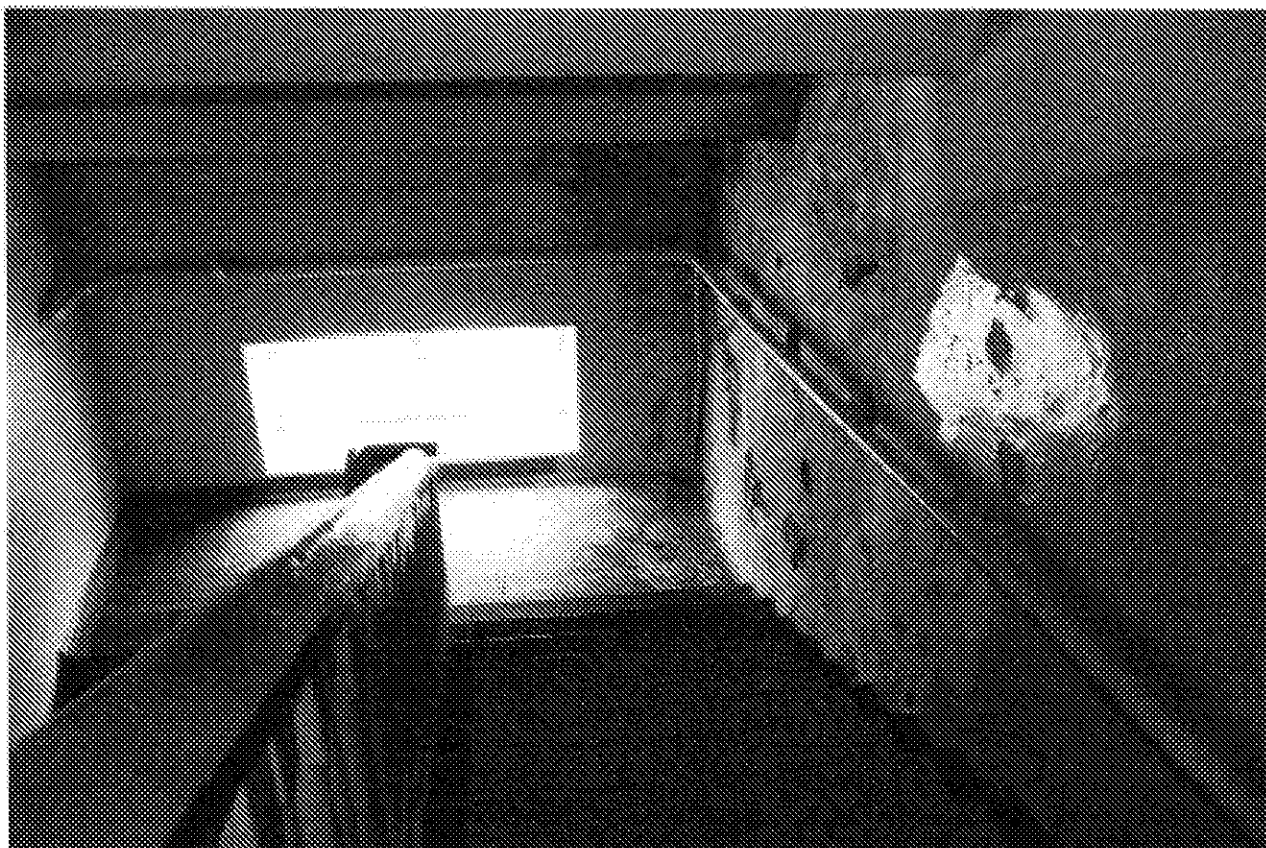
Фото 47. Лестничная клетка. Дата: 17.02.2021
