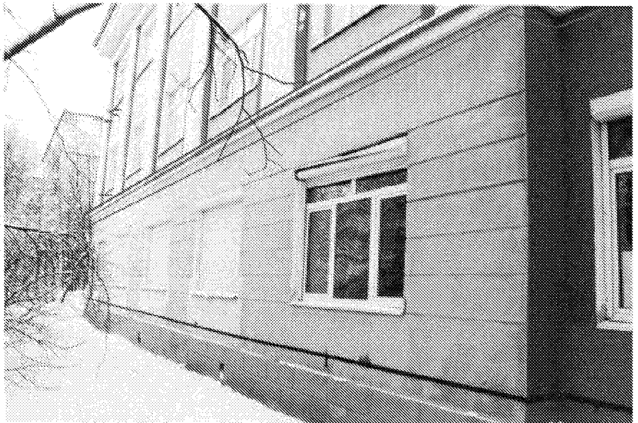
Фото 22. Профилированная металлическая теля. Западный фасад. Дата: 17.02.2021
