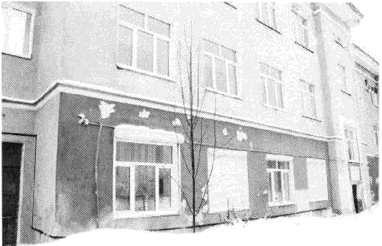
Фото 11. Южный ризалит восточного фасада здания. Оконные проемы. Дата: 17.02.2021
