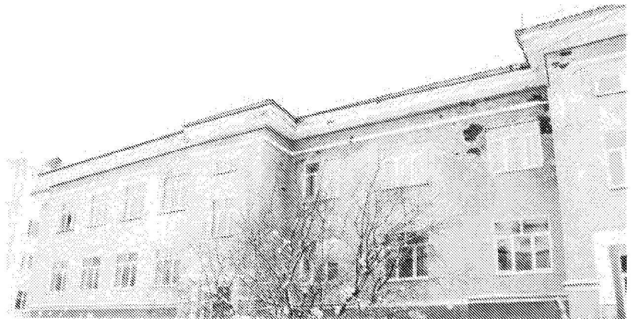
Фото 34. Профилированный ветрованный карниз. Восточный фасад. Дата: 17.02.2021
