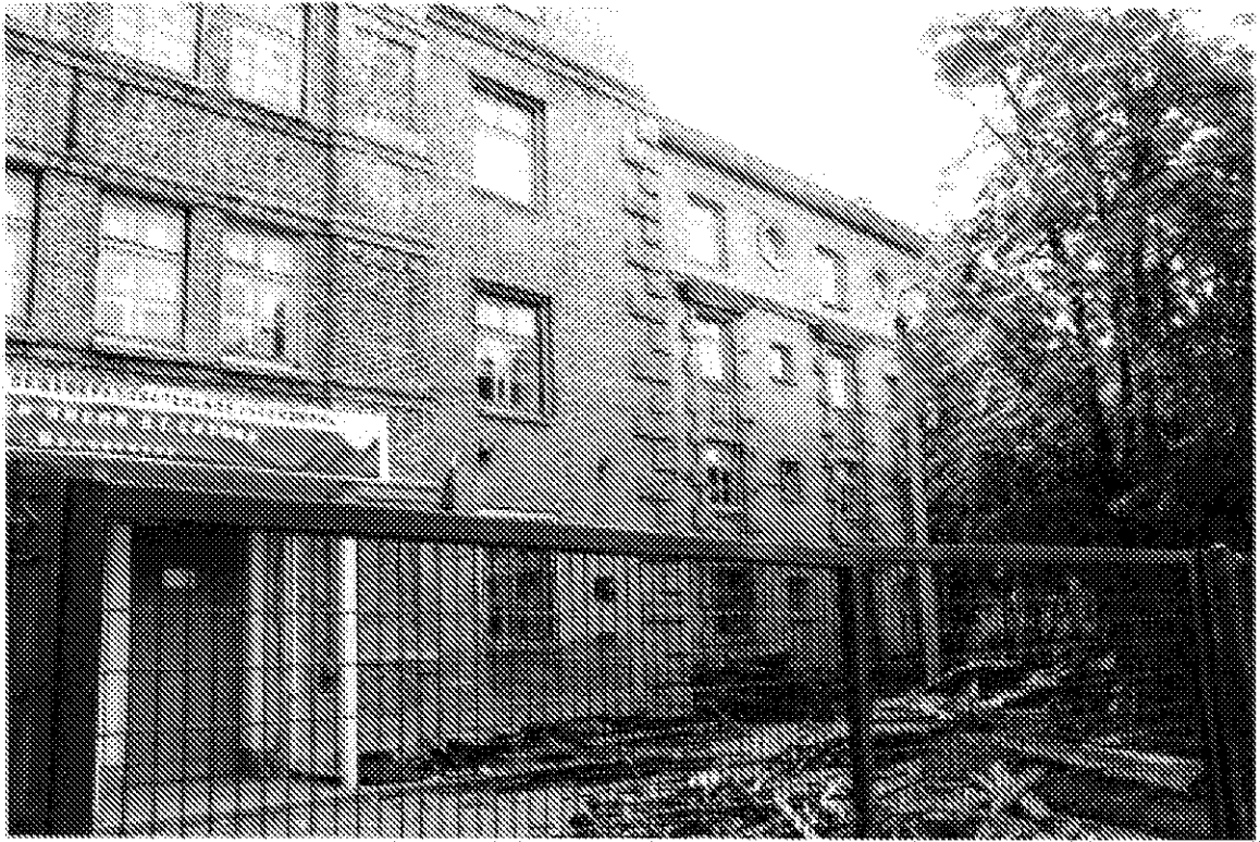
Фото 2. Главный северный фасад. Западная часть
