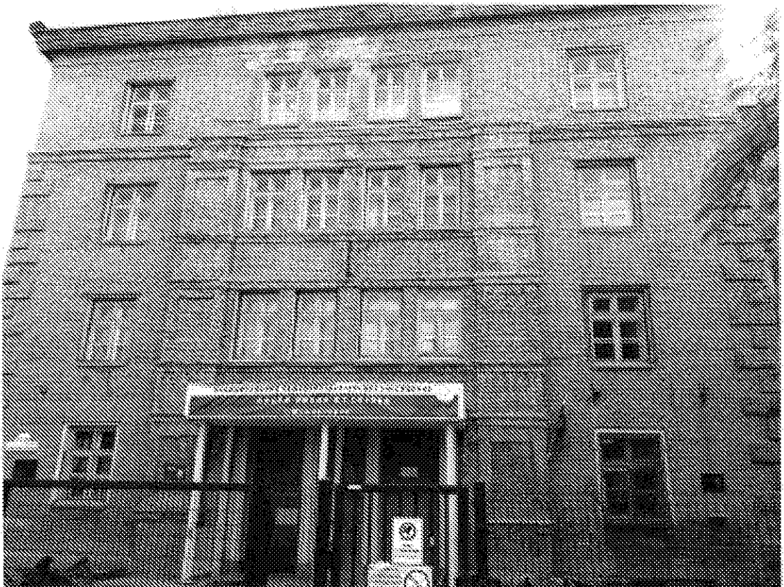
Фото 1. Главная северная фасад, Восточная часть.
