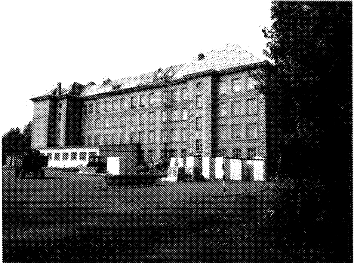
Фото 4. Дворовый южный фасад
