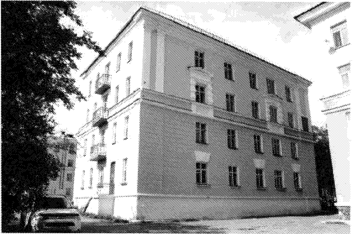
Фото 6. Вид на восточный фасад
