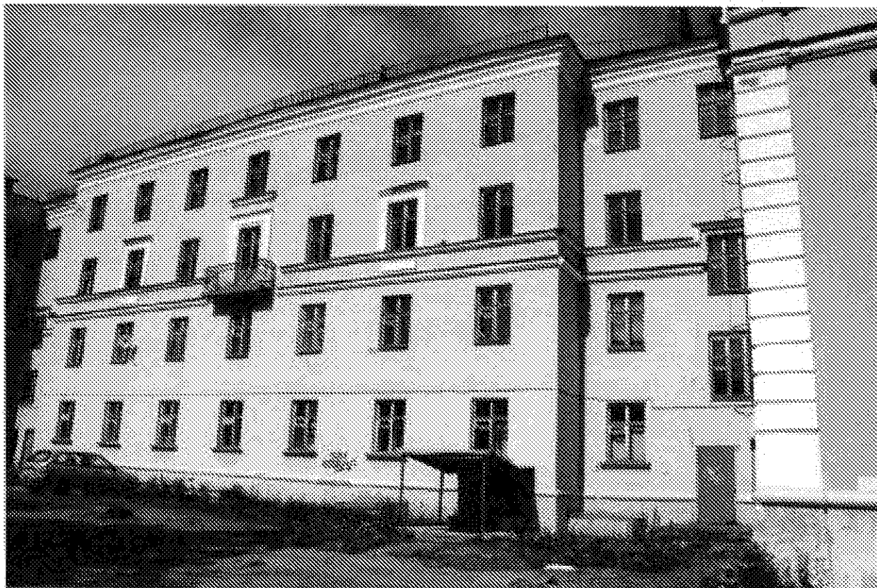
Фото 4. Вид на южный фасад с юго-востока.
