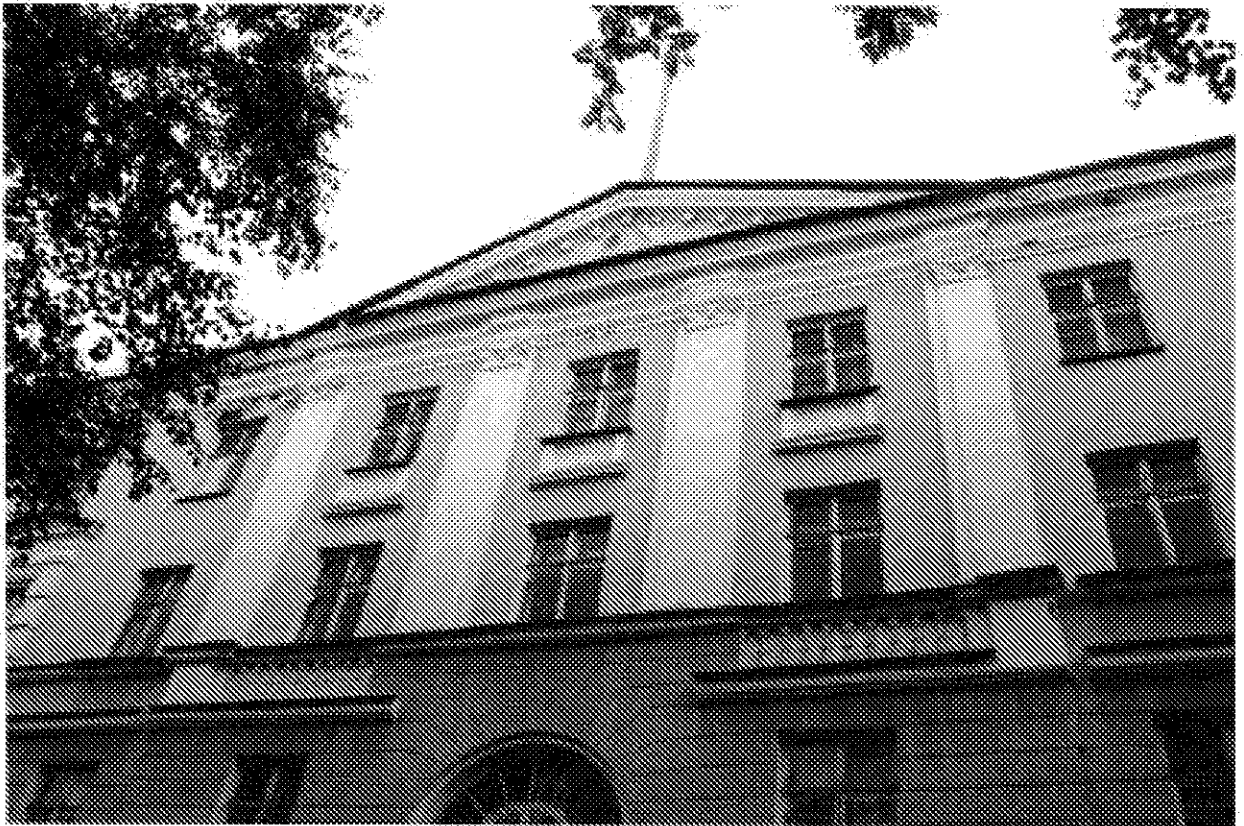
Фото 7. Вид на центральную часть северного фасада
