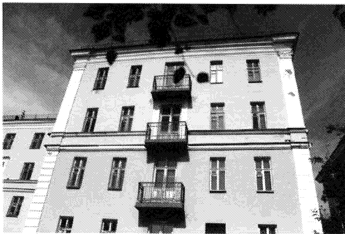
Фото 5. Вид на южный фасад восточного крыла.
