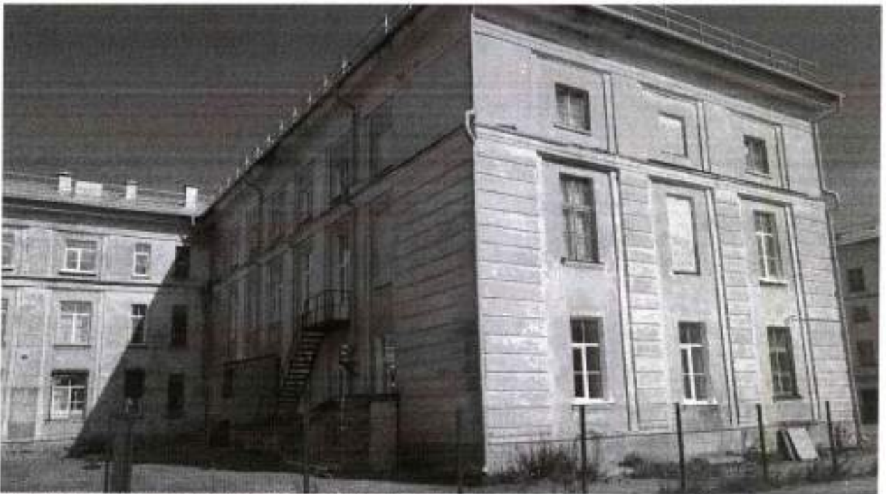
Фото 11. Вид на южный и западный фасады центрального крыла с южной стороны здания
