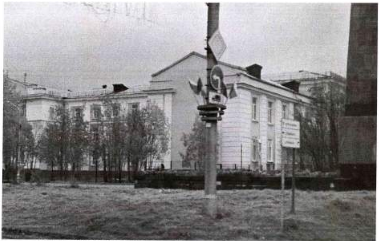
Фото 9. Вид с запада на северный и западный фасады западного крыла.
