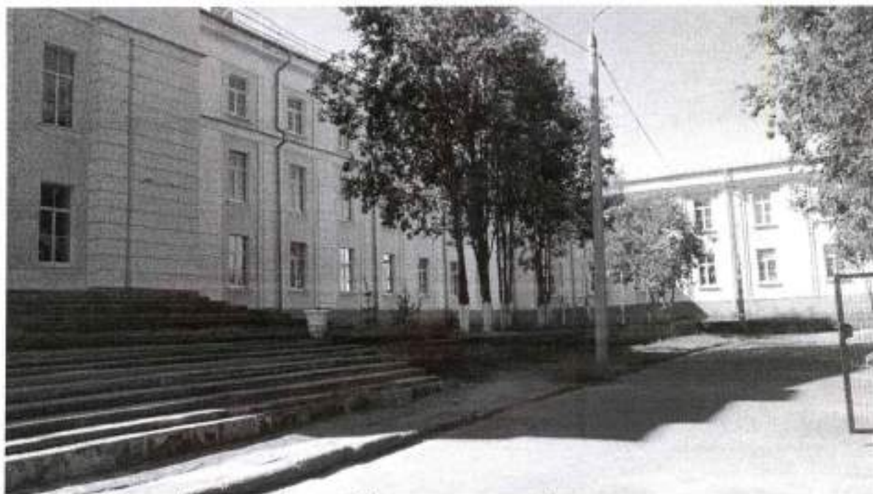
Фото 4. Вид на северный фасад и восточный фасад западного крыла
