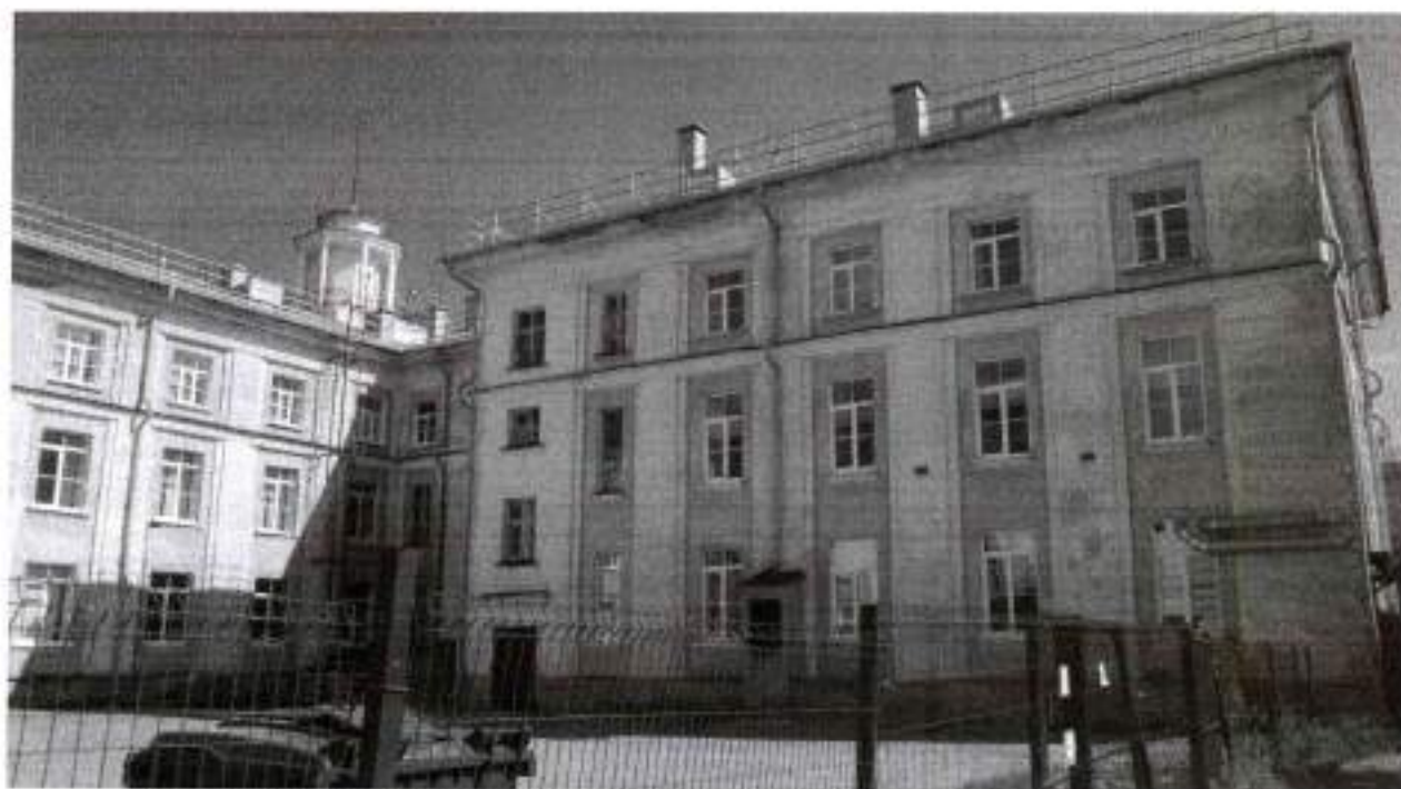
Фото 13. Вид на западный фасад восточного крыла с южной стороны здания
