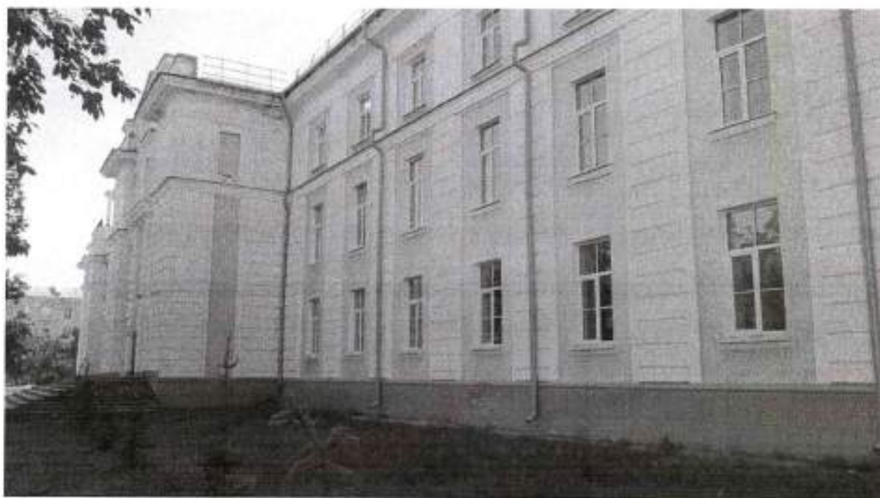
Фото 5. Вид на северный фасад с запада
