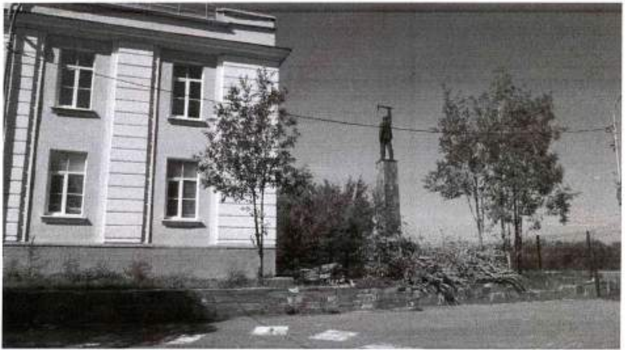
Фото 6. Вид на часть восточного фасада западного крыла и памятник «Покорителям Мончегондры»
