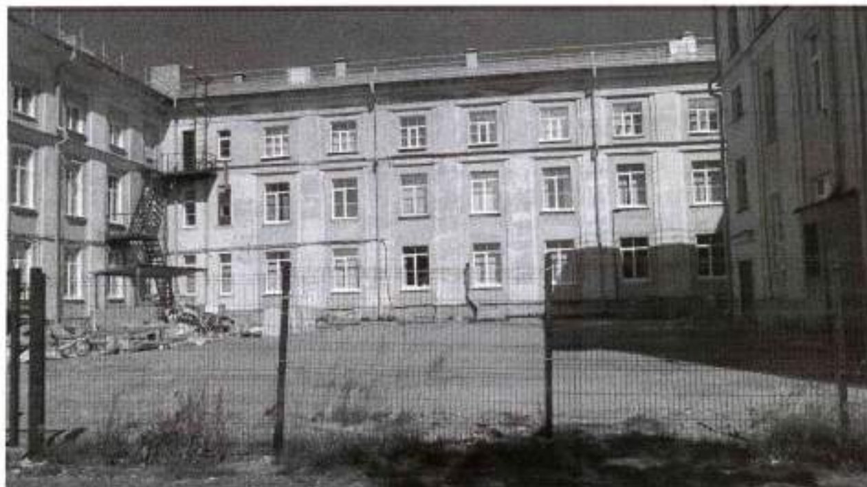
Фото 12. Вид на восточную часть южного фасада основного объема здания
