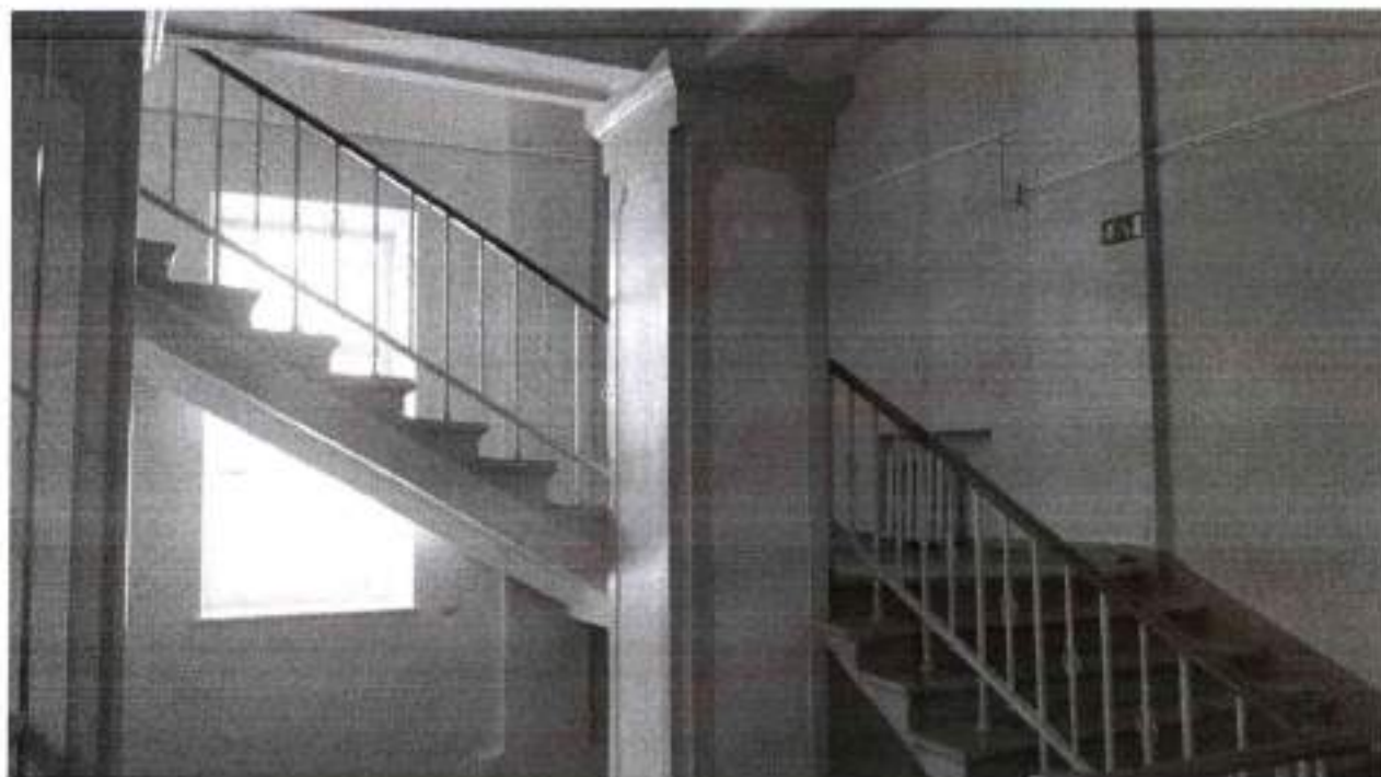
Фото 16. Лестница в центральной части здания
