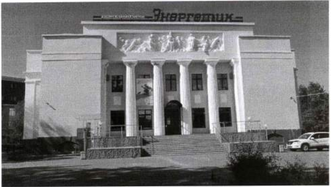
Фото 1. Главный восточный фасад
