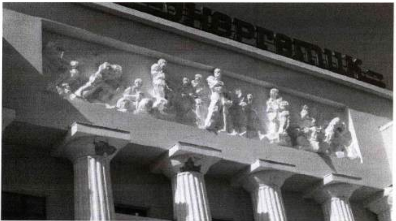
Фото 4. Главный восточный фасад. Горельефное скульптурное изображение группы строителей Нижне-Тулумской ГЭС
