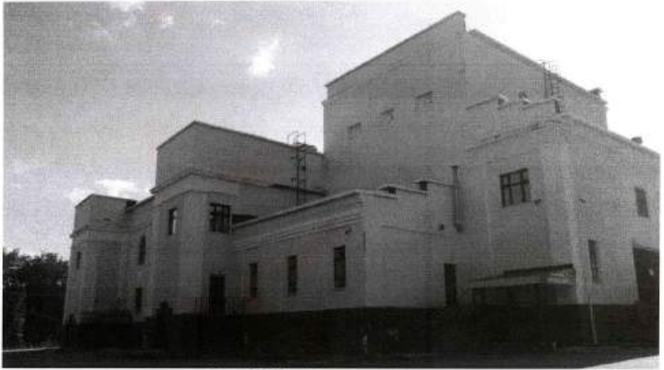
Фото 3. Общий вид с северо-запада
