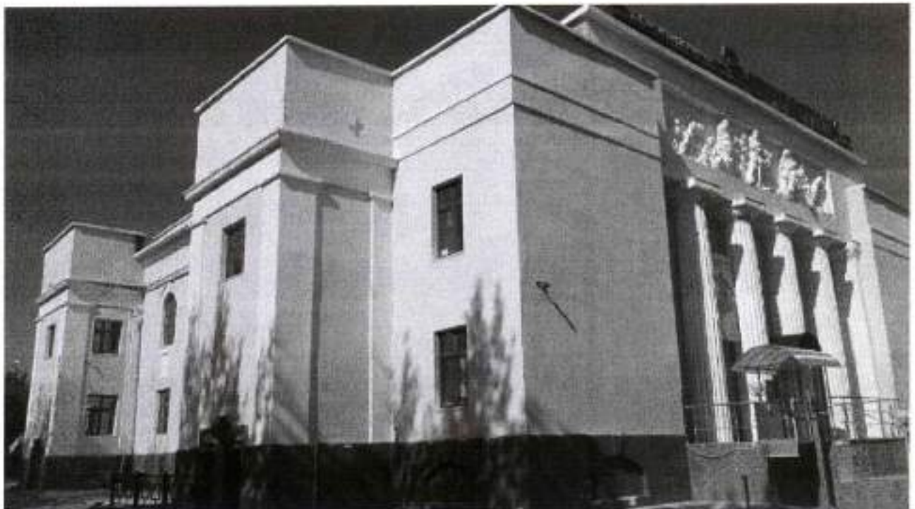
Фото 2. Общий вид с юго-востока
