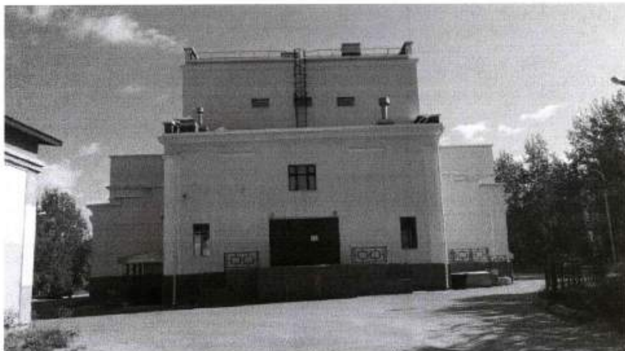
Фото 6. Дворовый западный фасад
