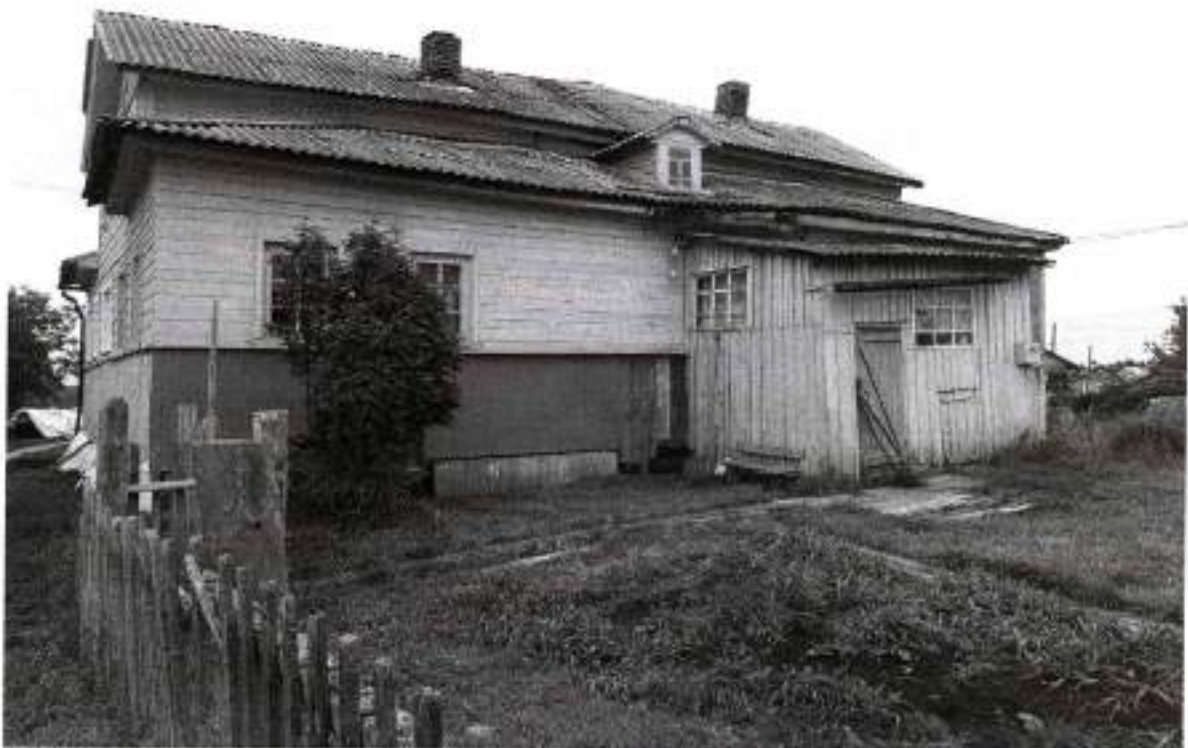
Фото 2. Боковой южный фасад
