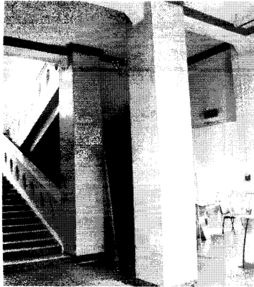
Фото 14. Вестибюль. Первый этаж
