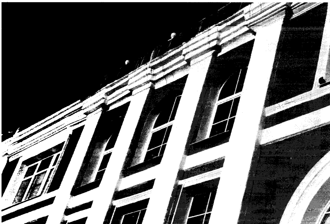
Фото 10. Фрагмент юго-восточного фасада
