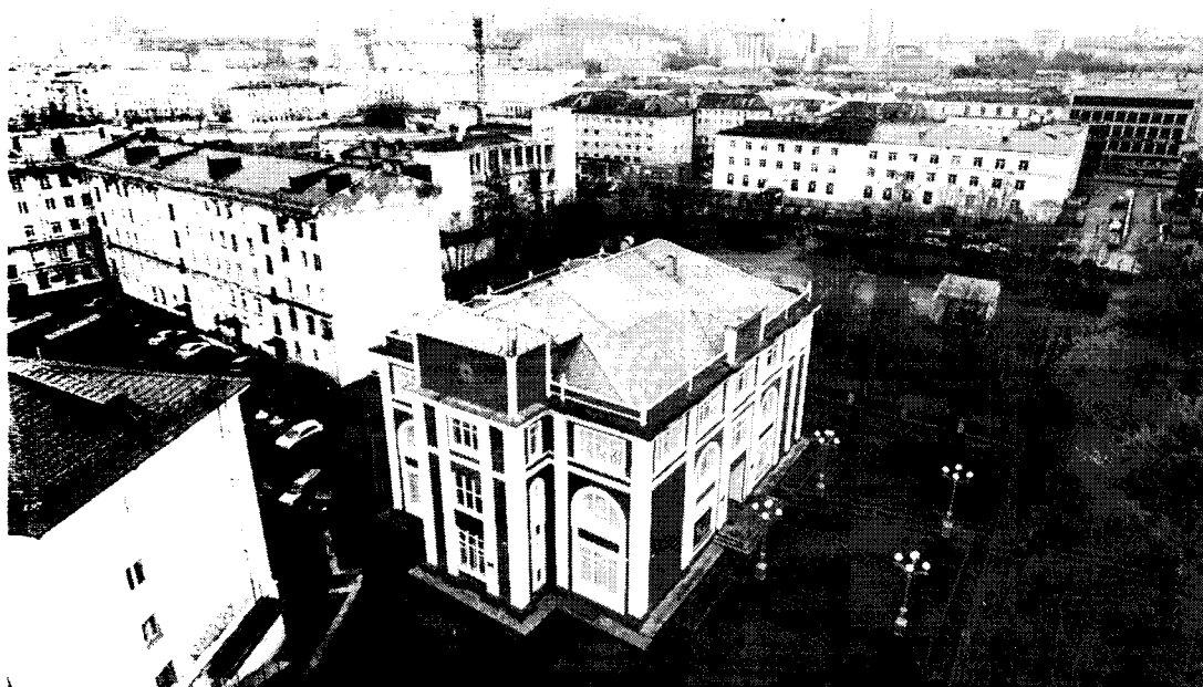
Фото 5. Вид на крышу Здания Мурманского областного художественного музея
