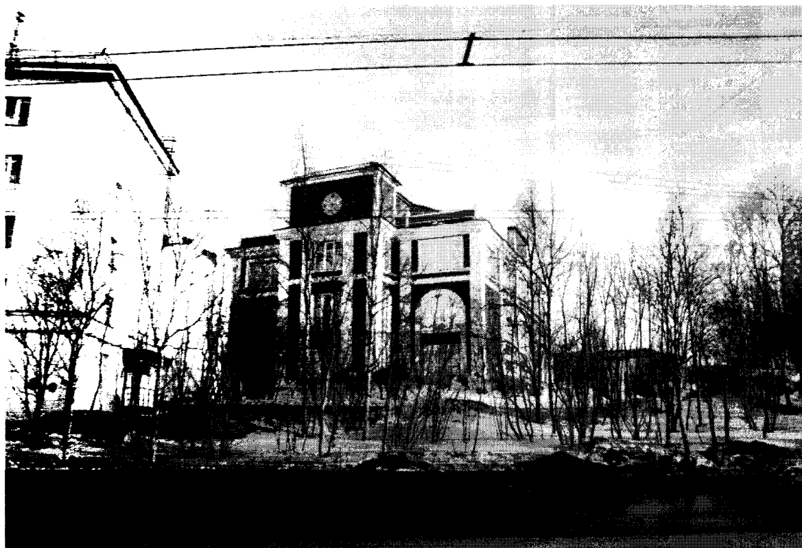
Фото 2. Вид на Здание Мурманского областного художественного музея со стороны улицы Коминтерна
