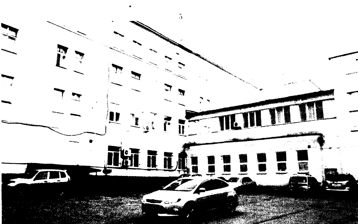
Фото 7. Западный фасад. Южная часть фасада
