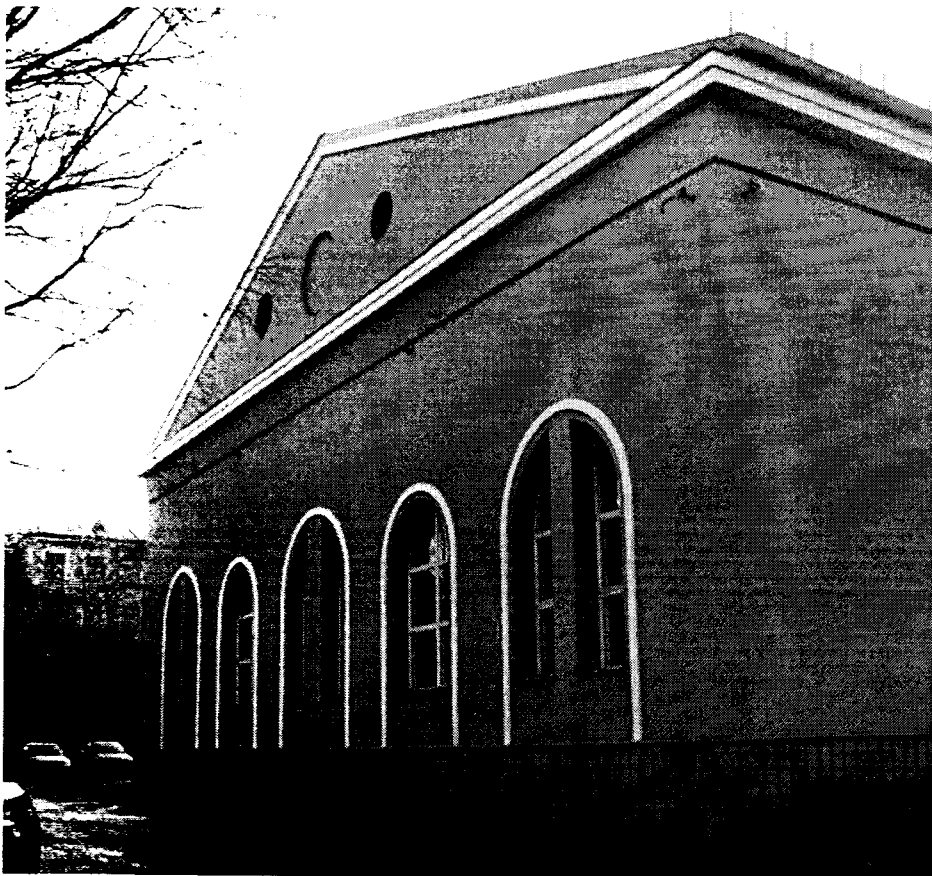
Фото 4. Северо-восточный фасад. Общий вид
