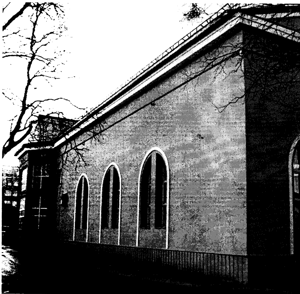
Фото 5. Юго-восточный фасад, северо-восточная часть
