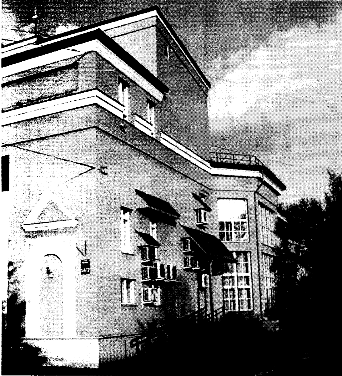
Фото 6. Юго-восточный фасад, юго-западная часть
