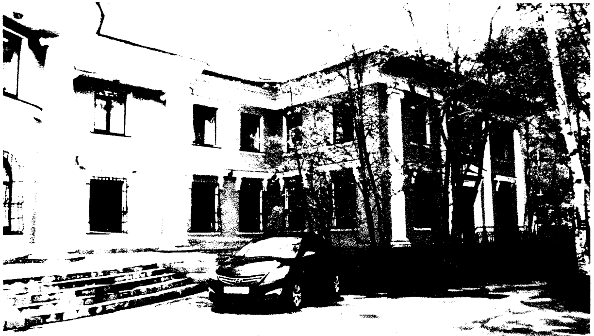
Фото 2. Главный юго-западный фасад, юго-восточный ризалит
