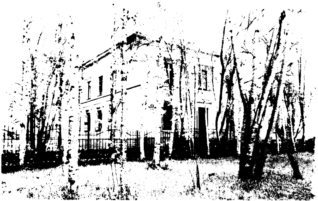
Фото 4. Северо-западный (боковой) фасад. Общий вид
