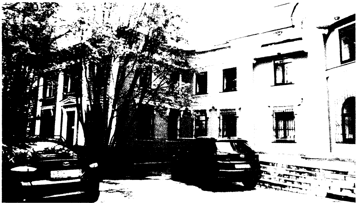
Фото 3. Главный юго-западный фасад, северо-западный ризалит
