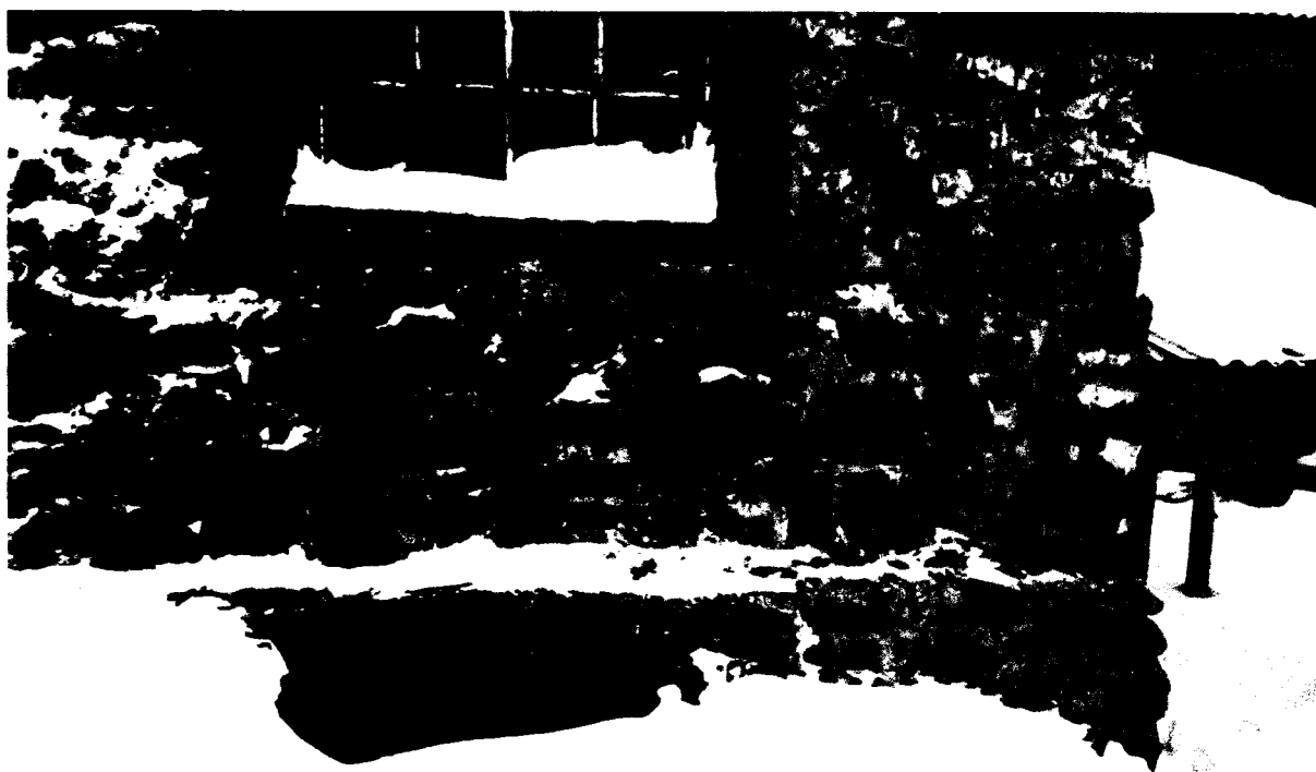
Фото 17. Фрагмент северного фасада. Деревянный фронтон с полувальмой и карнизами; кирпичный наличник проёма с лучковой перемычкой
