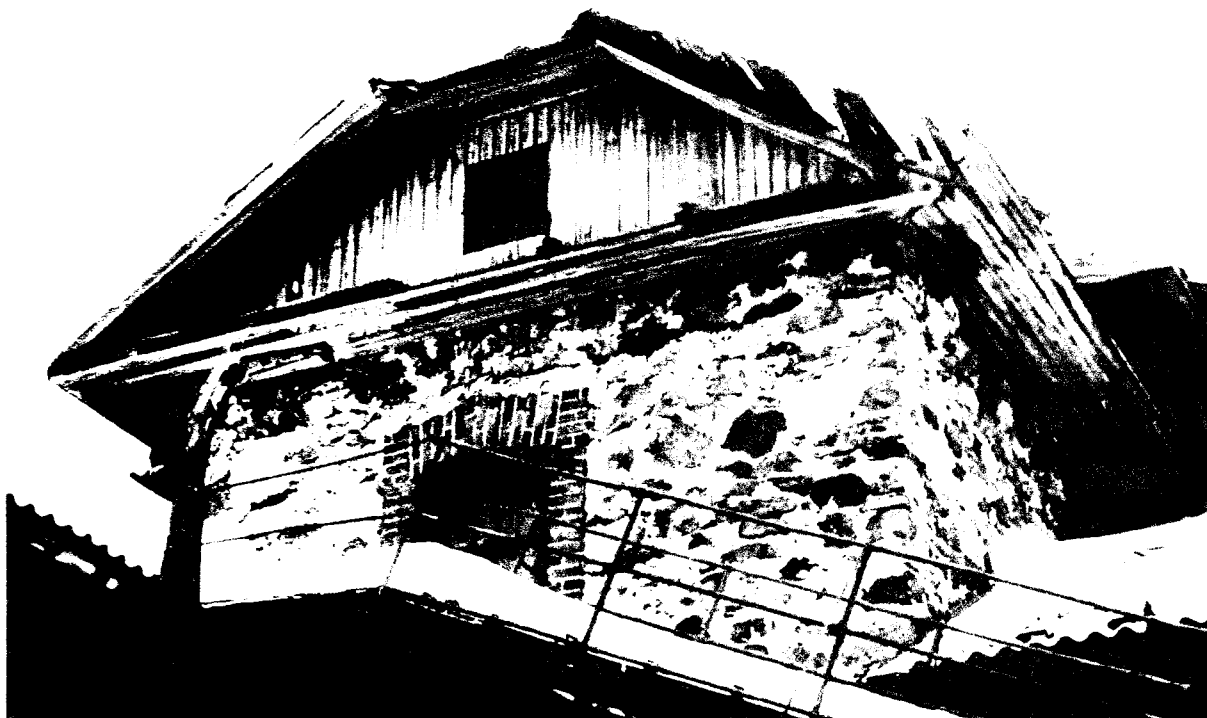
Фото 17. Фрагмент северного фасада. Деревянный фронтон с полувальмой и карнизами; кирпичный наличник проёма с лучковой перемычкой
