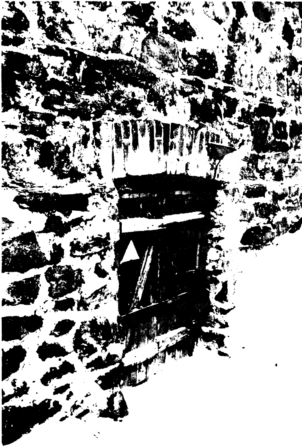
Фото 20. Западный фасад. Входной проём цокольного этажа с кирпичной дуговой перемычкой
