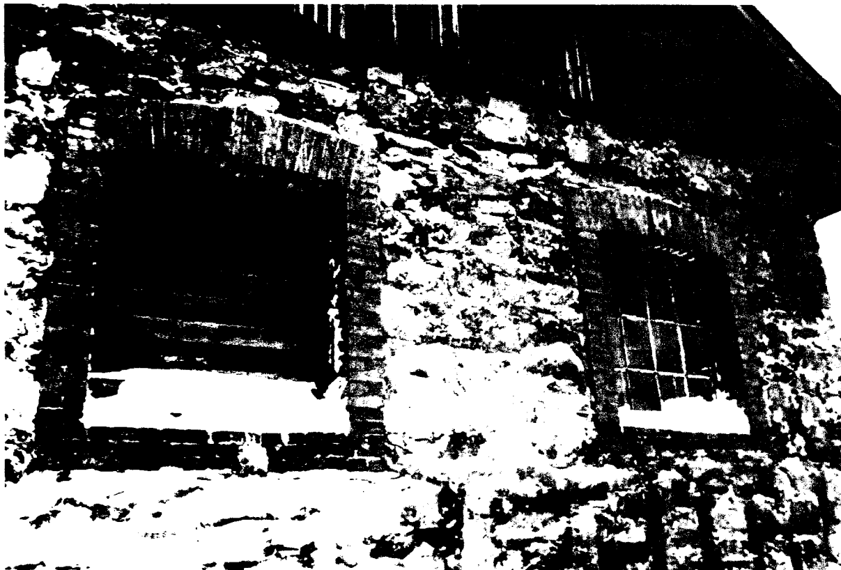
Фото 15. Фрагмент восточного фасада. Кирпичные наличники оконных проёмов с лучковыми перемычками
