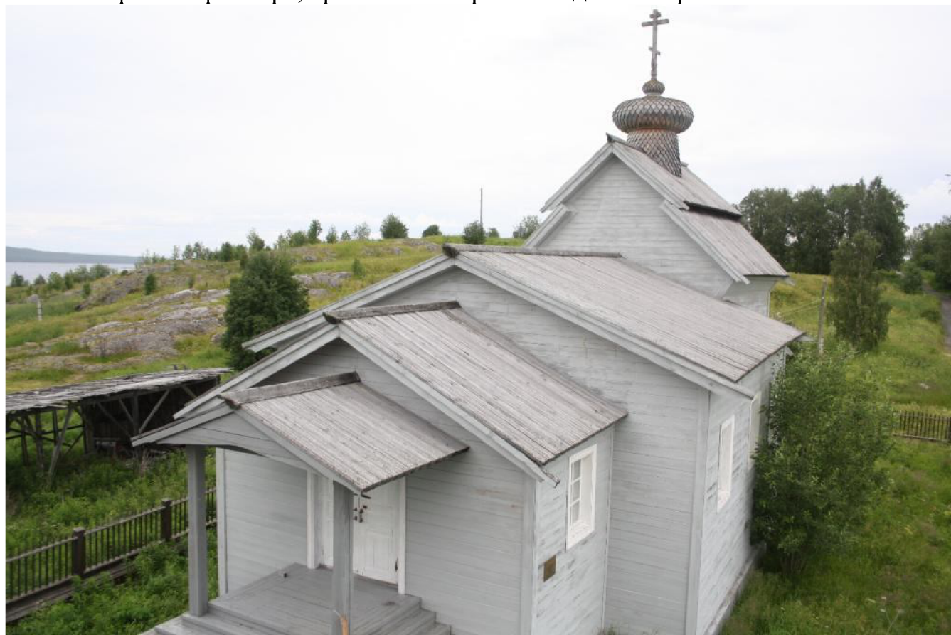
Фото 7. Крыша притвора, трапезной и храма. Вид на северо-восток.
