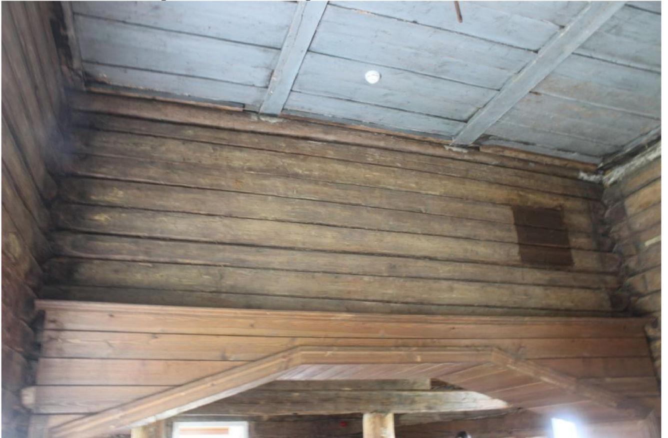
Фото 18. Потолок храма. Вид на северо-запад.
