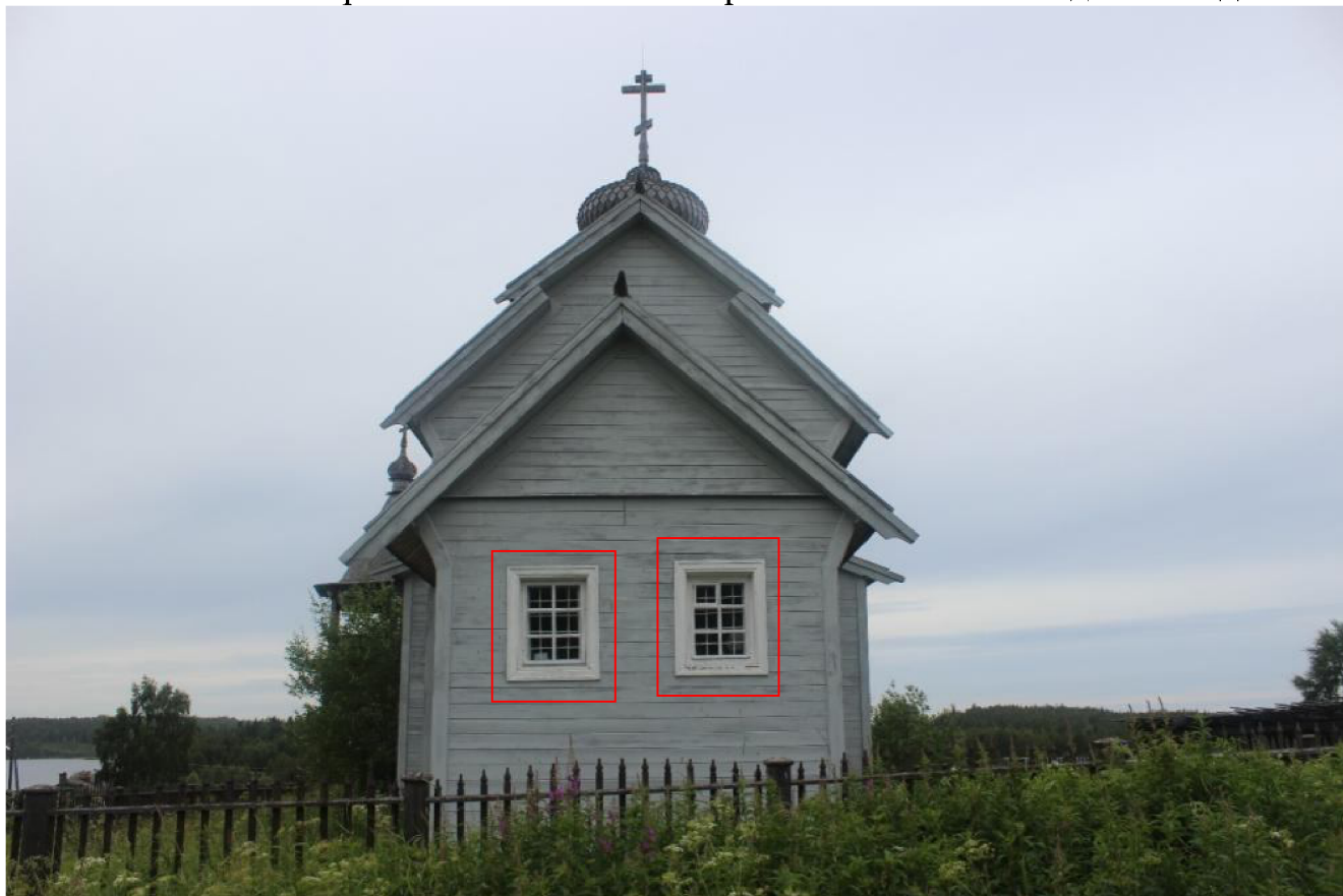
Фото 16. Оконные проемы с восточной стороны Памятника. Вид на запад.
