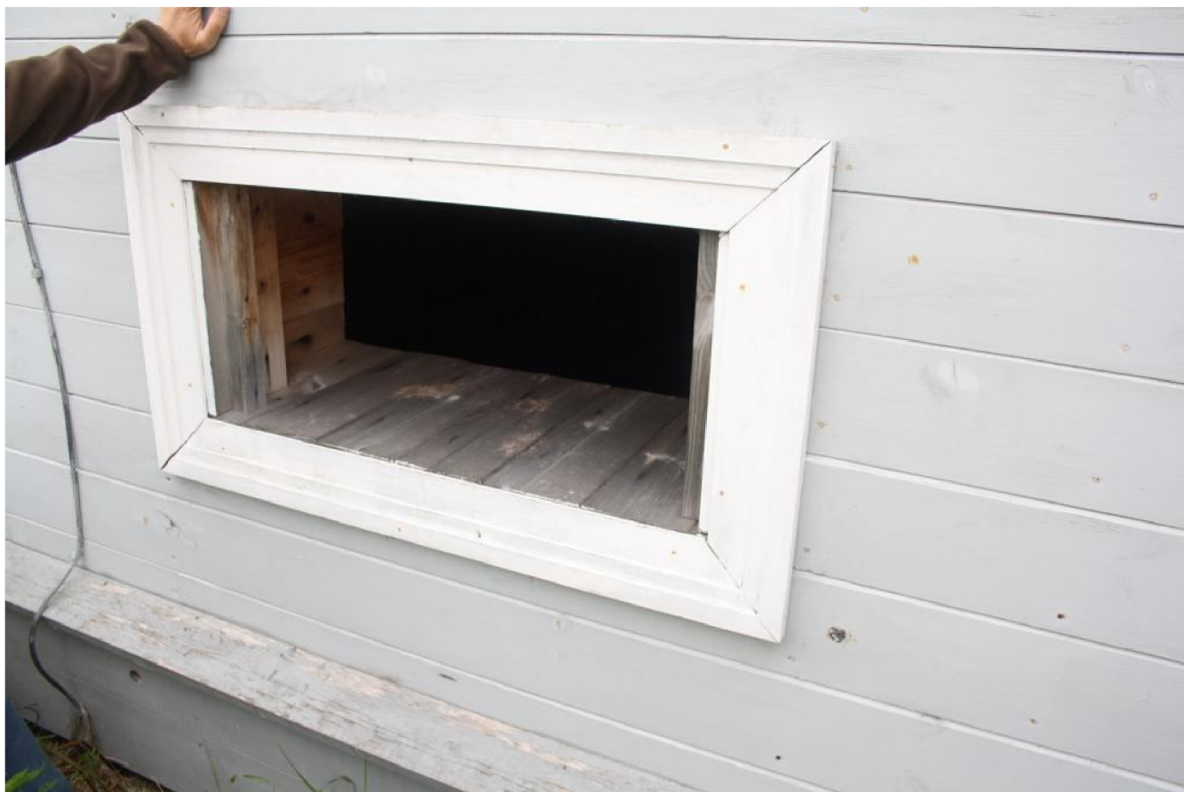
Фото 12. Волоковое окно, расположенное на северной стороне Памятника. Вид на юго-восток.
