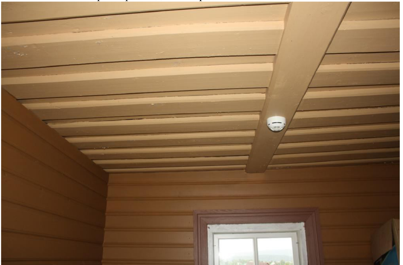
Фото 20. Потолок притвора. Вид на север.
