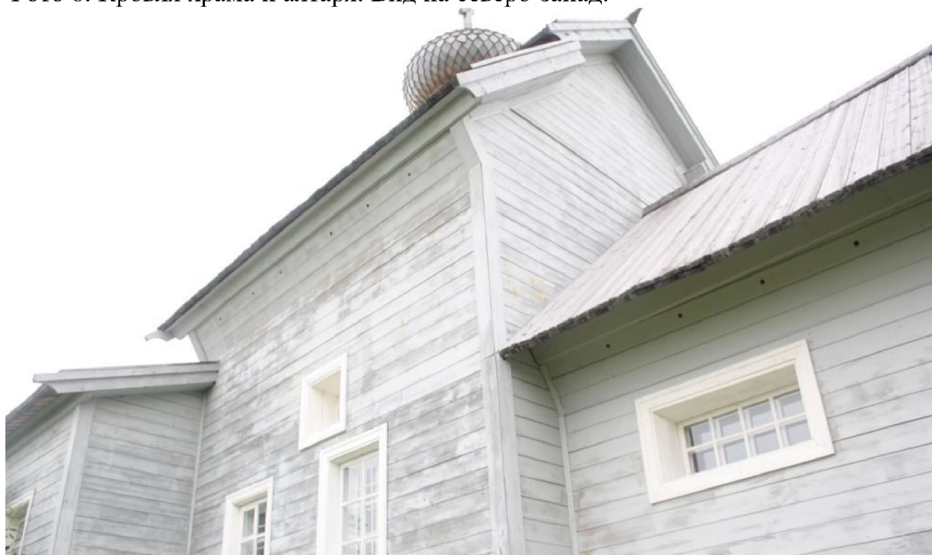
Фото 8. Кровля храма и алтаря. Вид на северо-запад.
