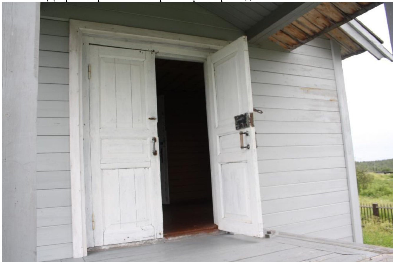
Фото 10. Дверной проем из паперти в притвор. Вид на юго-восток.
