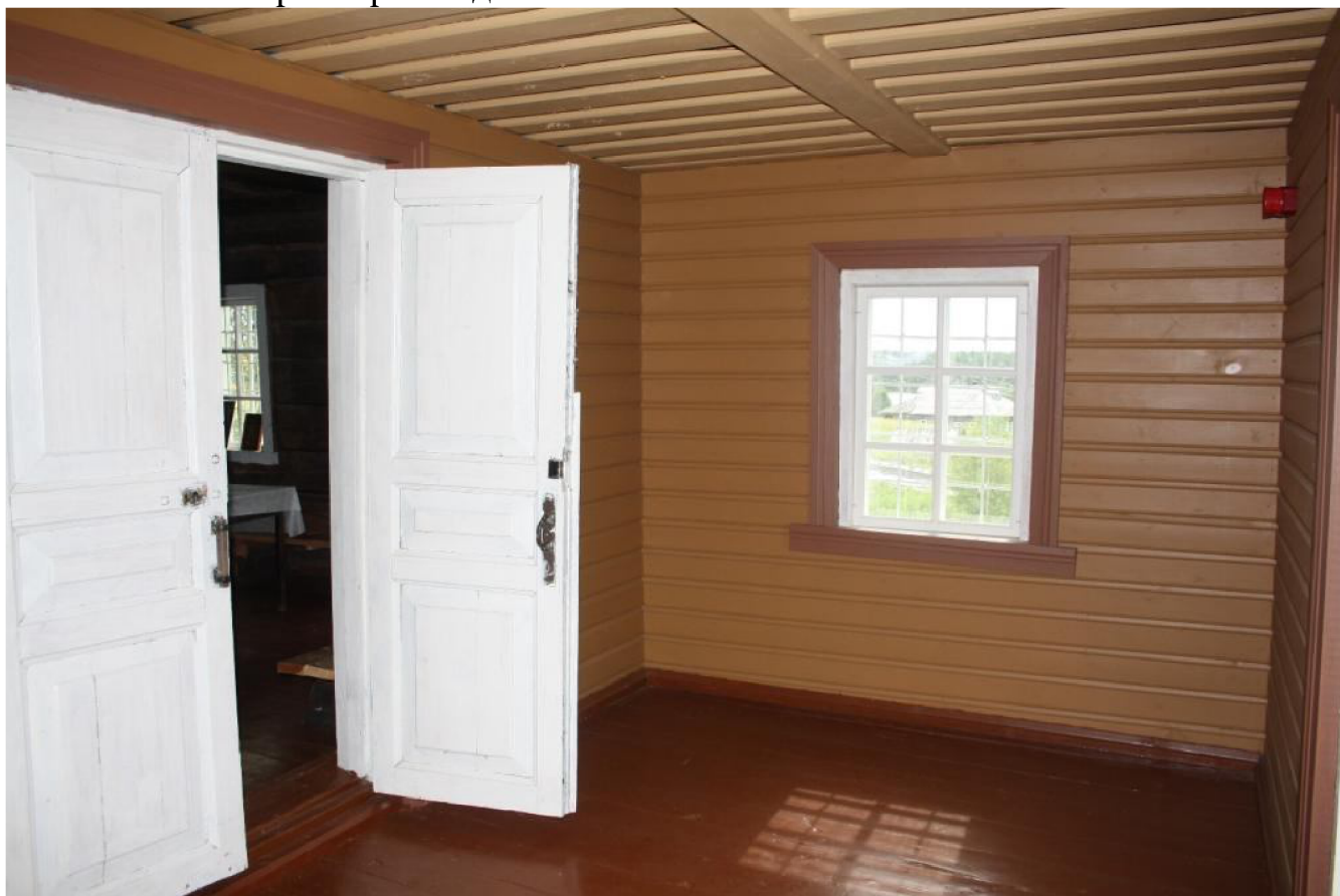
Фото 6. Стены притвора. Вид на юго-восток.
