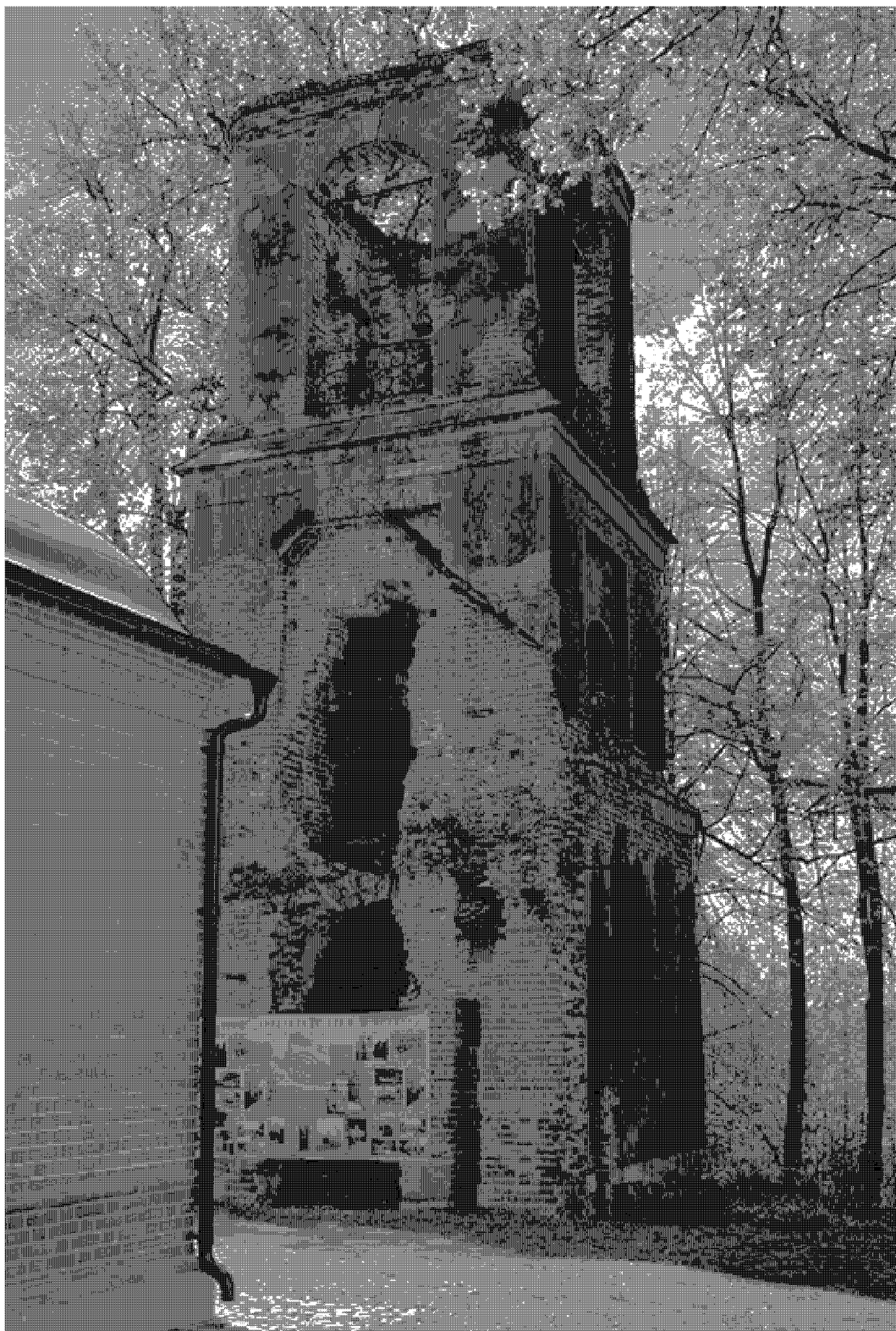
2. Колокольня церкви Рождества Христова. Восточный фасад.
