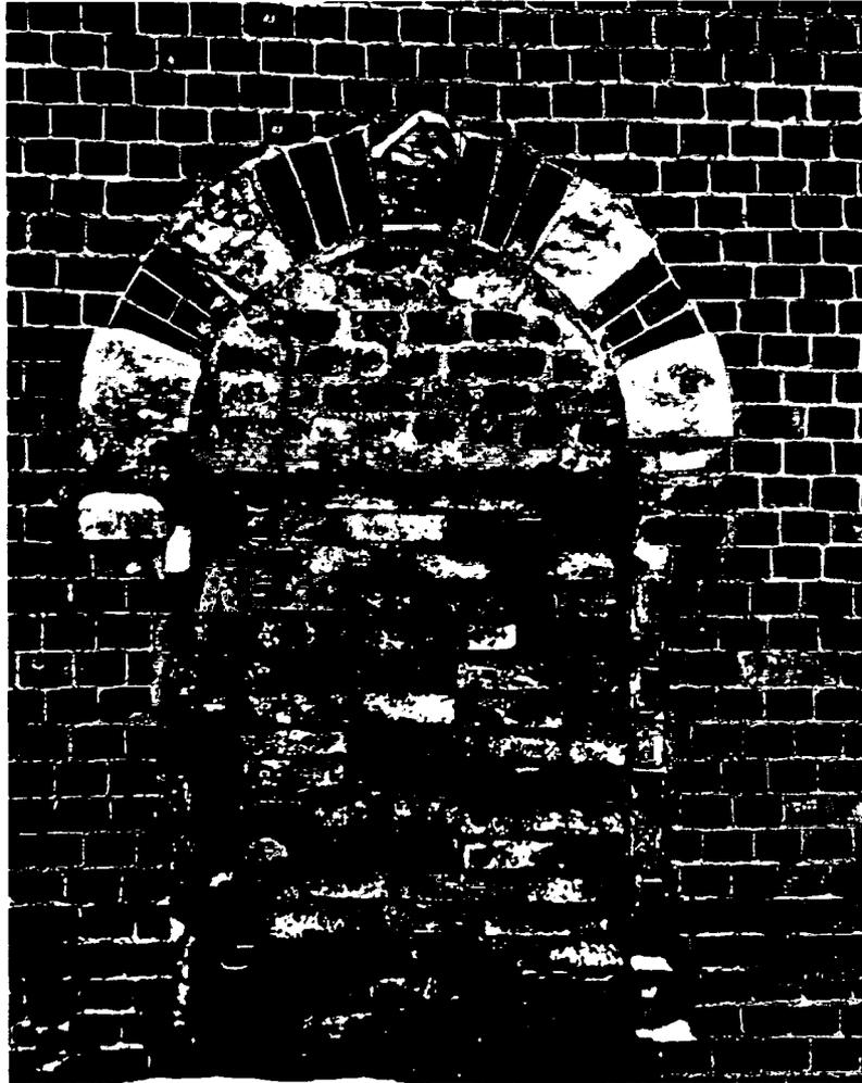
7. Заложенный дверной проем с арочным завершением на южном фасаде.
