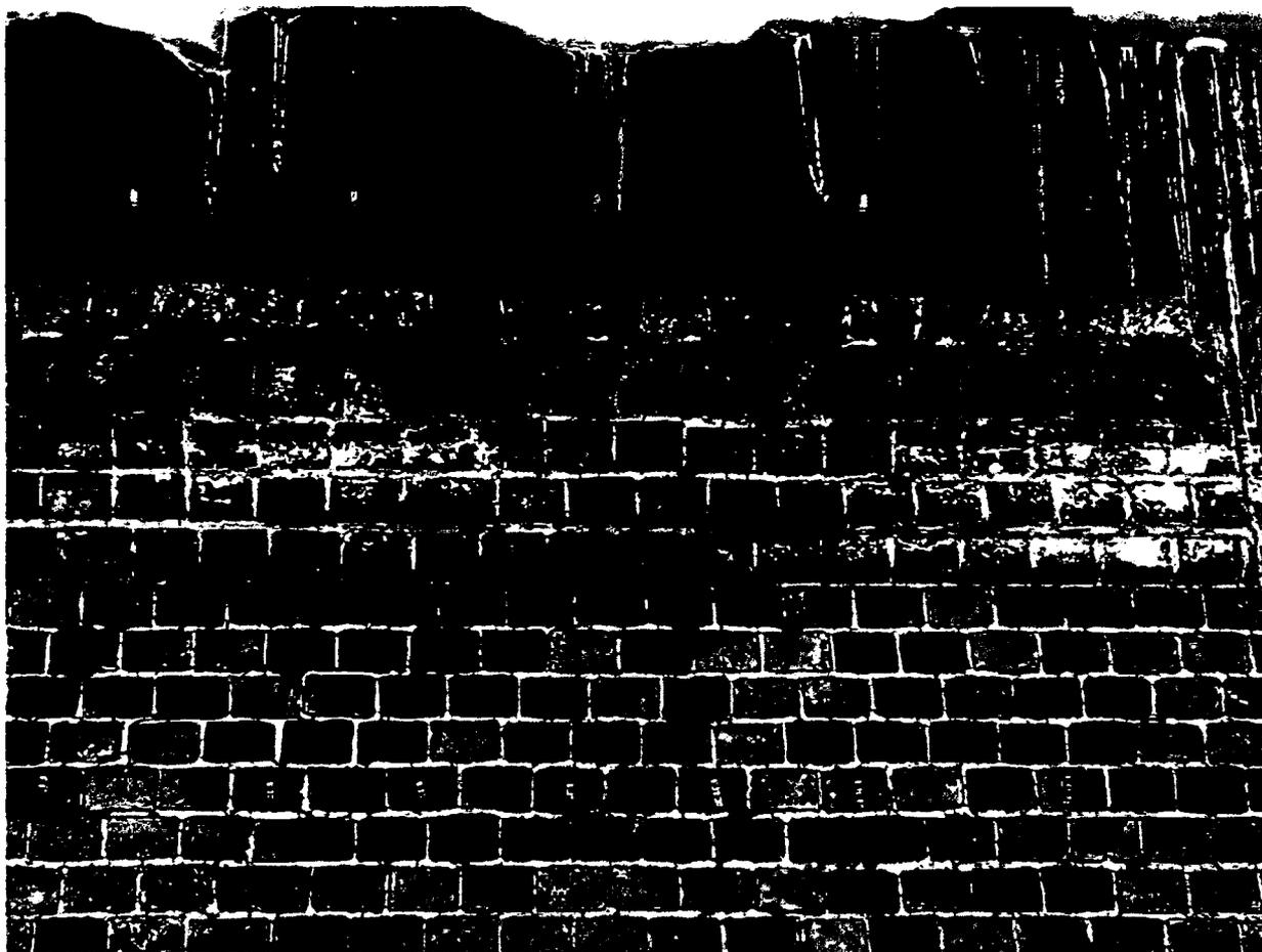
9. Фрагмент венчающего карниза с фризом и сухариками кирпича на южном фасаде.
