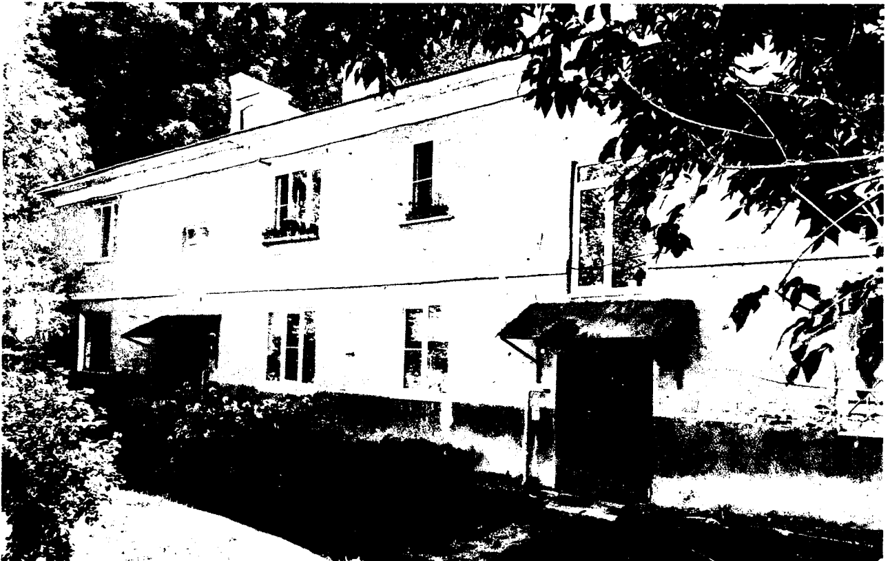
2. Главный северный фасад
