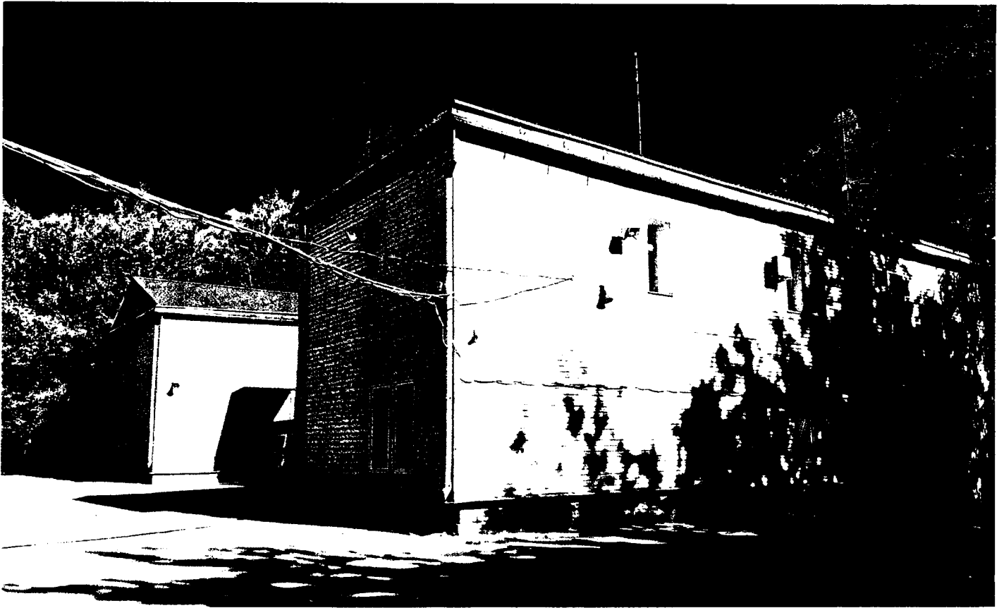
3. Общий вид с северо-запада
