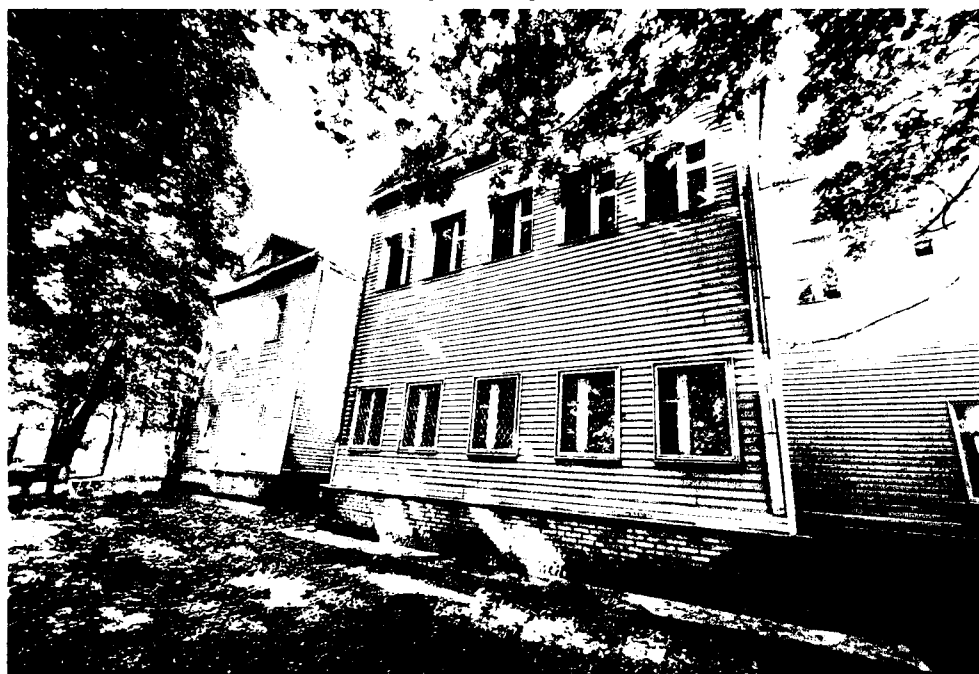
2. Южный фасад. Вид с востока
