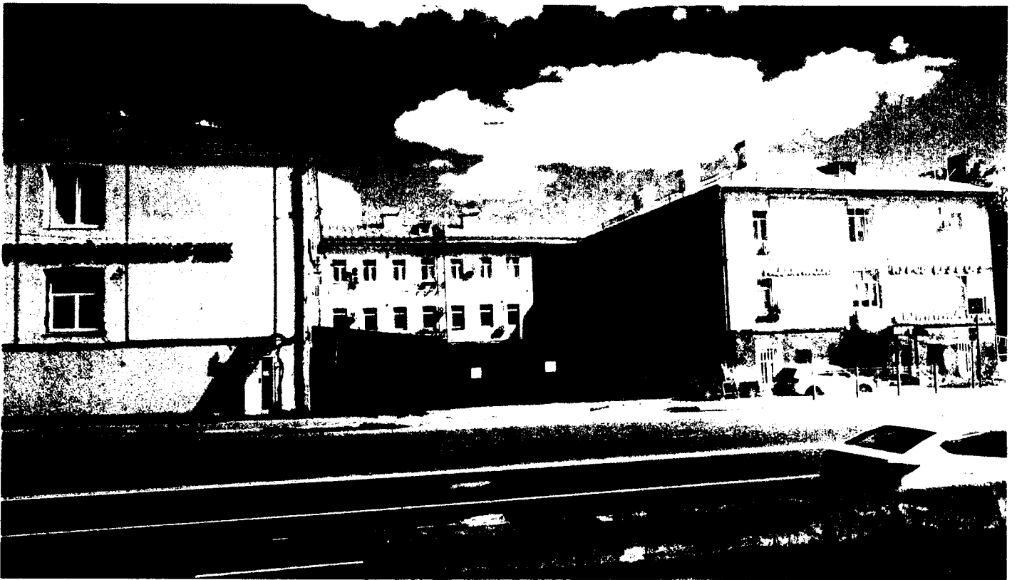
3. Общий вид с юго-запада
