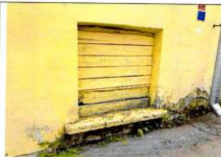
Подоконник оконного проема нижнего яруса лицевого С-3 фасада
