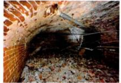
Нижний ярус. Кирпичные свод и стены
