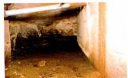
Нижний ярус. Кирпичный полусвод, стены из гранитных валунов и монолитные ж/б
