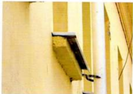
Подоконник оконного проема верхнего яруса лицевого С-3 фасада
