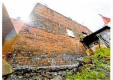
С-В стена здания
