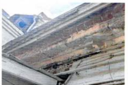
Венчающий карниз дворового Ю-В фасада
