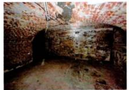
Нижний ярус. Кирпичные свод и стены
