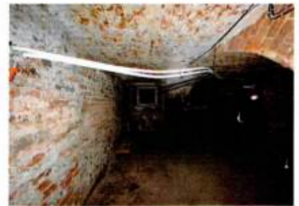
Нижний ярус. Кирпичные свод и стены
