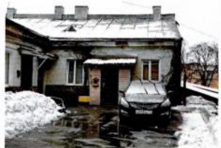
Дворовый Ю-З фасад
