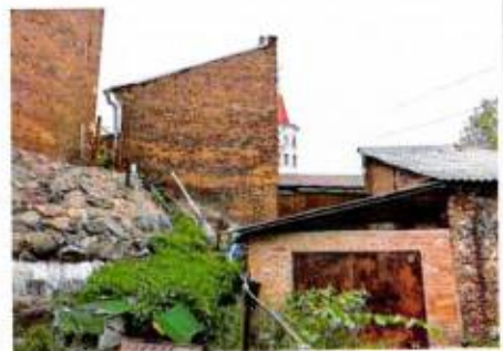
Ю-В торцевая стена дворового крыла
