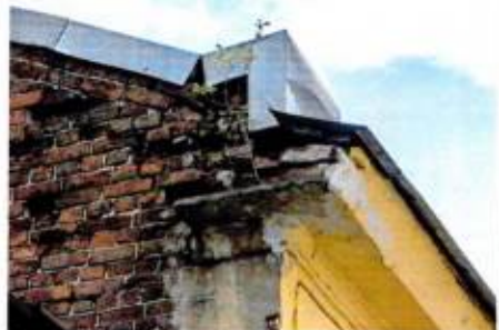
Венчающий карниз лицевого С-3 фасада
