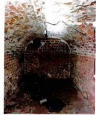
Нижний ярус. Кирпичные свод и стены
