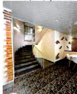
Ж/б лестница гостиницы. Ю-В часть здания
