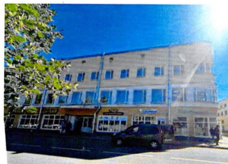
Лицевой северный фасад
