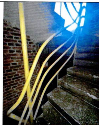
Лестница с Ю-В части северного крыла. Ограждение
