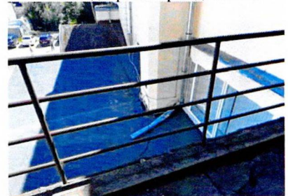
Южный дворовый фасад. Ограждение балкона
