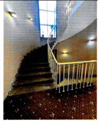
Ж/б лестница гостиницы. Ю-В часть здания
