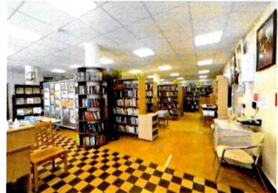
1-ый этаж. Помещение в западной части южного крыла. Монолитное ж/б перекрытие, опорные столбы, кирпичные стены
