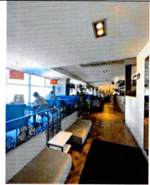
1-ый этаж. Помещение в северной части восточного крыла. Плоское монолитное ж/б перекрытие и опорные столбы, кирпичные стены
