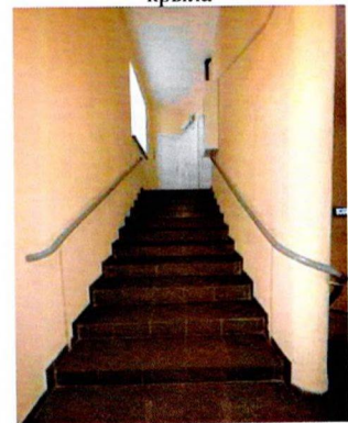
Ж/б лестница. Ю-З угол южного крыла
