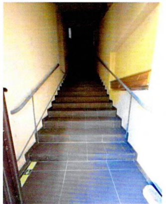
Ж/б лестница. Ю-В угол южного крыла
