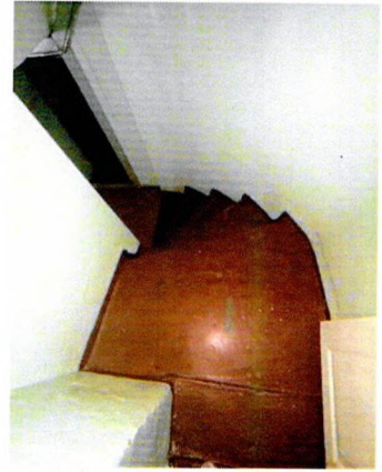
Лестница между 2-ым и 3-им ярусами. Восточная часть южного крыла
