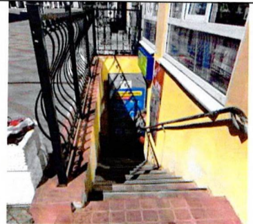
Спуск в подвал (2 шт.). Западный фасад
