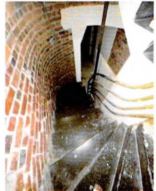
Ж/б лестница. Южная часть восточного крыла
