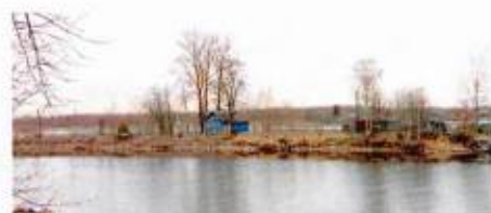
22. Вид на дамбу и фрагменты береговых укреплений у г. Шлиссельбурга (каменная наброска - бульжник, валуны)
