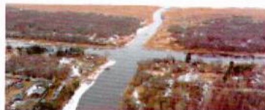
11. Пересечение канала с рекой Кобона
