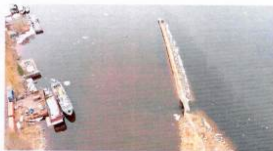
15. Оконечность дамбы в виде каменного мола в г. Шлиссельбург
