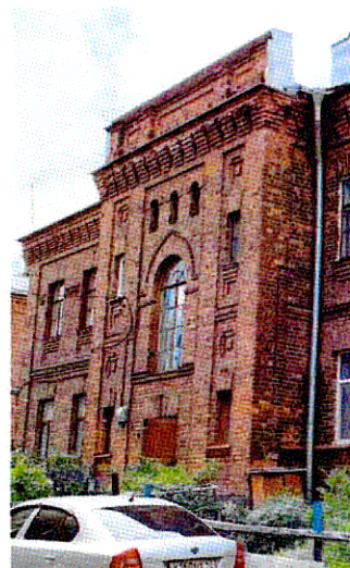
Фасады Ю-В ризалита
