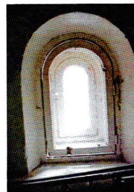
Рисунок оконного проема (Ю-В фасад, 2-ой этаж)
