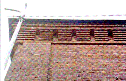
Угловая лопатки и венчающий карниз с фризом
