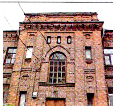
Оконные проемы Ю-В ризалита (2-ой этаж)
