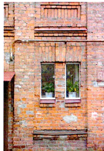
Оконные проемы С-З ризалита (1-ый этаж)
