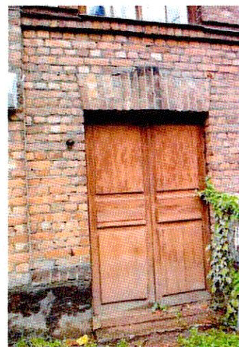
Входной проем (Ю-В фасад)
