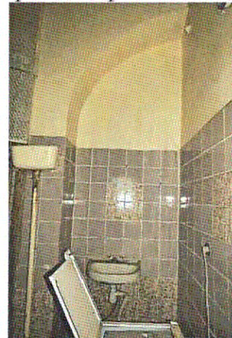
Арочный проем. Пом. 26 и 28
