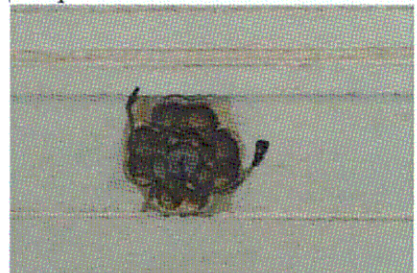
Потолочная галтель. Пом. 151
