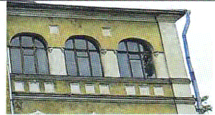
Межэтажный фриз. С-З, Ю-З лицевые, Ю-В фасады
