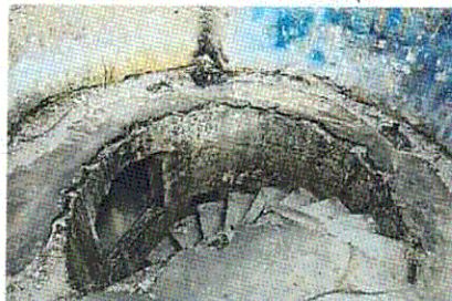
Лестница и бетонное покрытие
