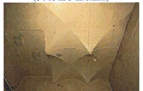
Совмещенные перекрытия (С-В часть ЛК-1, 1-ый - 3-ий этажи)
