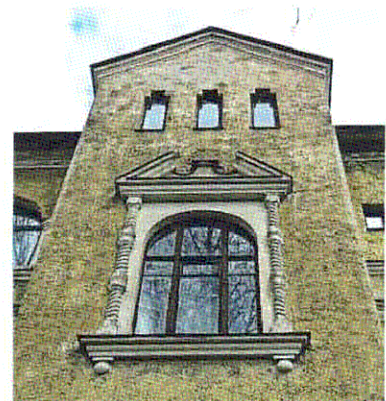
Оконные проемы лестничной клетки (3-ий и 4-ый этажи)
