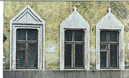
Оконные проемы С-3 лицевого фасада. 1-ый этаж
