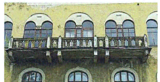
Балкон С-З лицевого фасада
