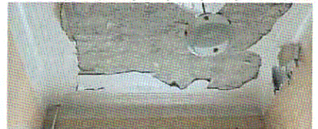
Потолочная галтель. Пом. 116, 117, 132, 134, 135
