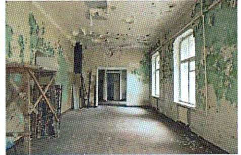
Плоское перекрытие. 1-ый этаж (пом. 35)
