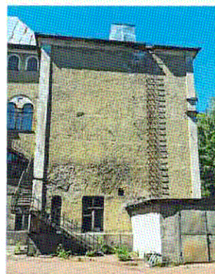
Ю-В торцевой фасад С-В крыла
