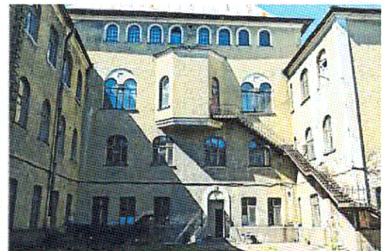
Ю-В дворовой фасад
