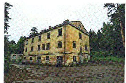
Общий вид здания с юга
