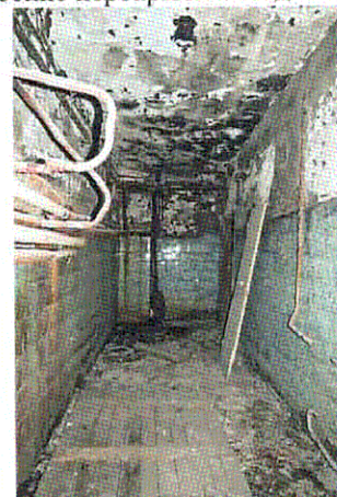
Плоское перекрытие. Подвал
