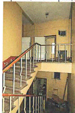
Лестничная клетка. Пом. 15, 18
