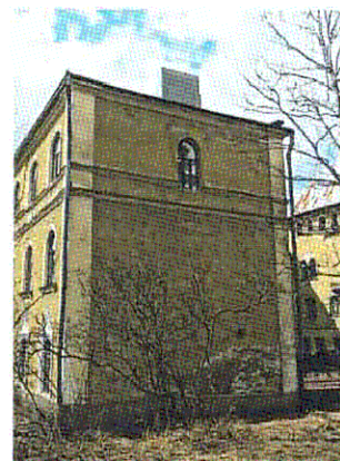
С-В торцевой фасад Ю-В крыла
