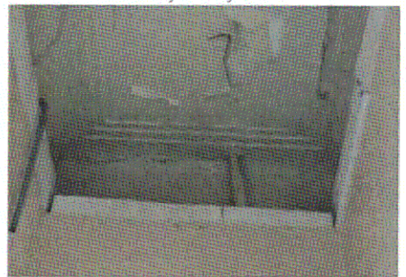
Потолочная галтель. Пом. 160, 161, 167, 168, 181, 183, 211
