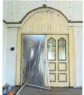
Дверь. Между ЛК-1 и пом. 151
