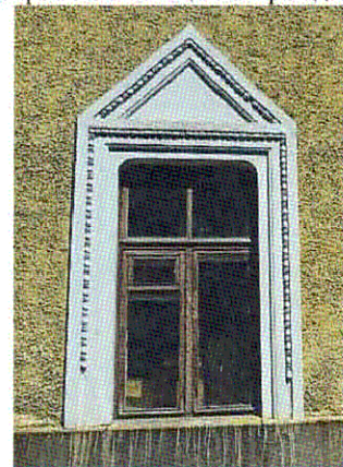
Оконный проем. 1-ый этаж
