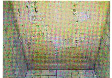
Потолочная галтель. Пом. 45, 46, 56, 57, 58, 59, 67, 77, 79, 102
