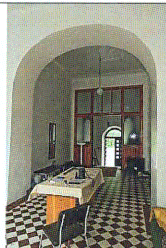
Арочный проем. Пом. 18
