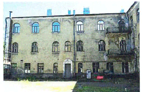
С-З дворовой фасад Ю-В крыла
