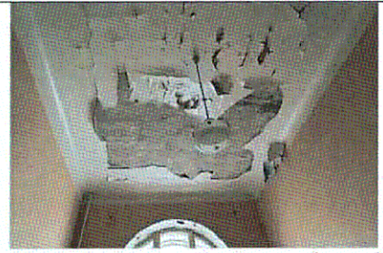
Плоское перекрытие. 2-ой этаж (пом. 116)
