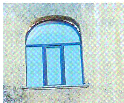
Оконный проем 3-го этажа. Дворовые фасады
