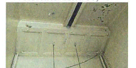
Потолок. Пом. 147. ЛК-1
