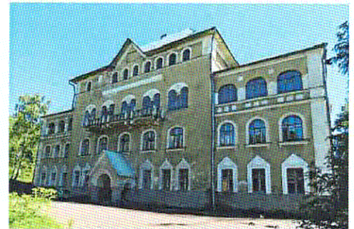
Лицевой С-З фасад
