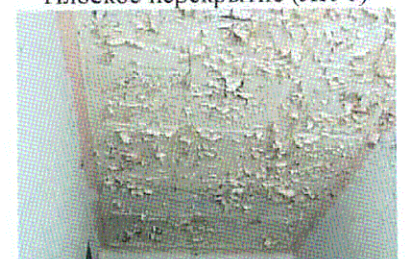
Плоское перекрытие (пом. ЛК-2)
