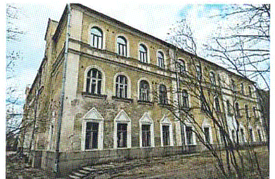
Ю-В фасад Ю-В крыла
