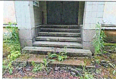
Крыльцо. С-В фасад
