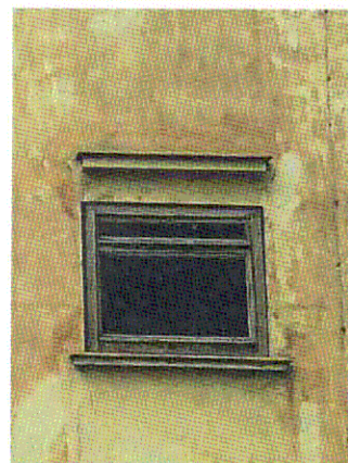
Подоконные и надоконные тяги
