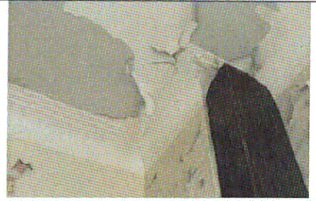
Потолочная галтель. Пом. 32, 33, 34, 35
