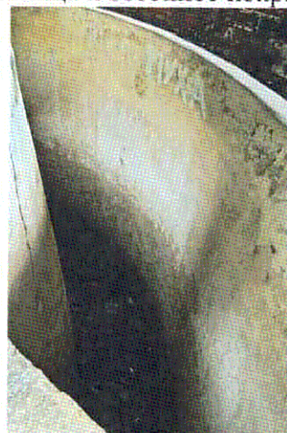
Бетонные стены резервуара
