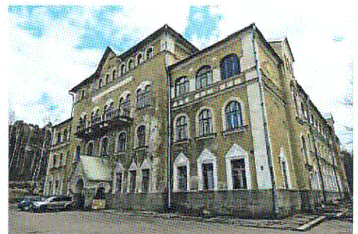
Лицевой С-З фасад
