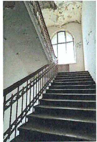
Лестница ЛК-2. 2-ой этаж
