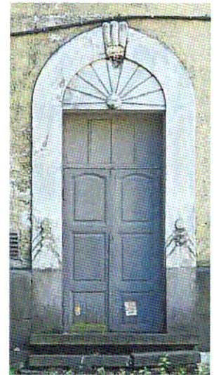
С-В дворовой фасад, входной проем
