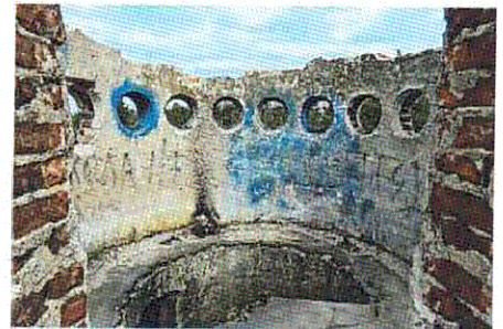
Стены винтовой лестницы на уровне смотровой площадки
