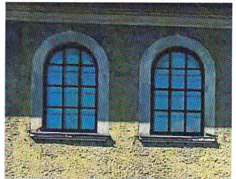
Оконные проемы 4-го этажа. Ю-В дворовой фасад
