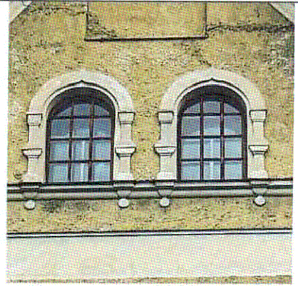
Оконные проемы 4-го этажа. С-3 лицевой фасад
