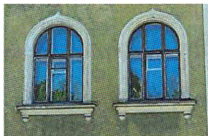
Оконные проемы, 2-ой этаж лицевых фасадов
