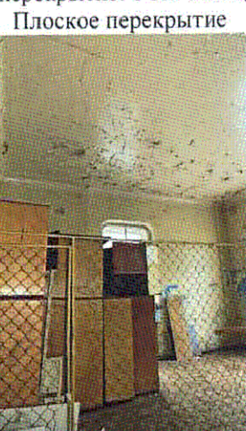
Плоское перекрытие. 1-ый этаж (пом. 28)
