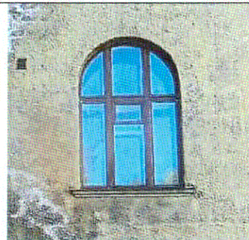
Оконный проем 2-го этажа, дворовые фасады
