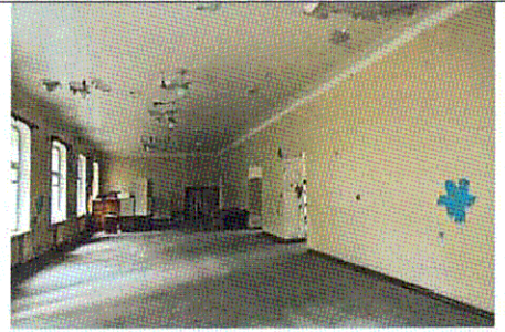
Плоское перекрытие 1-ый этаж (пом. 33)
