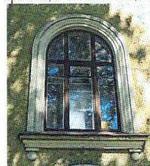
Оконный проем. Ризалит Ю-3 лицевого фасада. 2-ой этаж
