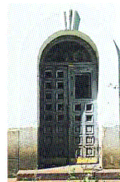
Входной проем, Ю-В фасад Ю-В крыла
