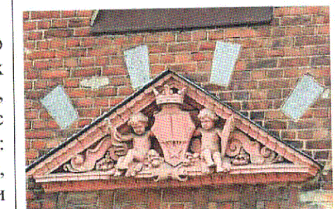
Сандрик оконного проема, 1-ый этаж, С-3 фасад
