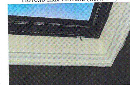
Потолочная галтель (пом. 2.15)
