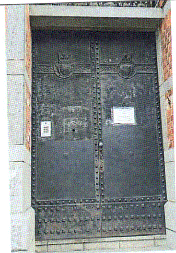
Дверь парадного входа
