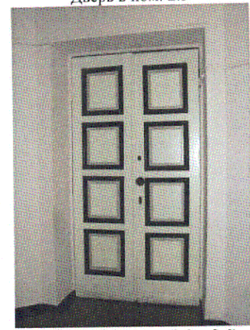
Дверь (между пом. 2.2 и 2.6)
