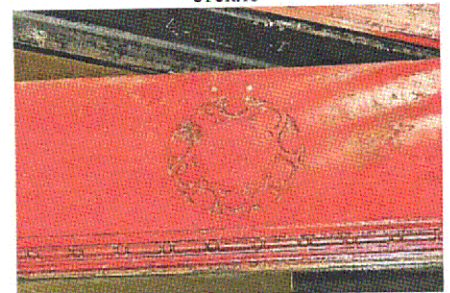
Входные двери. Фрагмент (пом. 1.1).
