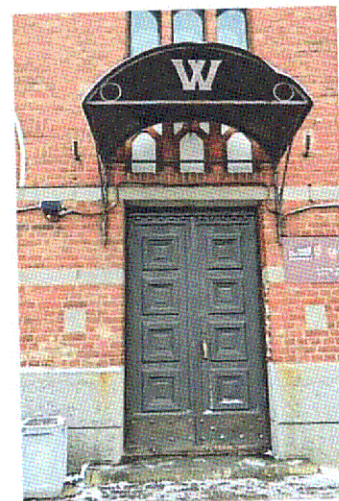
Оформление входа (С-З фасад)
