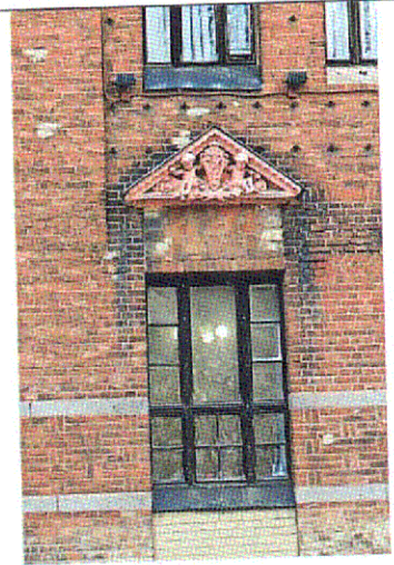
1 этаж Оконный проем, Ю-3 фасад
