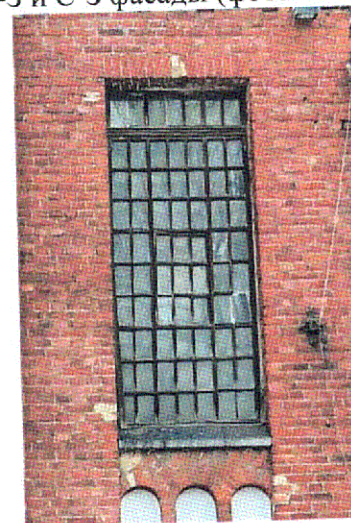
Оконные проемы лестничных клеток, Ю-3 и С-3 фасады
