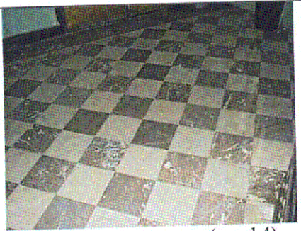
Пол из мраморных плит (пом. 1.4)
