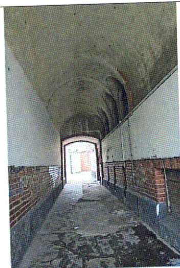
Полуциркульный свод арочного проезда
