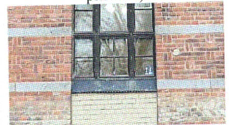
Гранитные пояски (проемы 1-го этажа, уличные фасады)
