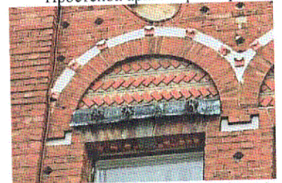
Надоконные карнизы (Ю-3 фасад)
