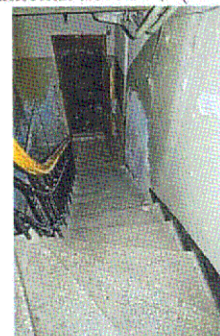
Бетонная лестница Л-5
