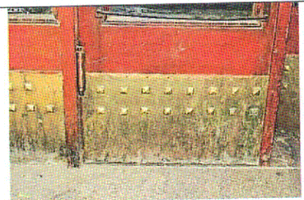
Входные двери. Металлическая обвязка (пом. 1.1). Фрагмент
