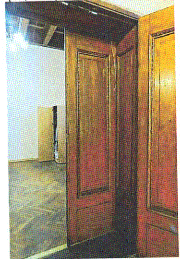
Двери (между пом. 1.7 и 1.13). Деревянная обшивка простенка
