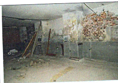
Опорные столбы (подвал, пом. 0.18)
