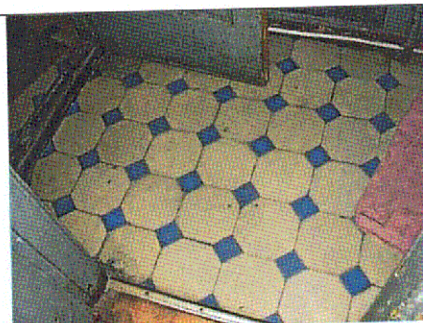
Пол из керамической плитки (пом. 1.22, 1.23, 1.28, 1.29). Фото 2009 г.
