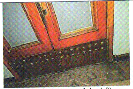
Дверь (между пом. 1.4 и 1.9). Металлическая обвязка
