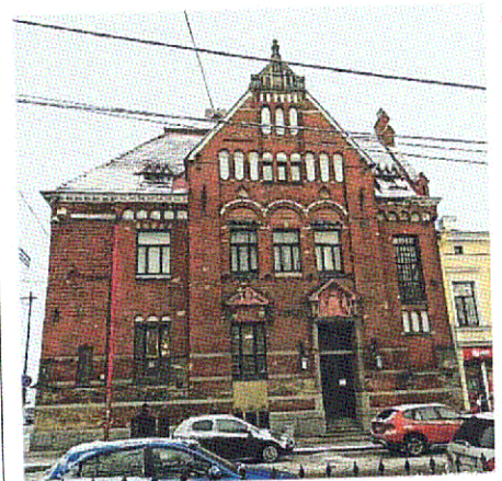
Лицевой Ю-3 фасад
