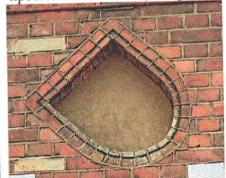
Кирпичное оформление ниши в форме герба над проемами 2-го этажа (уличные фасады)
