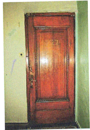
Дверь (между пом. 1.4 и 1.6)
