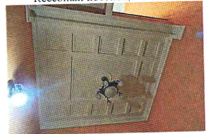
Кессонный потолок (верхняя площадка ЛК-1)
