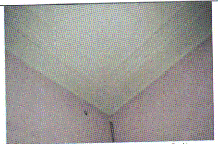
Потолочная галтель (пом. 2.4)
