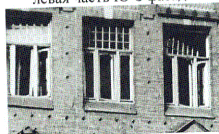
Оконные проемы 2-го этажа, Ю-3 и С-3 фасады (фото 1941 г.)
