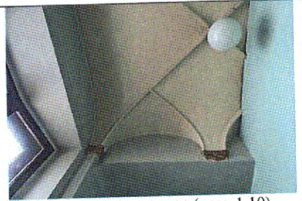
Оформление потолка (пом. 1.10)
