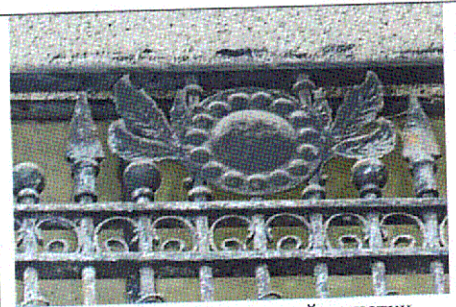
Фрагмент металлической решетки (парадный вход)
