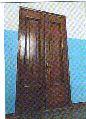
Дверь (между пом. 1.9 и ЛК-2)
