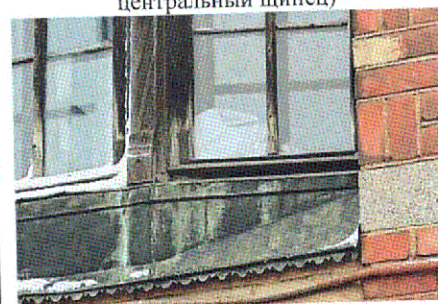
Элемент декора столярного заполнения окна (С-3 фасад)
