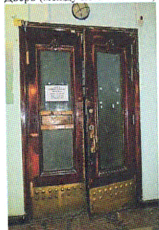
Дверь (между пом. 1.4 и 1.24)
