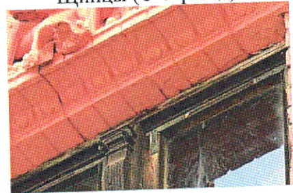
Кладка верхних откосов (проемы 1-го этажа, С-3 фасад)
