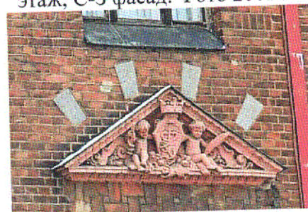
Сандрик оконного проема, 1-ый этаж, С-3 фасад
