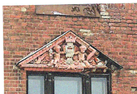
Сандрик оконного проема, 1-ый этаж, С-3 фасад
