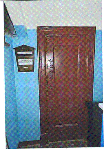
Дверь в пом. 2.25 (ЛК-2)
