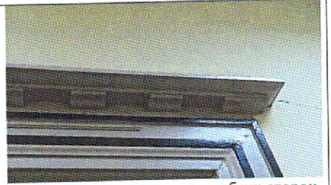
Карнизы дверного проема с обеих сторон (между п.2.5 и 2.6)
