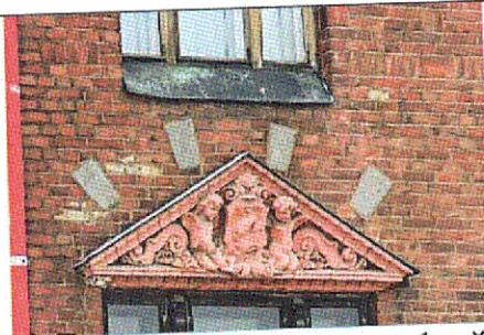
Сандрик оконного проема, 1-ый этаж, С-3 фасад
