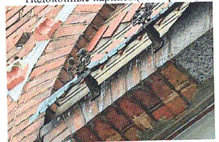
Деталь надоконного карниза (Ю-3 фасад)
