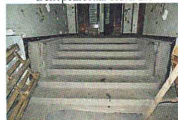
Гранитная лестница (пом. 1.1)
