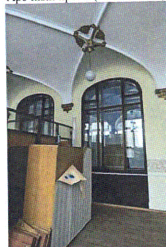
Арочные проемы (пом. 1.9-1.24)
