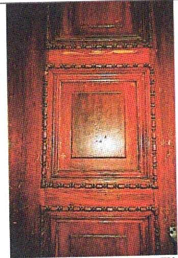
Двери (пом. 1.1). Вход в пом. ЛК-1. Фрагмент полотна.
