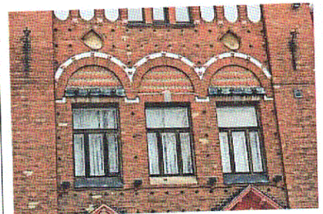
Оконные проемы, 2-ой этаж, Ю-3 фасад
