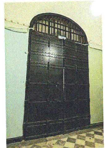
Металлические двери (пом. 1.4). Вид снаружи
