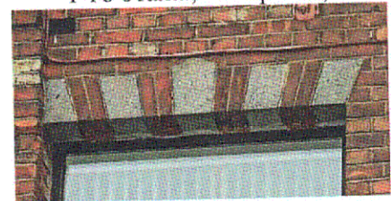
Гранитные вставки перемычки проемов 2-го этажа (С-3 фасад)
