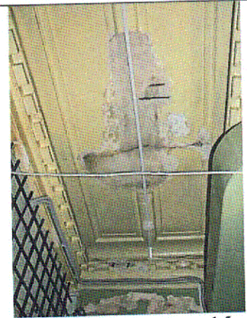
Кессонный потолок, пом. 1.5
