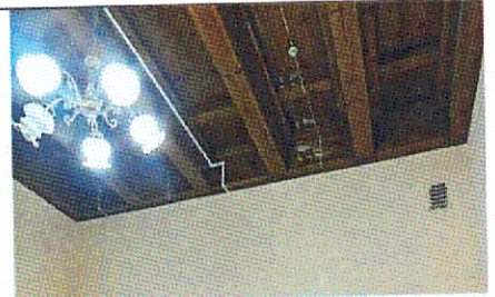
Деревянный потолок (пом. 1.7)
