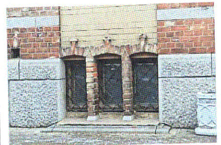
Оконные проемы цокольного этажа (Ю-3 и С-3 фасады)
