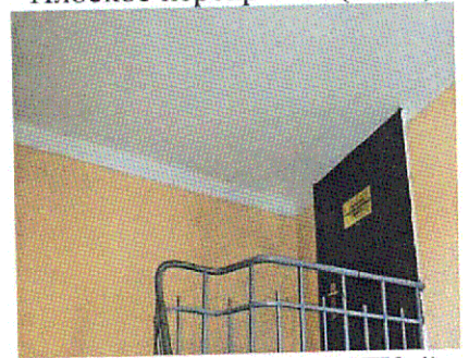
Плоское перекрытие (ЛК-4)
