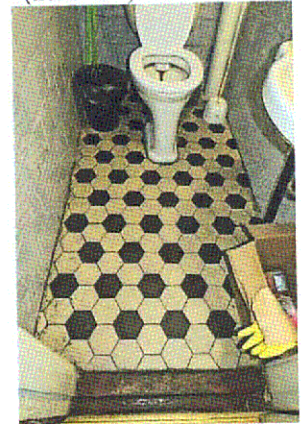
Пол из керамической плитки (пом. 1.8)
