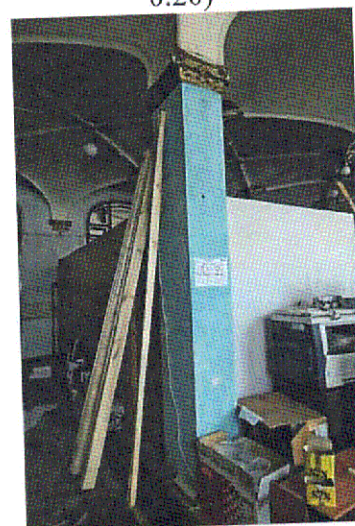
Колонна (1-ый этаж, пом. 1.9)
