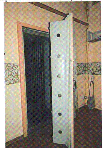
Сейф. Металлическая дверь (пом. 1.12)
