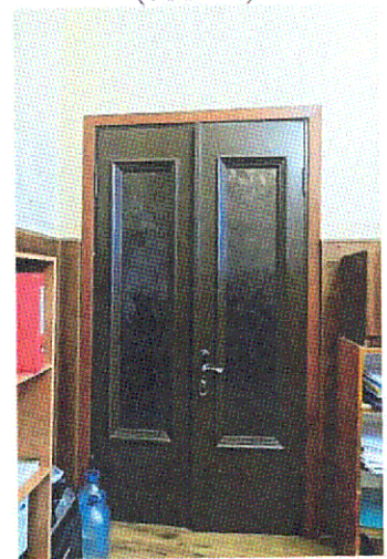
Дверь (между пом. 1.9 и 1.16)
