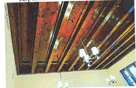
Деревянный потолок (пом. 1.13)
