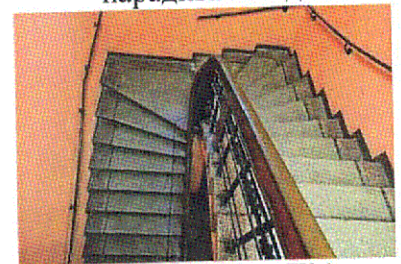
Бетонная лестница ЛК-1
