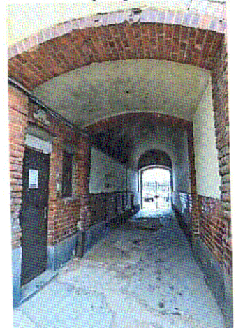
Сегментный свод арочного проезда
