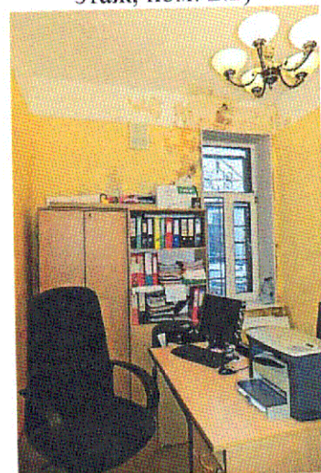
Плоское перекрытие (2-ой этаж, пом. 2.10)
