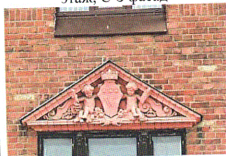
Сандрик оконного проема, 1-ый этаж, С-3 фасад
