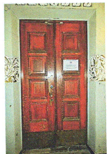
Дверь (пом.1.1). Вход в пом.ЛК-1
