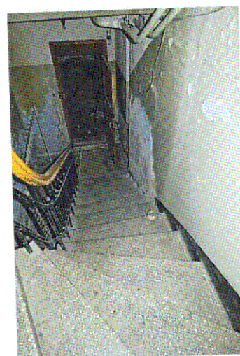
Бетонная лестница Л-5
