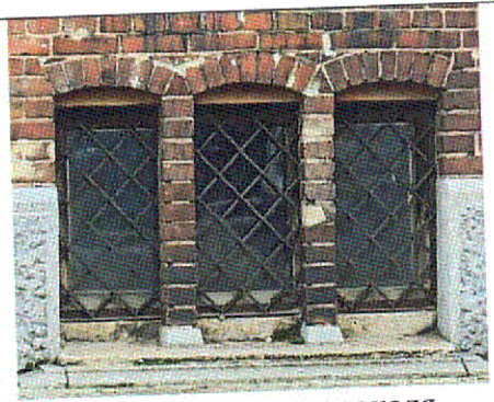
Оконные проемы цоколя (уличные фасады)
