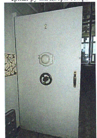
Металлическая дверь сейфа (пом. 1.18). Внешняя сторона
