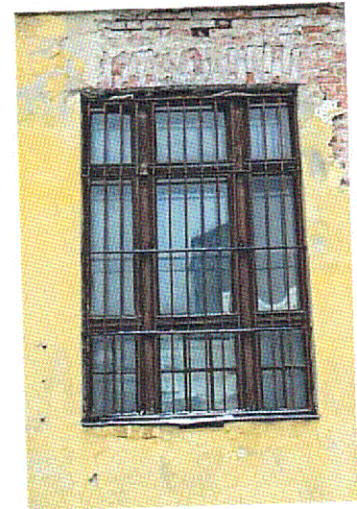
Оконный проем 1-го этажа, Ю-В дворовой фасад
