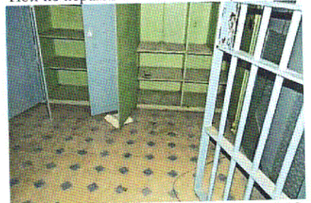
Пол из керамической плитки (пом. 1.12, 1.14, 1.17, 1.25, 1.26)
