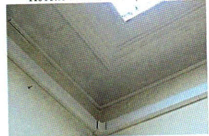
Потолочная галтель (пом. 2.5)
