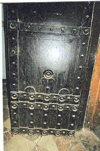
Полотно двери с внутренней стороны. Нижняя часть.
