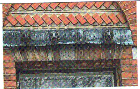
Замковый камень (проемы 2-го этажа, Ю-3 фасад)
