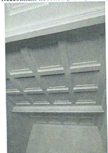
Кессонный потолок (ЛК-2, промежуточный этаж)
