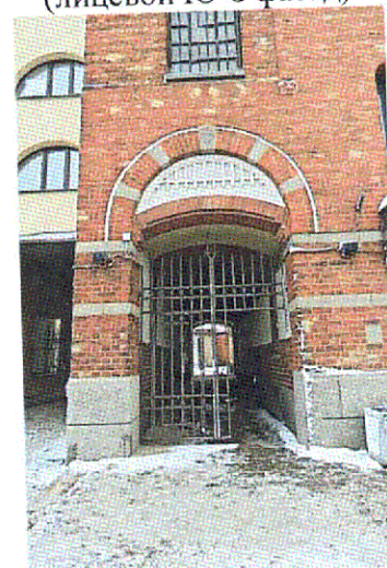
Арочный проезд (С-З фасад)
