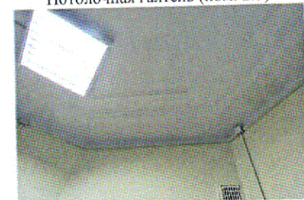
Потолочная галтель (пом. 2.6)
