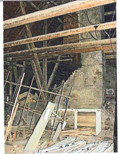
Чердак. Фото 2009 г.
