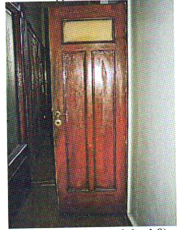
Дверь (между пом. 1.6 и 1.8)
