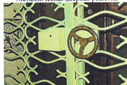
Металлическая дверная решетка (пом. 1.24). Фрагмент
