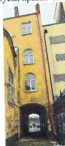
Фрагмент Ю-В фасада
