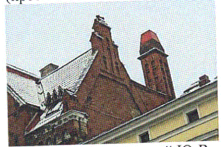
Щипец брандмауэрной Ю-В стены и вентшахты
