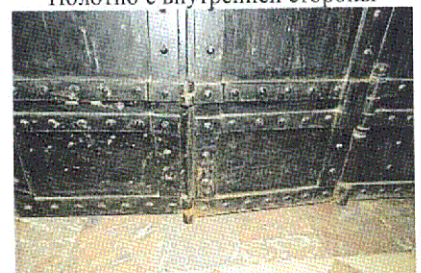
Металлические двери (пом. 1.4). Фрагмент.
