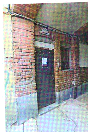
С-В стена арочного сквозного проезда. Фрагмент
