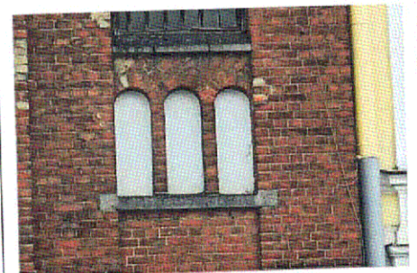
Ложные проемы, Ю-З фасад
