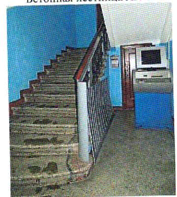
Бетонная лестница ЛК-2
