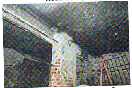
Плоское перекрытие по ребрам (подвал, пом. 0.20)
