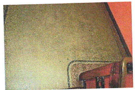
Пол бетонный мозаичный (ЛК-1, 2-ой этаж)
