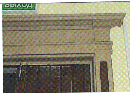
Карнизы проемов (пом.2.5)
