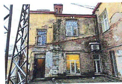
С-В дворовой фасад (верхние ярусы)
