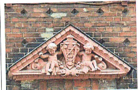
Сандрик оконного проема, 1-ый этаж, Ю-3 фасад
