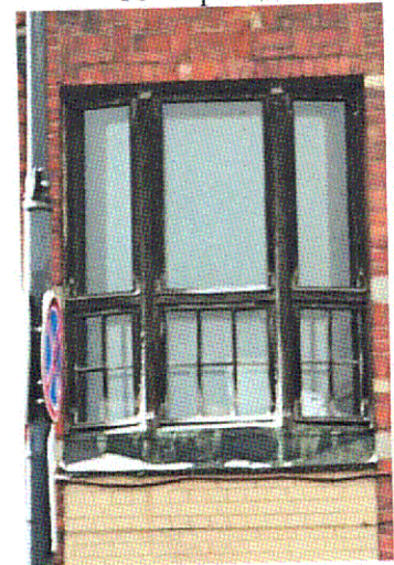
Оконный проем, 1-ый этаж, С-3 фасад
