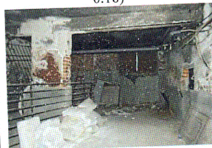
Опорные столбы (подвал, пом. 0.20)
