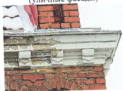
Венчающие карнизы (уличные фасады)
