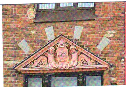
Сандрик оконного проема, 1-ый этаж, С-3 фасад
