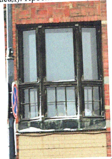
Оконный проем, 2-ой этаж, С-3 фасад
