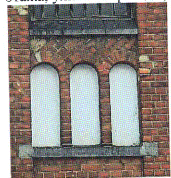
Гранитные подоконные пояса и карнизы (Ю-3 фасад)
