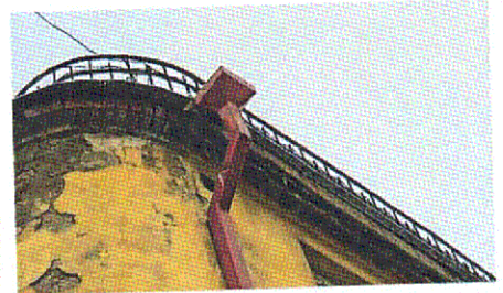
Карниз (трехэтажная дворовая часть здания)
