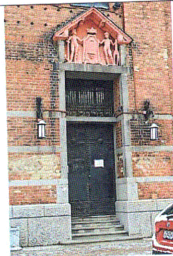
Портал парадного входа (лицевой Ю-З фасад)
