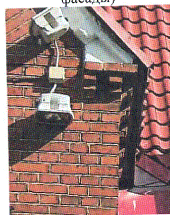
Венчающий карниз надстроенного объема щипца
