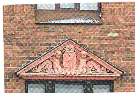
Сандрик оконного проема, 1-ый этаж, С-3 фасад
