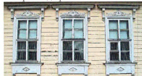
оконные проемы лицевого фасада
