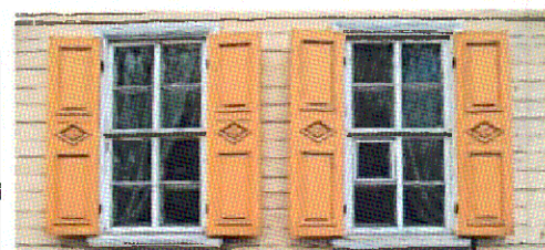
оконные проемы дворового фасада
