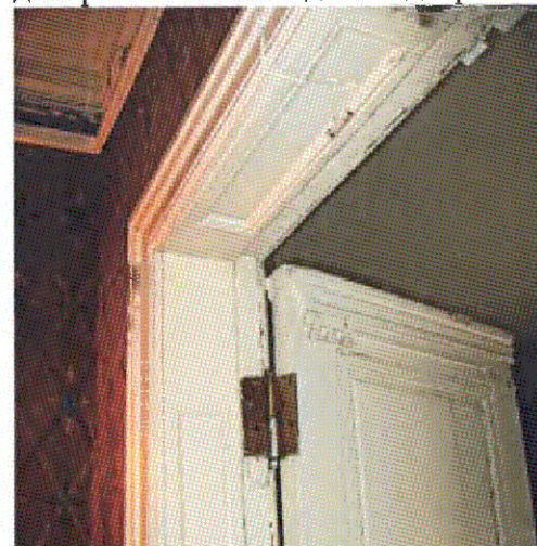
обработка дверных откосов
