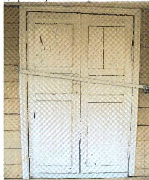
дверной проем северо-восточной пристройки
