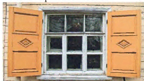
ставни на окнах дворового фасада
