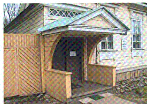
козырек над проемом Вх 1
