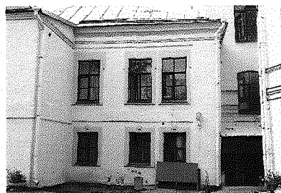
Ю-В дворовой фасад
