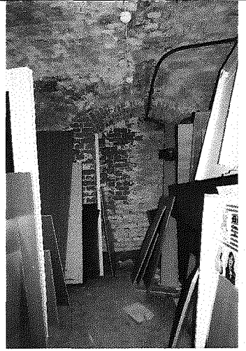
Арочный проем, подвал (пом. 3)
