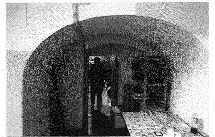
Арочный проем, подвал (между пом. 4 и 5)
