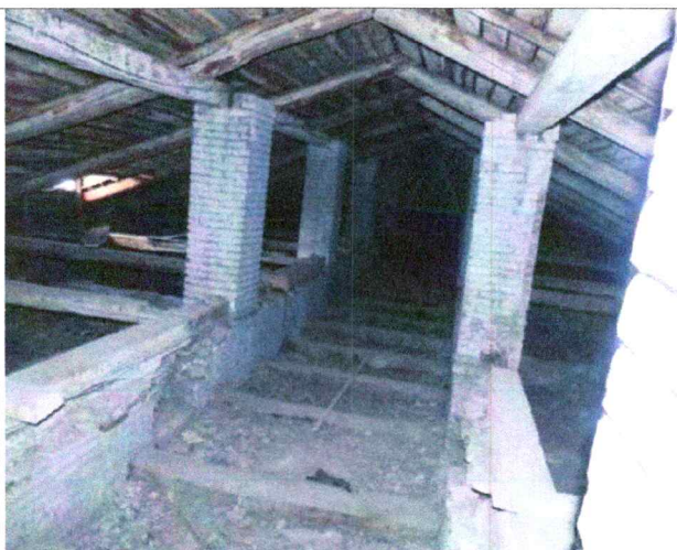
стропильные конструкции – деревянные, покрытие кровли – тонколистовая сталь;
