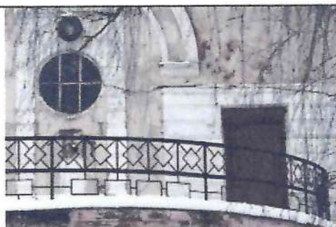
Фрагмент второго этажа северо-западного фасада
