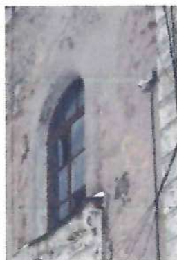
Оконное заполнение оконного проема с арочной фрамугой
